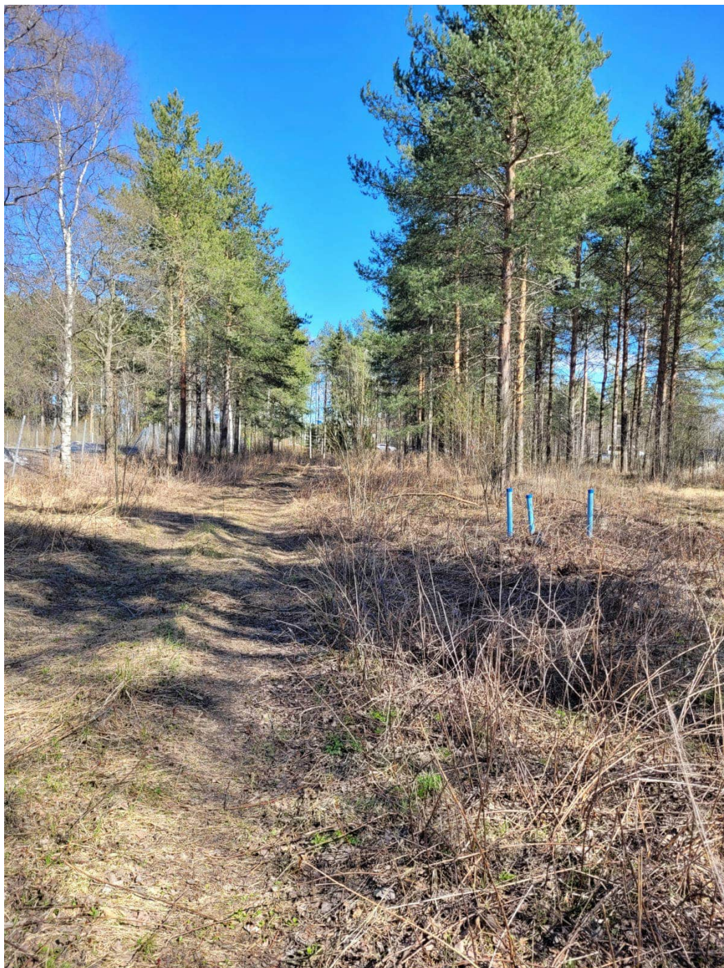
Kuva7, Alueelta kaadettua puustoa jätevesilinjan ja vesijohdon vuoksi.
