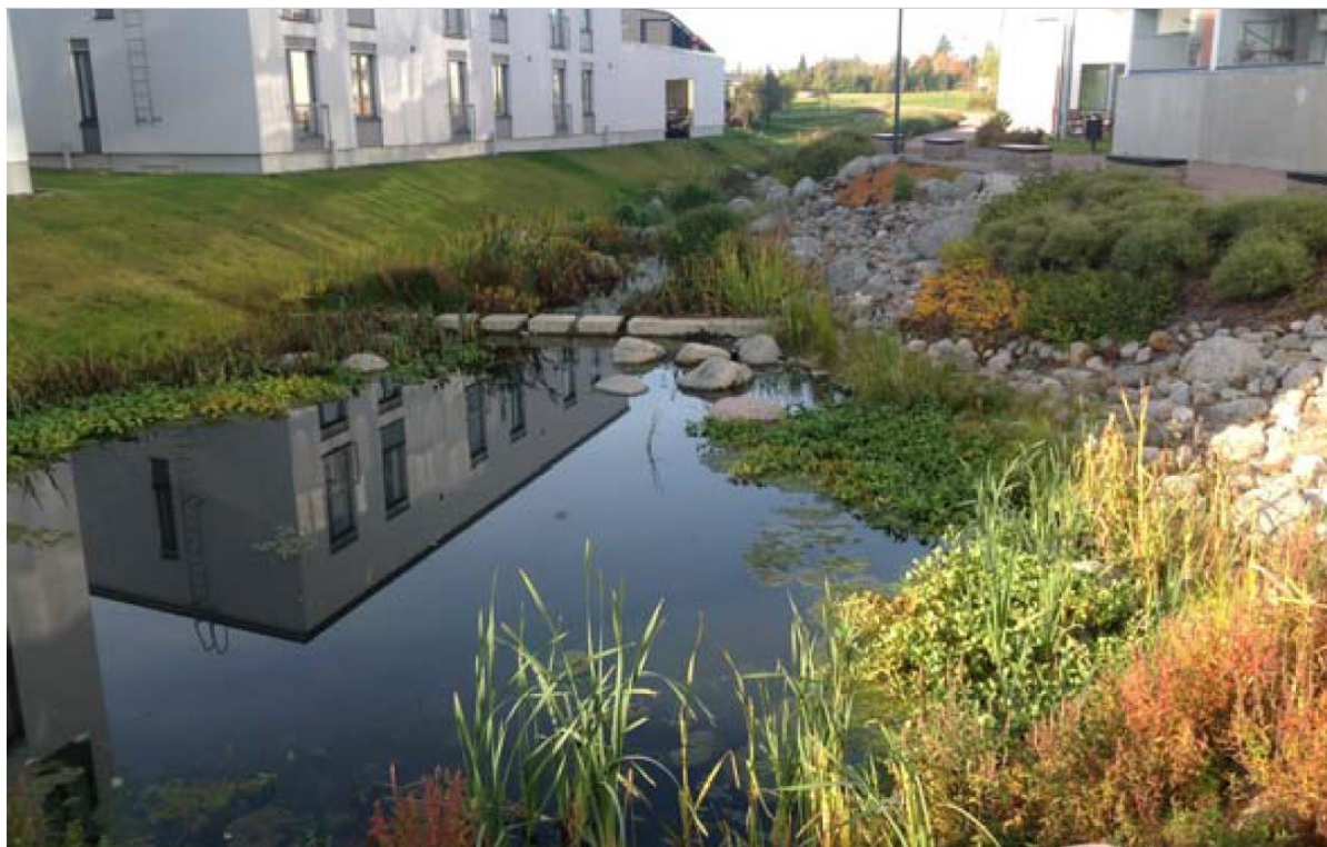
Kuva 14. Biosuodattava hulevesipainanne/kosteikko voi olla osan aikaa vuodesta kuivana, joten kasvit on valittava sen mukaisesti, että ne kestävät vesipinnan vaihteluita. Kuva: Vantaanjoen ja Helsingin seudun vesiensuojeluyhdistys ry.
