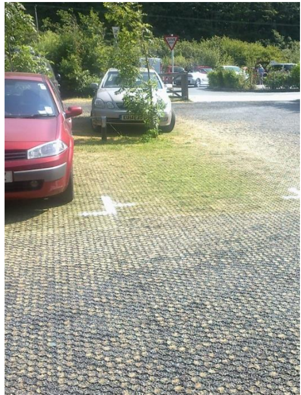
Kuva 9. Muovisella vahvikekennolla tuettuja pysäköintialueita. Kennoa voidaan käyttää vahvistamaan sorapintaa (oikea kuva) tai kenno voidaan vähemmän liikennöidyllä alueella nurmettaa (vasen kuva).
