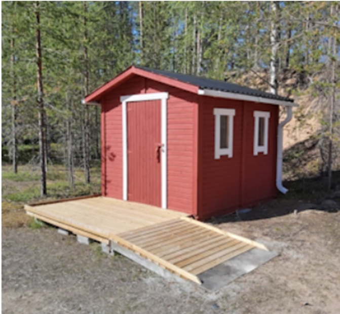
Kuva. Esteetön wc
