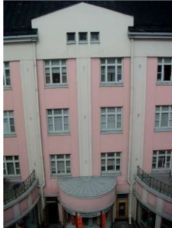
Pakkahuoneenkadun julkisivu Arinasta katsottuna
