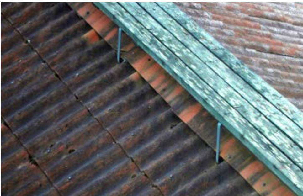
43. Juhlasaliin Minerit -vesikate ja puurakenteinen kattosilta.
