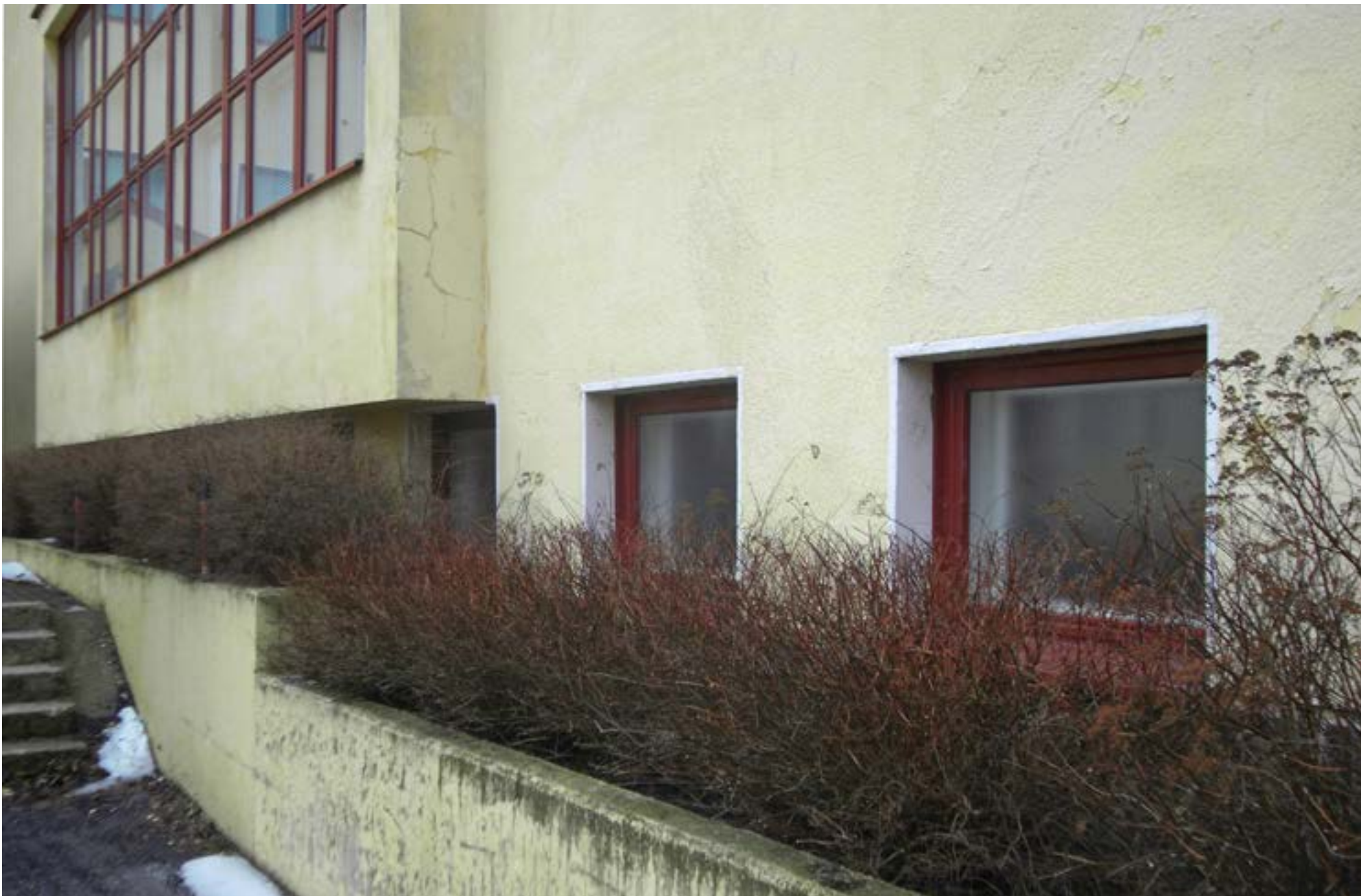
66. Yksityiskohta juhlasaliin julkisivusta. Vuosien 1986-87 peruskorjauksessa pääsisäänkäynnin pihan sokkelien vierustoille toteutettiin betoniset istutusaltaat. Rappaus- ja betonipintojen maalauskäsittelyt ovat heikkokuntoiset. Rappaukset ovat useassa kohtaa halkeilleet. Rappauksia ei peruskorjauksessa uusittu, vaan ne paikkakorjattiin ja ylimaalattiin.
