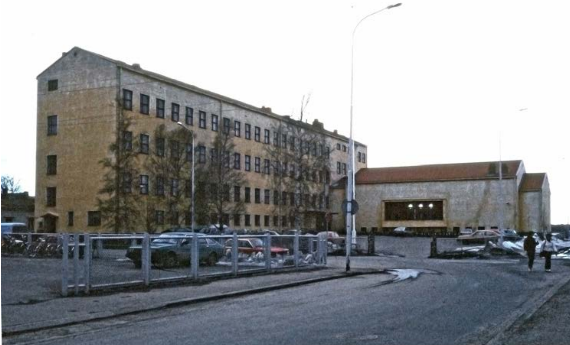
45. Koulurakennus valokuvattuna keväällä 1984. Julkisivut olivat päässeet heikkoon kuntoon. Kalkkipohjainen pintamaali oli peseytynyt pois laajoilta alueilta. Juhlasalisiivessä näkyy pitkä pystyhalkeama, joka oli näkyvillä jo tuoreeltaan vuonna 1957 (kuva 37).
