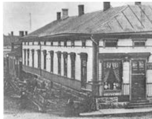
Hirsintien koulun rakennuksen sijasta, Pakkalanpuolelta ja Kivikadun kulkemista (nykyinen paikalla Arina-Solus) koulu toimi vv. 1891–98.
