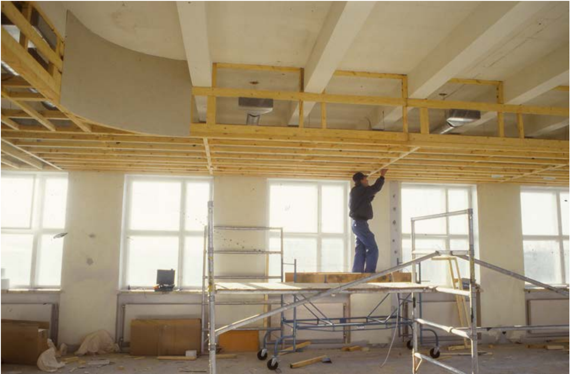
56. Sisätiloihin toteutetaan kipsilevystä alaslaskukattoja.
