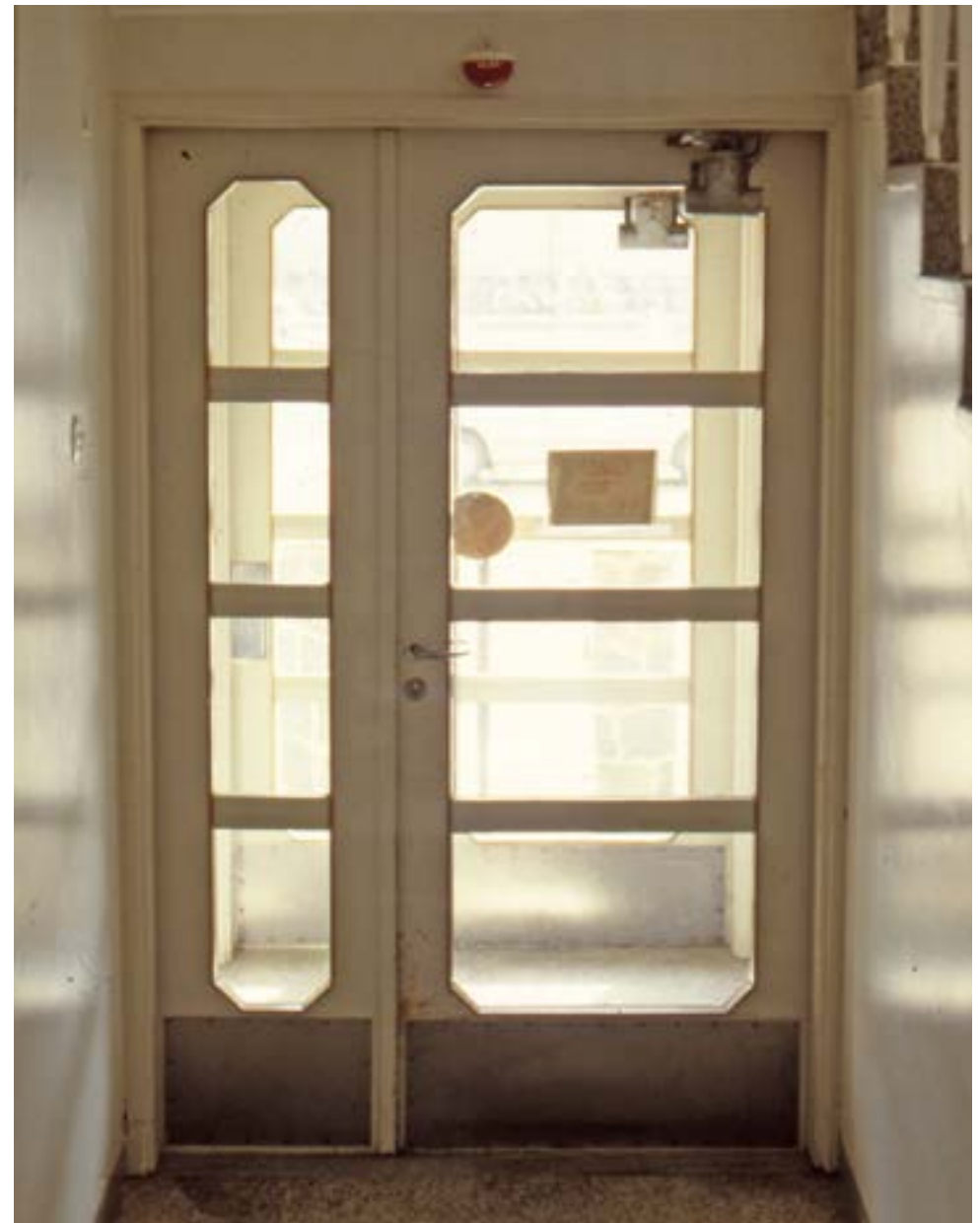
51. Ulko-ovet ja tuulikaappiovet uusittiin peruskorjauksen yhteydessä. Kuvassa alkuperäinen keittiöön ja talonmiehen asuntoon johtava sisäänkäynti. Ikkuna-aukoituksen viistetyt kulmat toistuvat rakennuksen sisäovissa.
