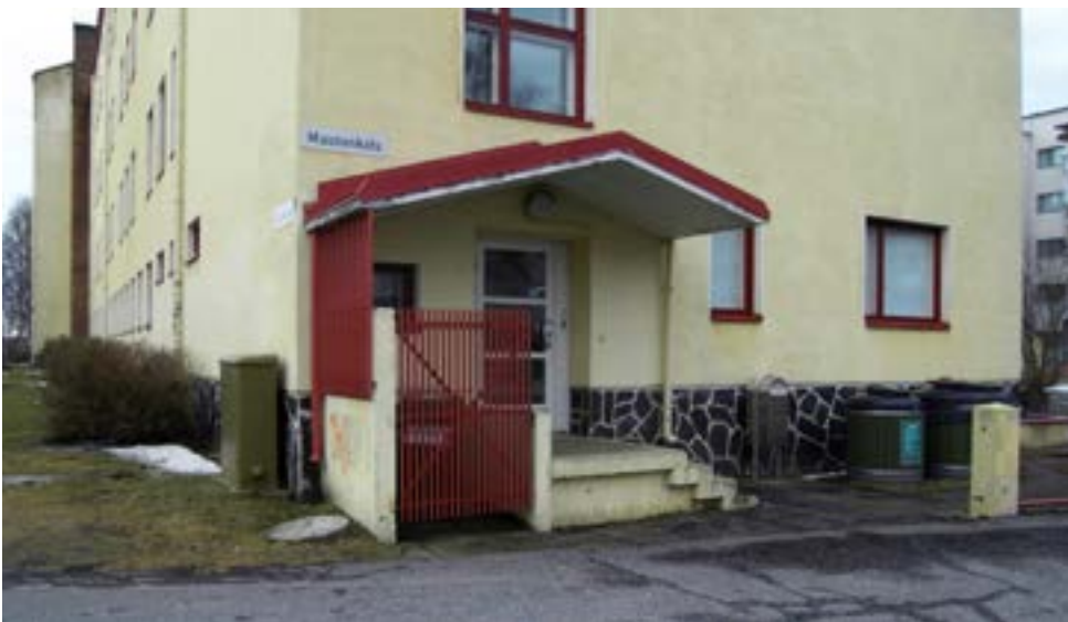
64. Alkuperäinen sisäänkäynti keittiötiloihin ja talonmiehen asuntoon palvelee edelleen samassa tarkoituksessa. Katos, portaat ja kaiderakennelma ovat kaikki uusia rakenteita peruskorjauksen ajoilta.
