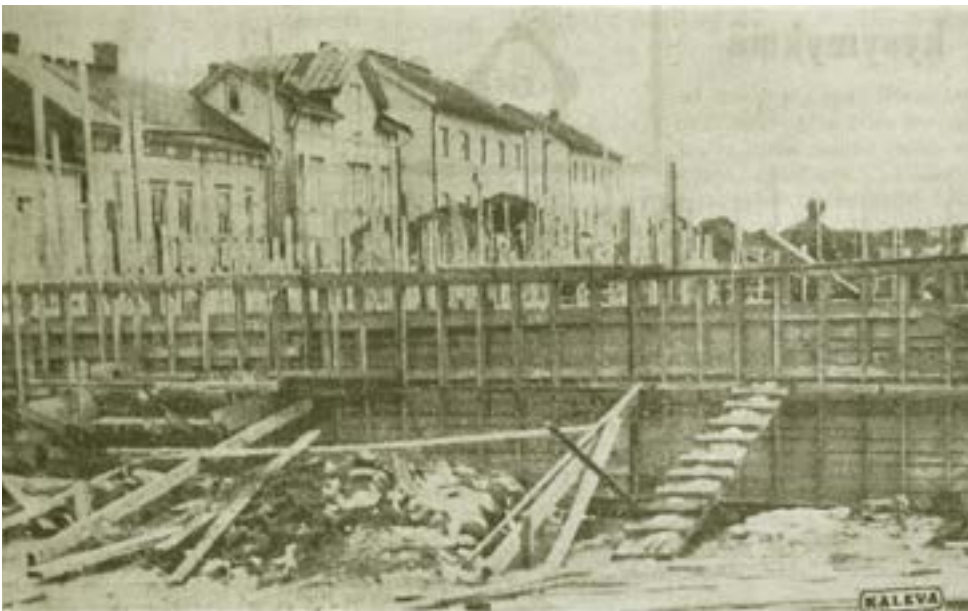
26. Sanomalehti Kalevassa 19.11.1955 ollut kuva koulurakennuksen työmaalta. Kuvassa perustustöiden muottirakenteita. Taustalla Kuusiluodon asuinrakennuksia.
