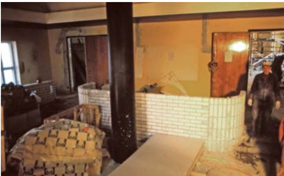
50. Juhlasalisiiven lämpioon toteutettiin peruskorjauksessa uusia kaiderakenteita kahi-tiilestä, jotka viimeisteltiin ylitasoittamalla valkoiseksi.
