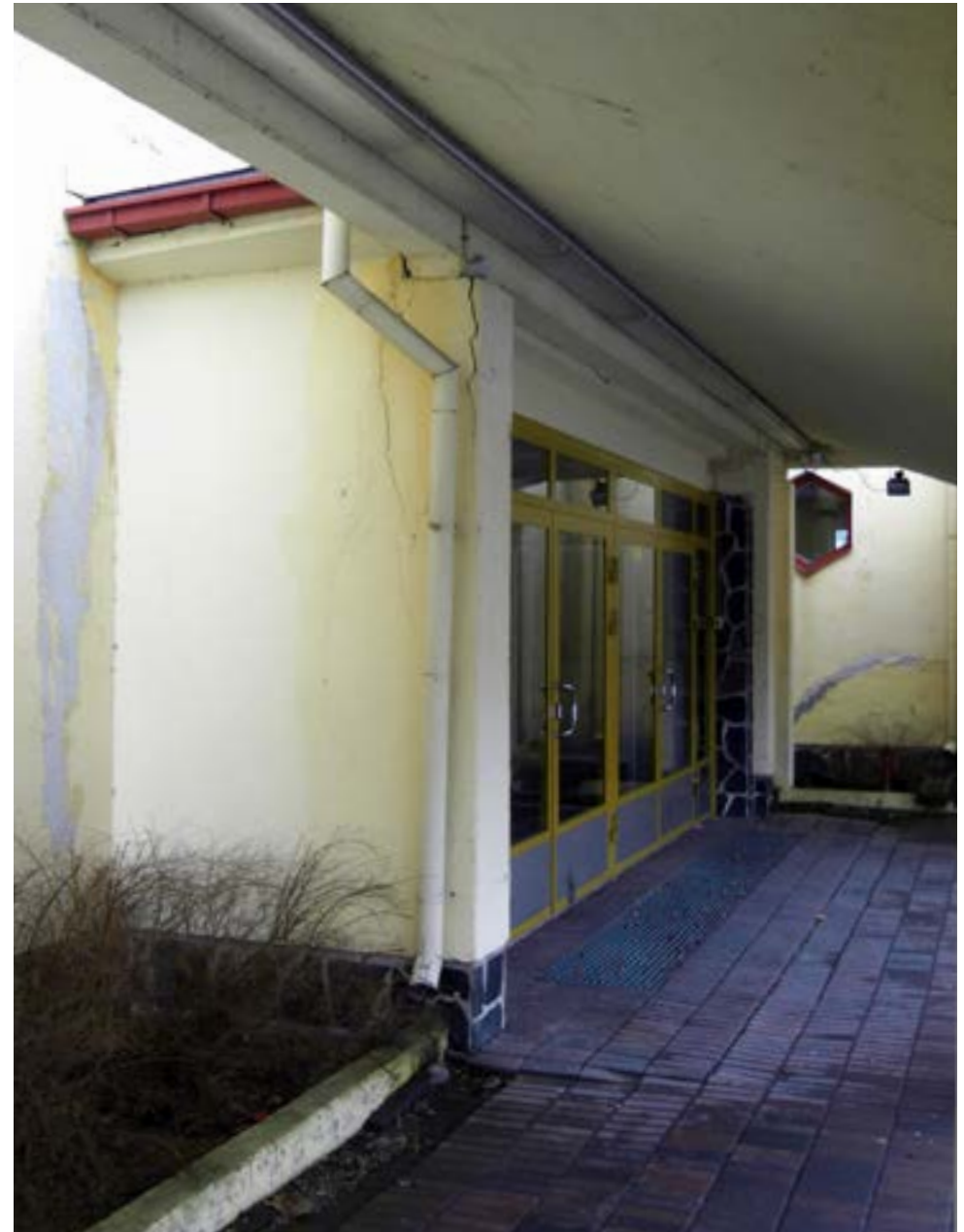
63. Pääsisäänkäynnin tuulikaapin alkuperäinen betonirakenteinen lipa purettiin peruskorjauksessa ja tilalle toteutettiin laajempi sisäänkäyntikatos. Taustalla uusi kuusikulmainen puuikkuna juhlasalin lämpiöön.
