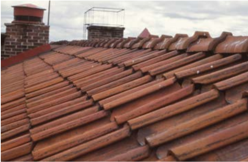
60. Koulusiiven savitiilikateen vaurioituneet tiilet uusittiin ehjiin. Juhlasaliin vuosina 1976-77 uusittu Minerit-vesikatemateriaali säilytettiin myös.
