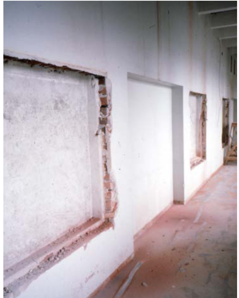
54. Koulusiiven pitkien käytävöiden seinäpinnoissa oli alkujaan syvennyksiä, jotka toimivat vitriini- ja kalustesyvennyksinä. Syvennyksistä osa on tallella, niiden ympärille on toteutettu lasi vitriiniejä ja opiskelijoiden henkilökohtaisia säilytyskappeja.
