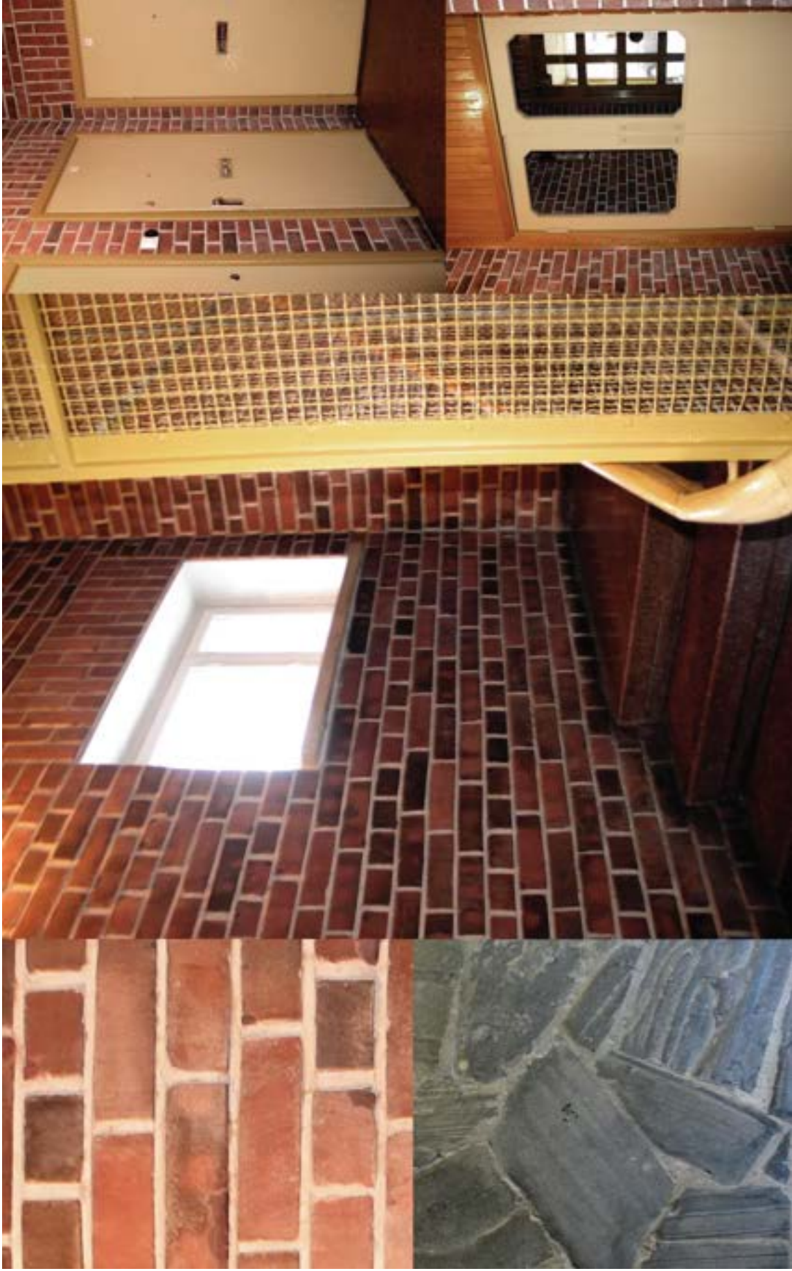
Kuva 115. Kuvia rakennuksen porraskäytävästä 2004.
