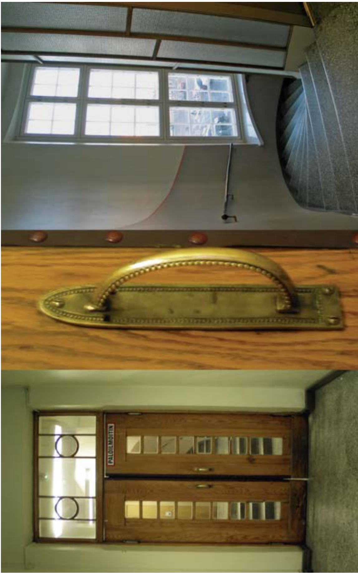
Kuva 133. Rakennuksen porraskäytävä syksyllä 2004.
