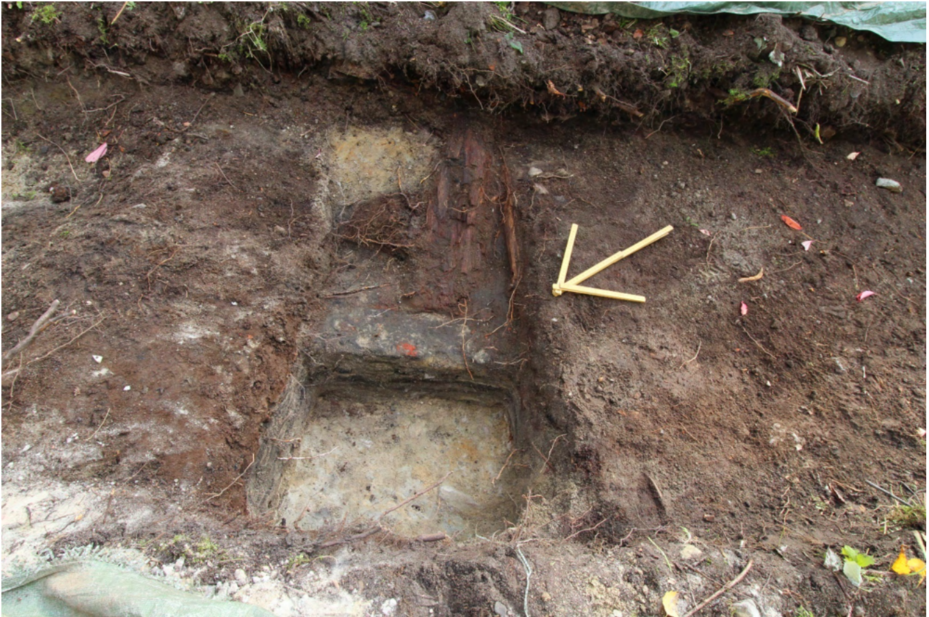
AKDG6955:28. Koekuoppa 10 kaivettuna pohjaan. Kuopan yläosassa rakennepuut R40 ja alaosassa syvempi koepisto, joka ulottuu pohjamaahan Y1000. Luoteesta. Kuva: Terhi Taipaleenmäki.
