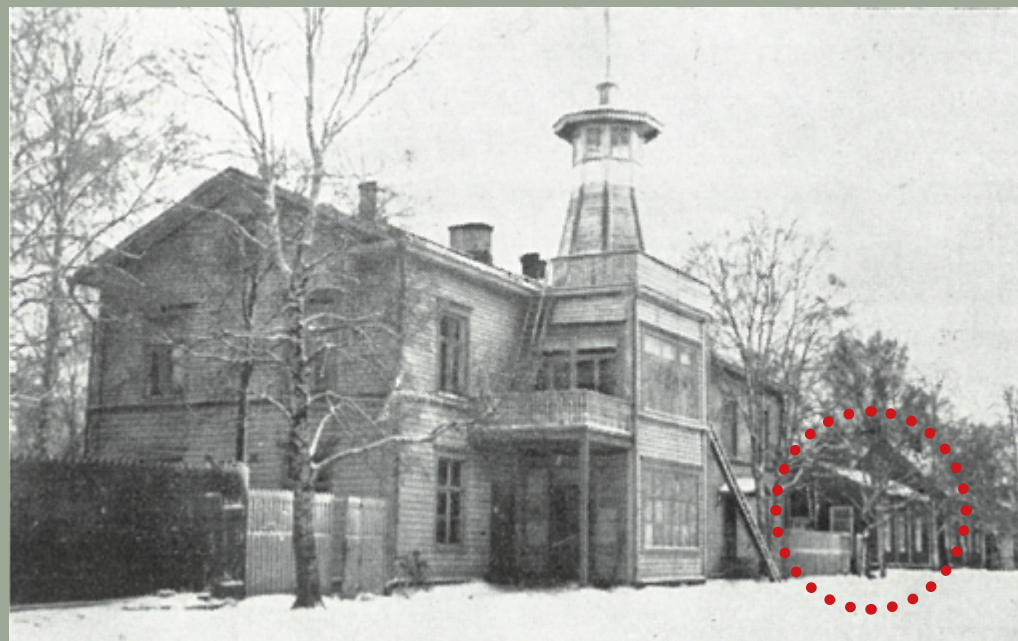
56. Kuvassa etualalla Konepajan konttori, jonka jälkeen tien varrella kohdetontin 19 rakennuksia. Kuva: Outakoski, 1949. s.33 /Sanomalehti Kaleva. Selvityksen tekijä on merkinnyt rakennuksen 5A punaisella pisteiviivalla.
