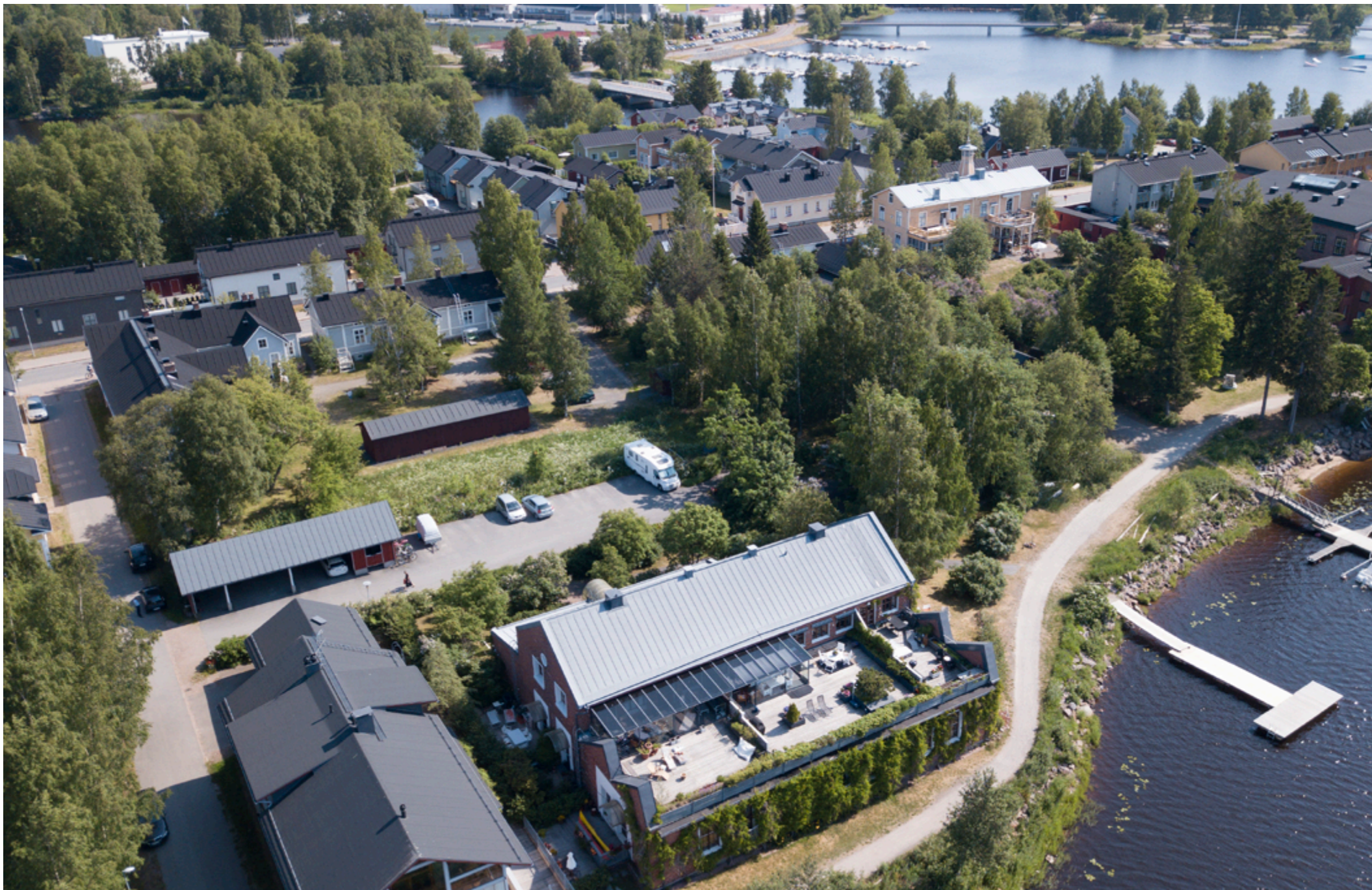
141. Kohdetontti ja kortteli 6 ilmakuvassa kesällä 2020 . Kuva: Sivakka Oy, 2020
