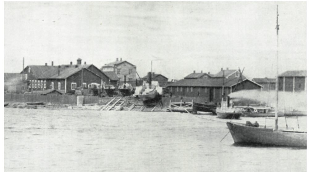
18. Oulun Konepaja Oy:n tehdasalue noin vuonna 1885, ennen kyseisenä vuonna tapahtunutta tulipaloa. Kuvassa on näkyvissä myös konttorirakennus, jonka rakennuspiirustukset on päivätty vuonna 1885. Kuva: Outakoski, 1949. s. 27.
