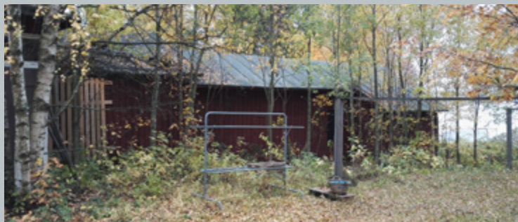
101. Valimokadun varren talousrakennusten rannan puoleinen osa pihan puolelta kuvattuna vuonna 2020.
