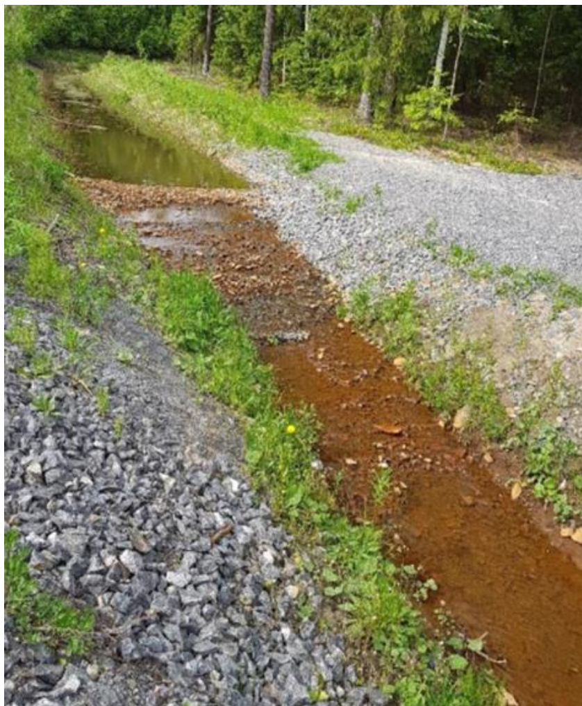
Kuva 6.3 Esimerkki suotopadosta viivytysojastossa
