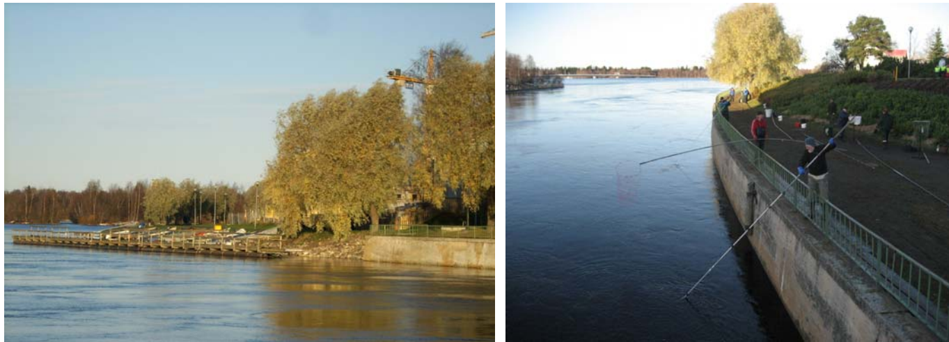
Kuvat 4 ja 5. Kalastusrakenteita joella, lippoaiaa kalastamassa syksyllä 2008
