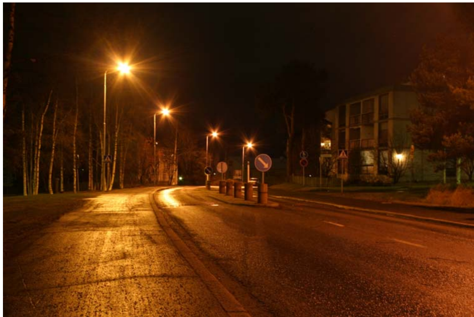
Kuva 8. Koskitien valaistus on toteutettu suurpainenatriumlampuilla
