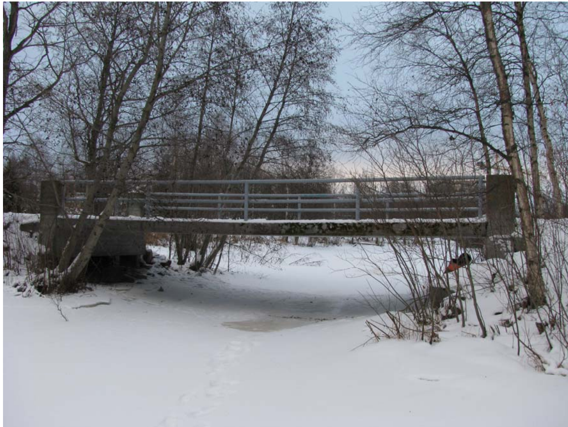
Sillan sivukuva alavirran puolelta
