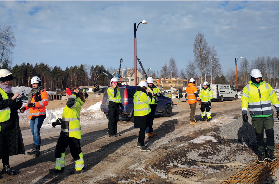
Työmaakäynti 20.3.2024 / Riikka Mämmioja, Oulun kaupunki
