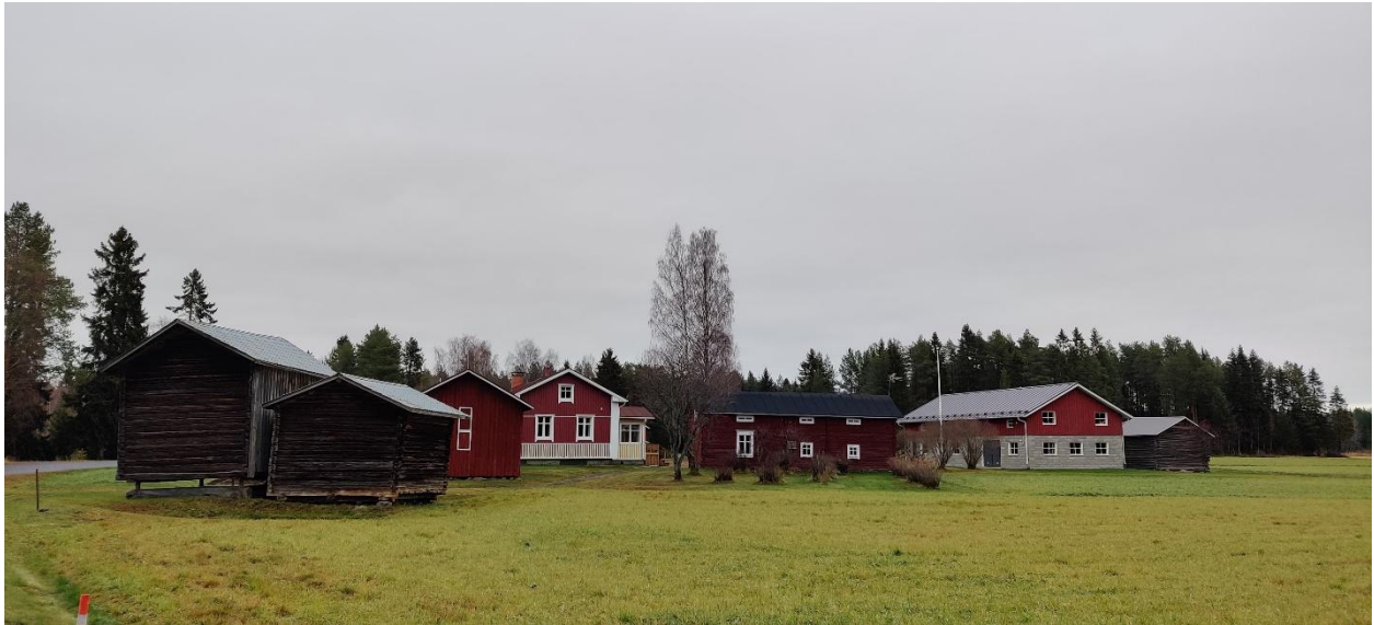
Kuva 6. Valokuva Törmälän pihapiiristä, jonne on suora näköyhteys asemakaavamuutosalueelta. Valokuvattu syksyllä 2022. © Oulun kaupunki
