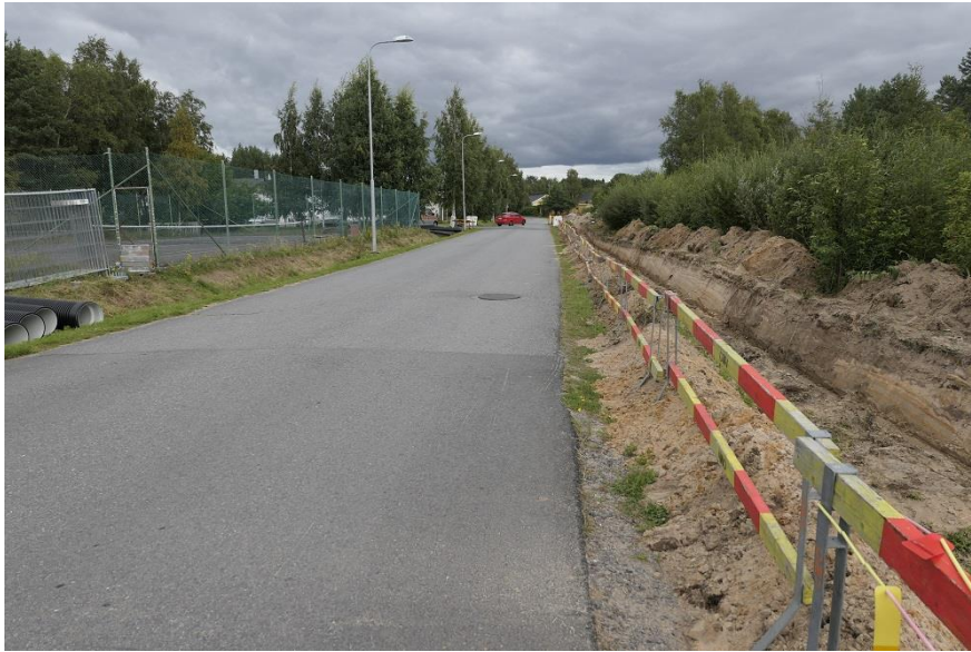
Kuva 7. Vuoden 2002 ahonoidanlukon havaintopaikka on jäänyt pensaikon ja kaivuutyömaan alle.
