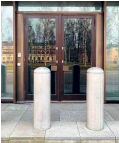
Kajaaninkadun puolen julkisivu.
