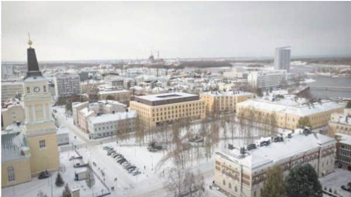
Kuva 8: JKMM-arkkitehtien kuva, mistä käy ilmi miten suojaltua Suomen pankin rakennusta oltaisiin muuttamassa täysin tunnistamattomaksi. Kuvasta näkee miten kulttuurihistoriallisesti arvokas miljöö on kärsinyt massiivisesta rakennuksesta. Vieressä oleva Franzenin talo on "kutistunut" ja Pokkitörmän maamerkinä toimiva Kolmiotalo on jäänyt täysin korkeamman ja masiivisemmän rakennuksen "varjoon".
