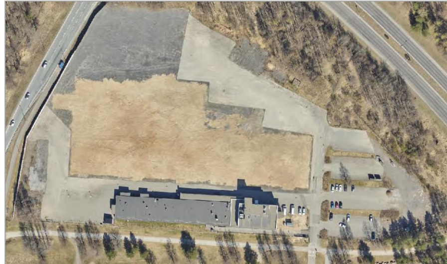
Kuva 21: Ilmakuva kohteesta vuodelta 2025, jossa nähtävissä nykyiset päällystetyt pysäköintialueet ja purkamatta oleva rakennus alueen eteläosalla. Lähde: Oulun karttapalvelu 11/2025.
