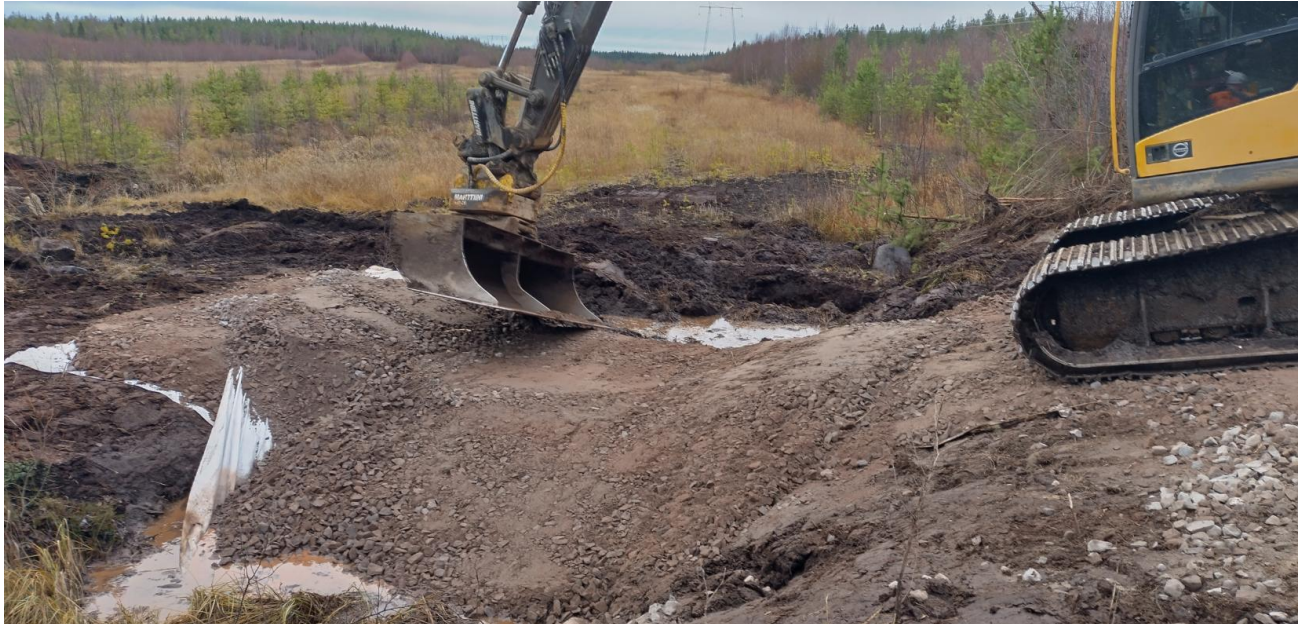
Kuva 10. Pohjapadon harja tehtiin 2 m leveäksi loivilla luiskilla 0–56 mm:n kalliomurskeen avulla.
