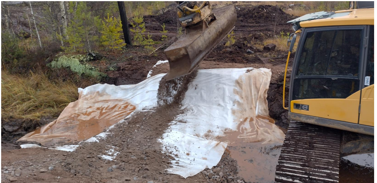
Kuva 9. Uomaan laitettiin N2-käyttöluokan maanrakennuskangas aluksi poikittain ja sitten pitkittäin.
