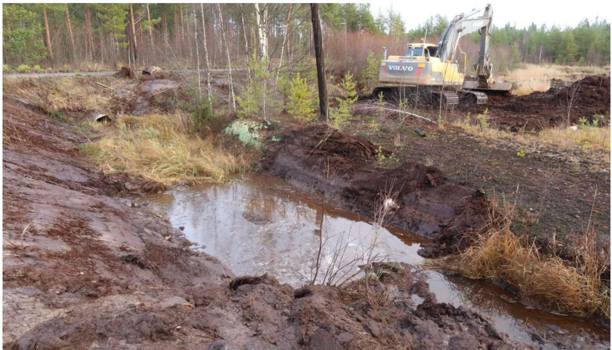
Kuva 8. Pohjapadon kohdan valmistelevia töitä.
