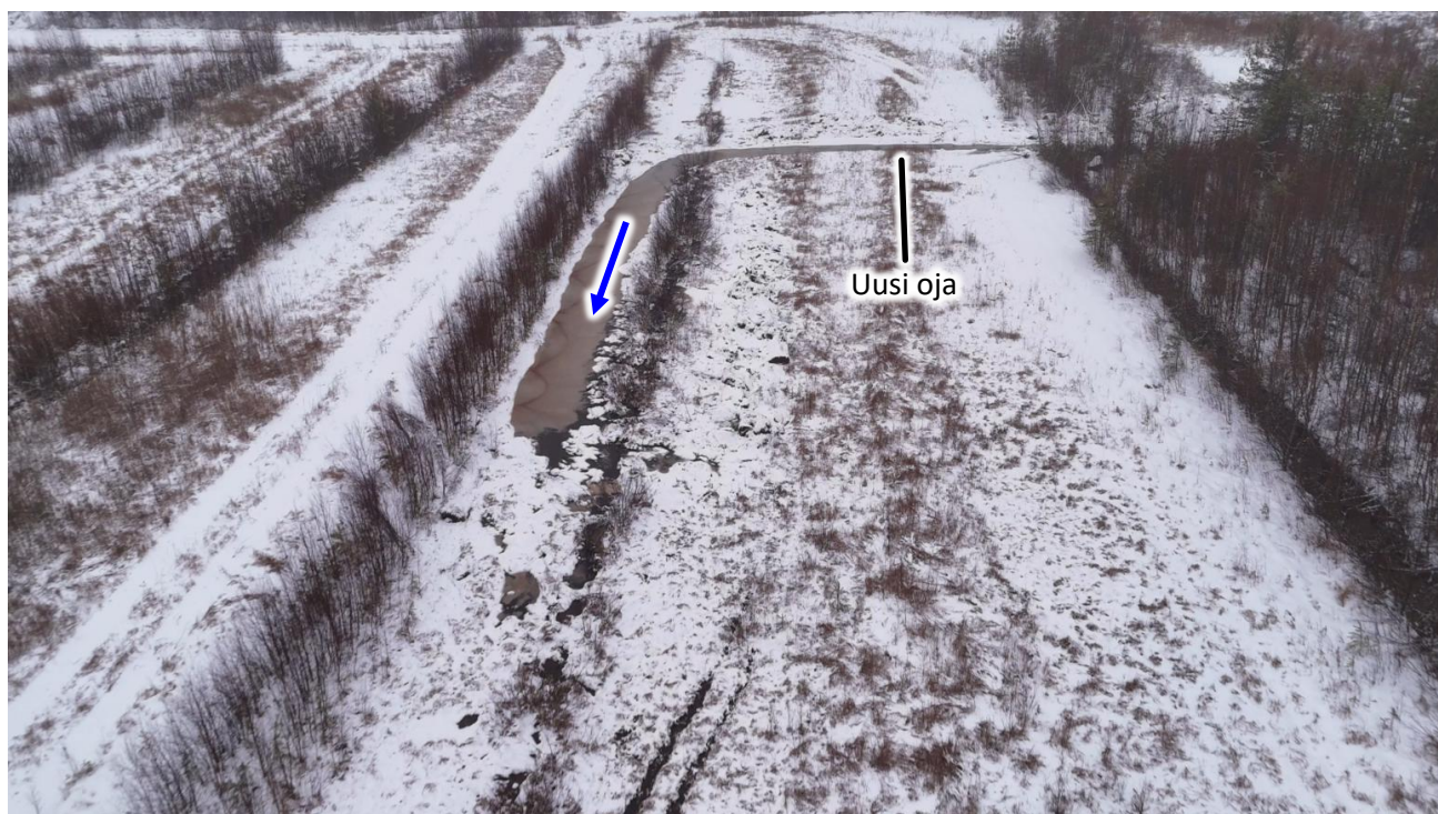
Kuva 21. Lounaisosan eristeojan vedet käännettiin lohkon 9 kautta lohkolle 8.
