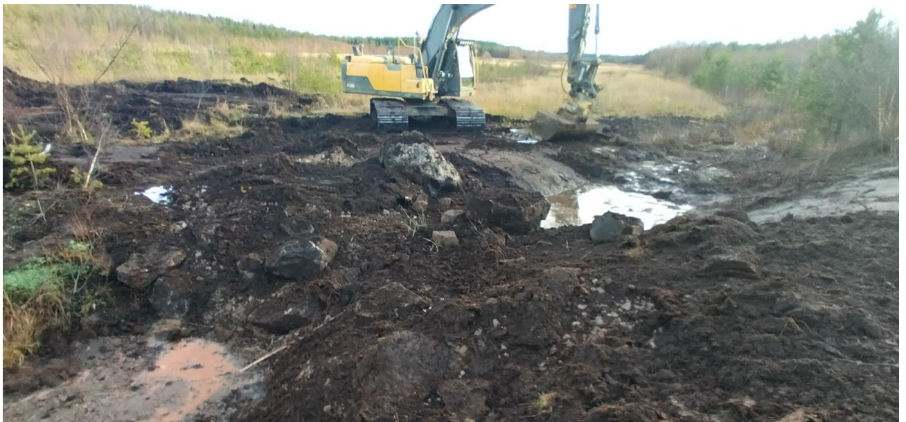
Kuva 11. Pohjapato maisemoitiin kiviaineksen pinnalle varistellulla turpeella sekä isoilla kivillä.
