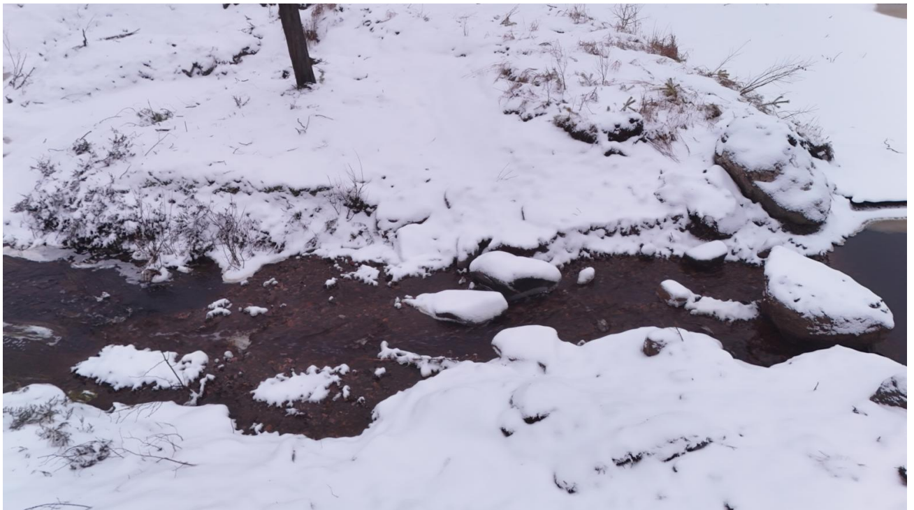
Kuva 19. Pohjapadon rakenne vaikutti pysyneen rakentamisaikaisessa tilassa eikä kiviä ole siirtynyt.
