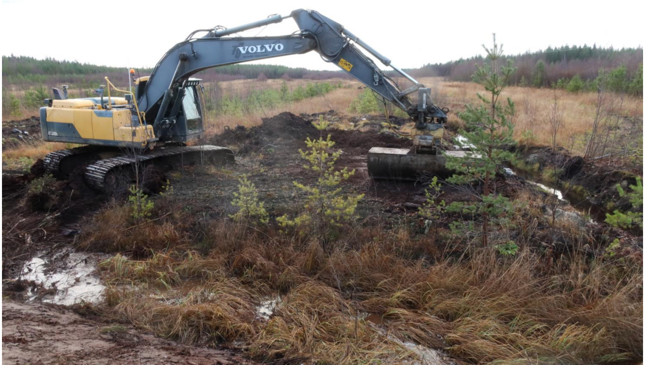
Kuva 12. Aluksi patopenkereen kohdalta poistettiin pintaturpeet saralta ja ojista.
