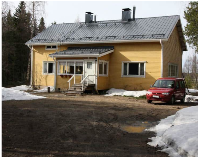
Kuva 15. Kuva Uutelan taiteilijakodista etelästä katsoen (Katriina Bendiksen, 2018).
