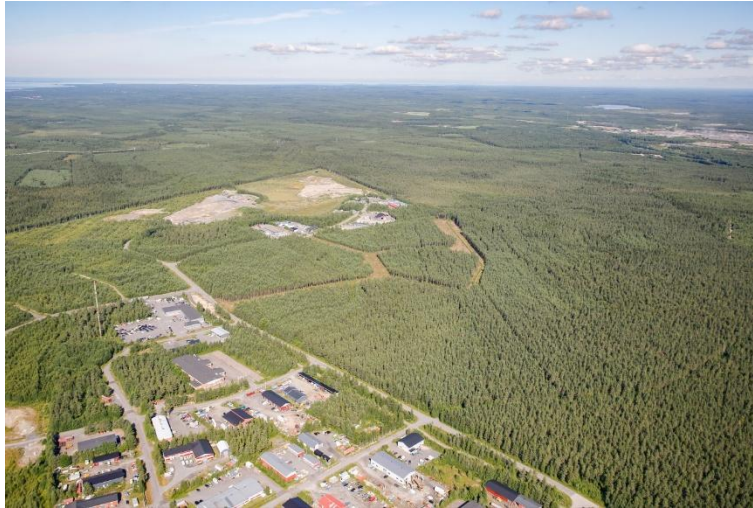
Kuva 2 Pyyryväinen Oulun kaupunki Röni-Kuva Oy 2024.
