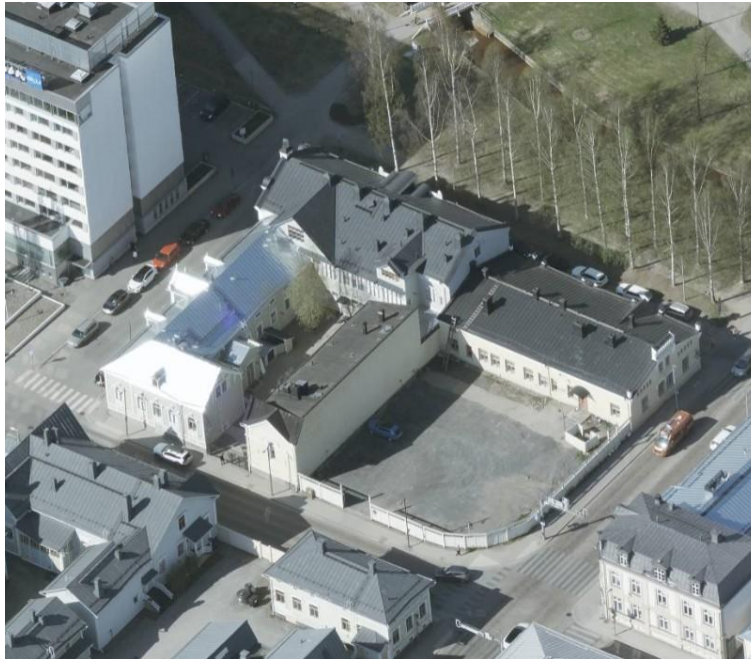
Kuva 23 Ojakatu 2 viistoilmakuva Oulun kaupunki.
