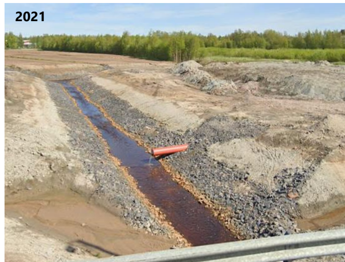
Kuva 10. Oulunportintien jatkeen ympäristön rakennustyöt käynnissä. (Google Maps 2021)
