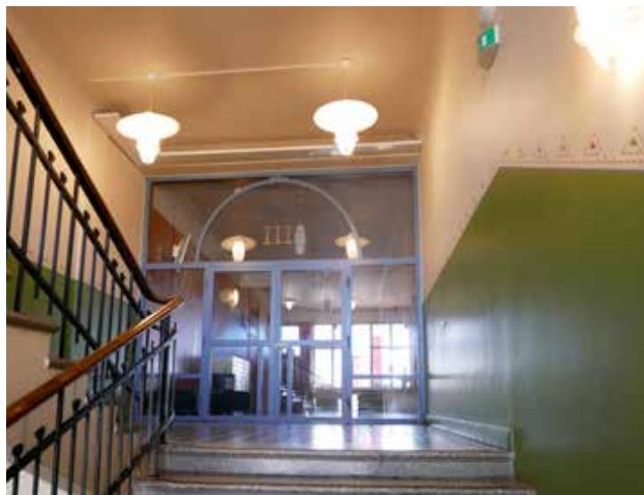
Porrashuoneen ja aulatilojen väliset palo-ovet on asennettu 1980-luvulla.
