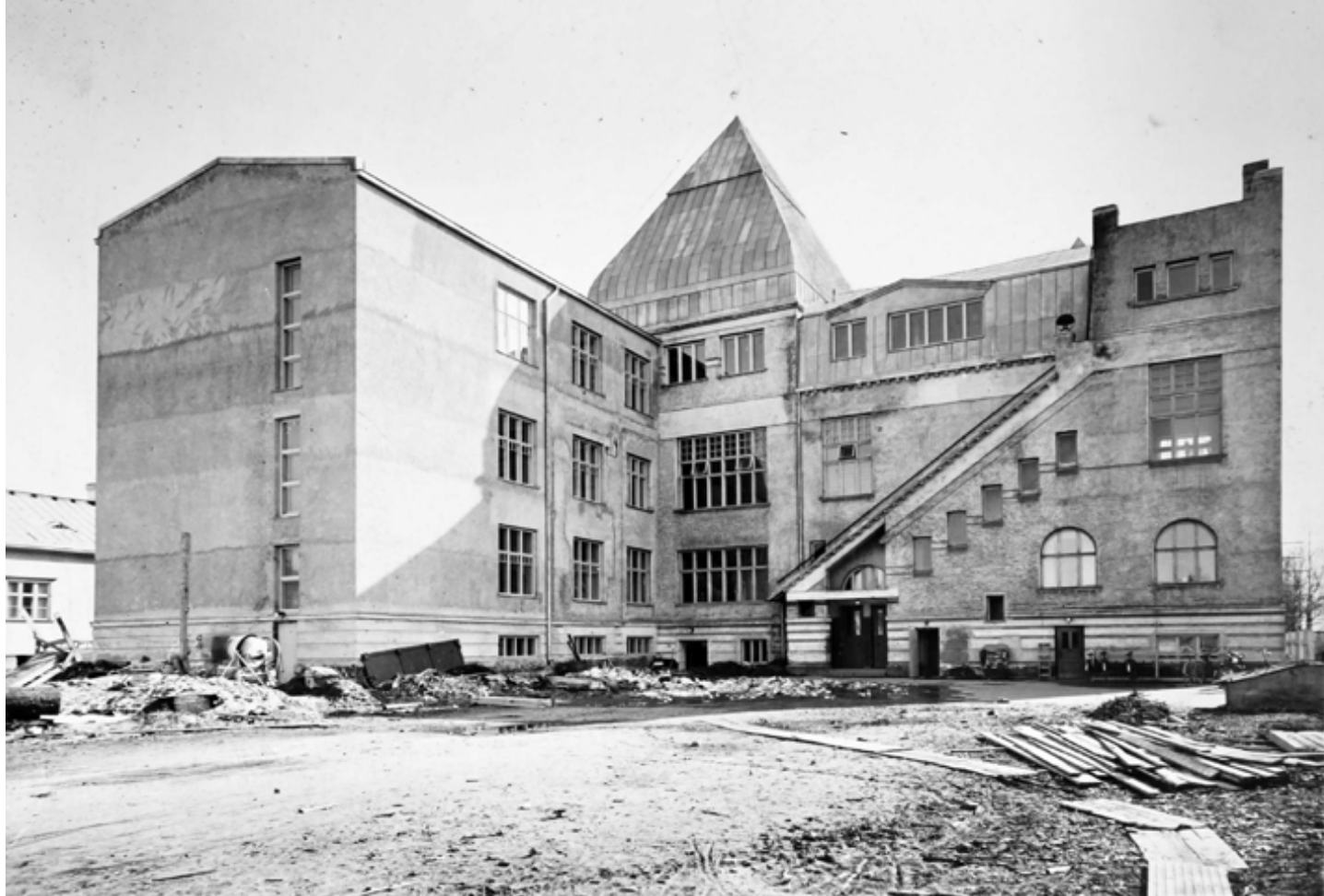
Koulun laajennustyömaa 1955. KA.
