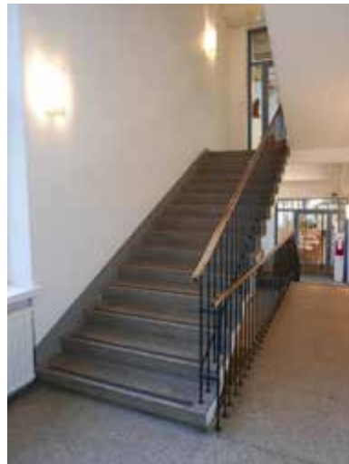
Mosaiikkibetoniportaat ja pinnakaide.
