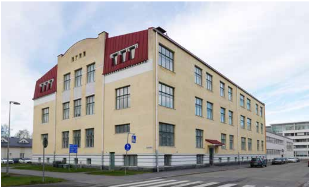
Julkisivut Kuusiluodonkadun ja Nummikadun risteyksestä etelästä.
