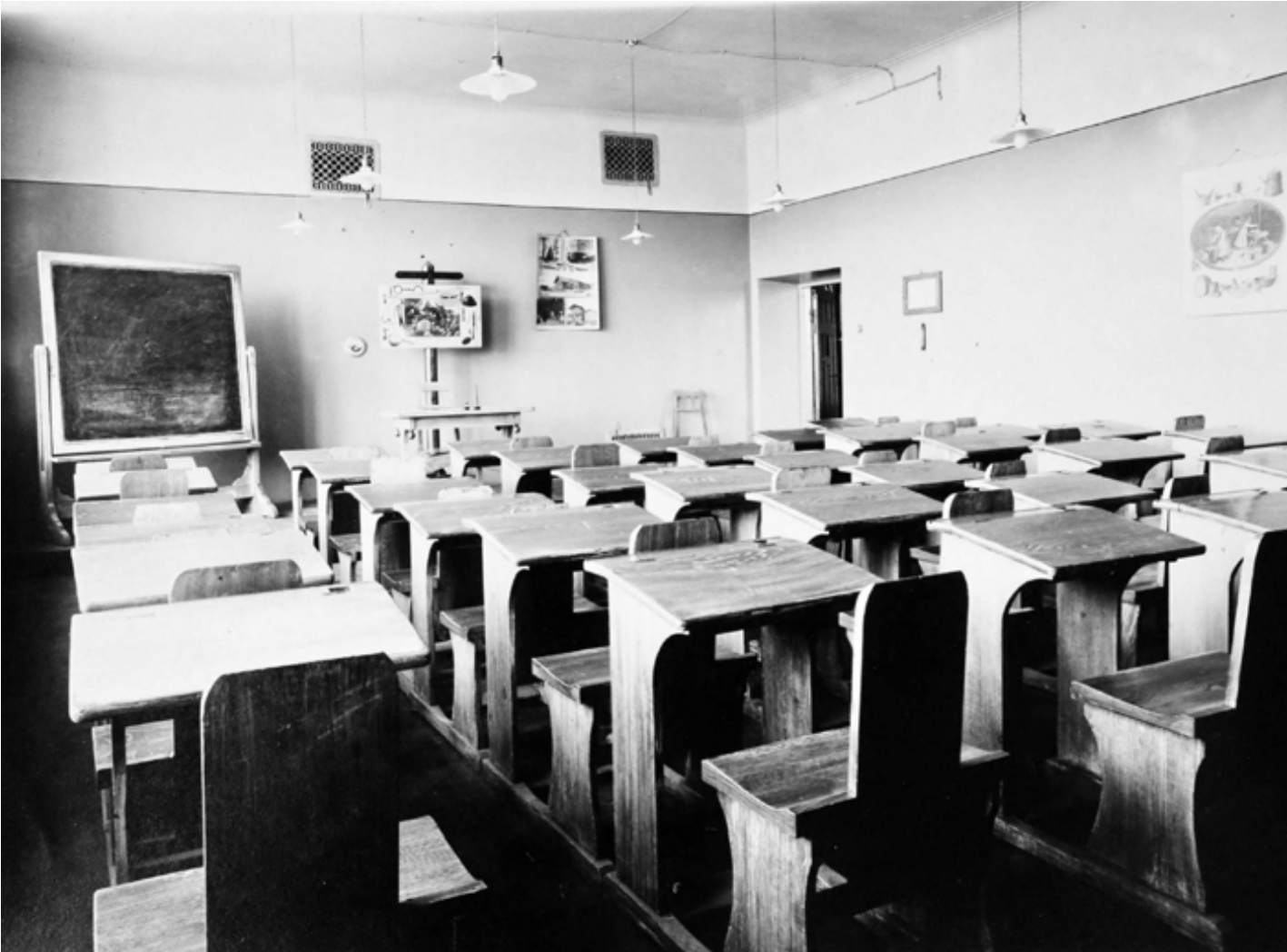
Valokuva luokkahuoneesta. Katosta riippuu hyvin yksinkertaiset, pienillä opaalisivarjostimilla varustetut valaisimet. Seinän yläosa ja sisäkatto oli väritetty vaaleammaksi kuin alaosa. Värikyksen vaihdoskohdassa näkyy ohut tummempi maalattu nauha. Kuva n. 1908-1920. KA.
