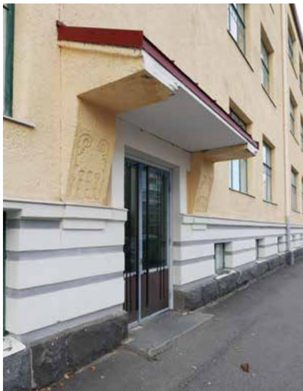
Kuusiluodonkadun puoleinen sisäänkäyntikatoks.
