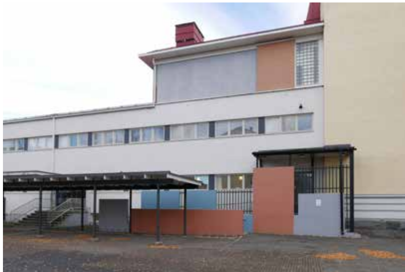
Korjauksessa tehtiin uusi esteetön luiska ja sisäänkäynti sekä rakennuksen katolle ilmastokonehuone. Lisäyksissä käytettiin tehostevärejä ja lasitiilipintaa.
