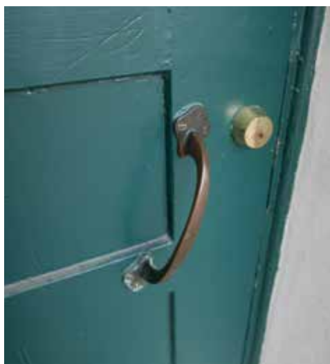
Pääsisäänkäynnin ulko-oven jugend-vedin.
