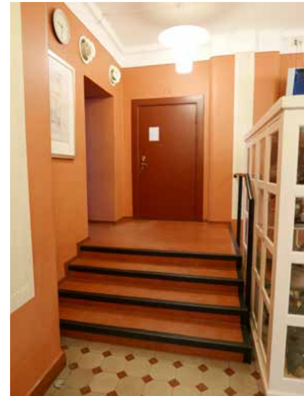
Ikkunan tilalle on asennettu muutoksissa laakaovi. Myös aukon kohdalla on ollut laajempi ikkuna.
