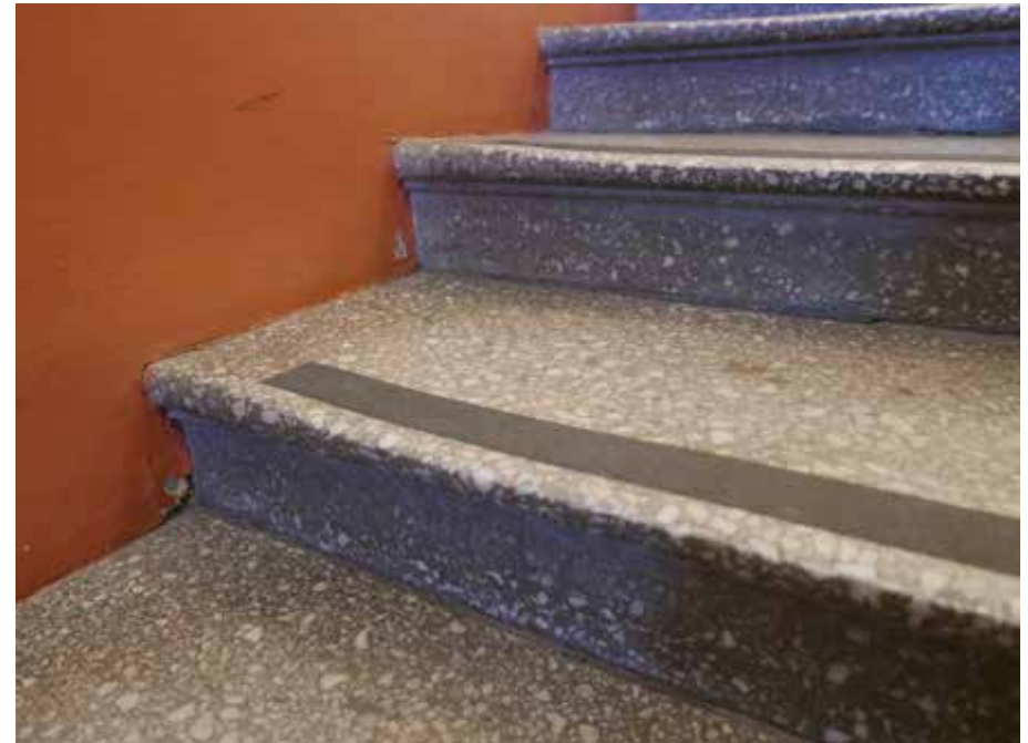
Mosaiikkibetoniaskelmat ovat alkuperäiset.
