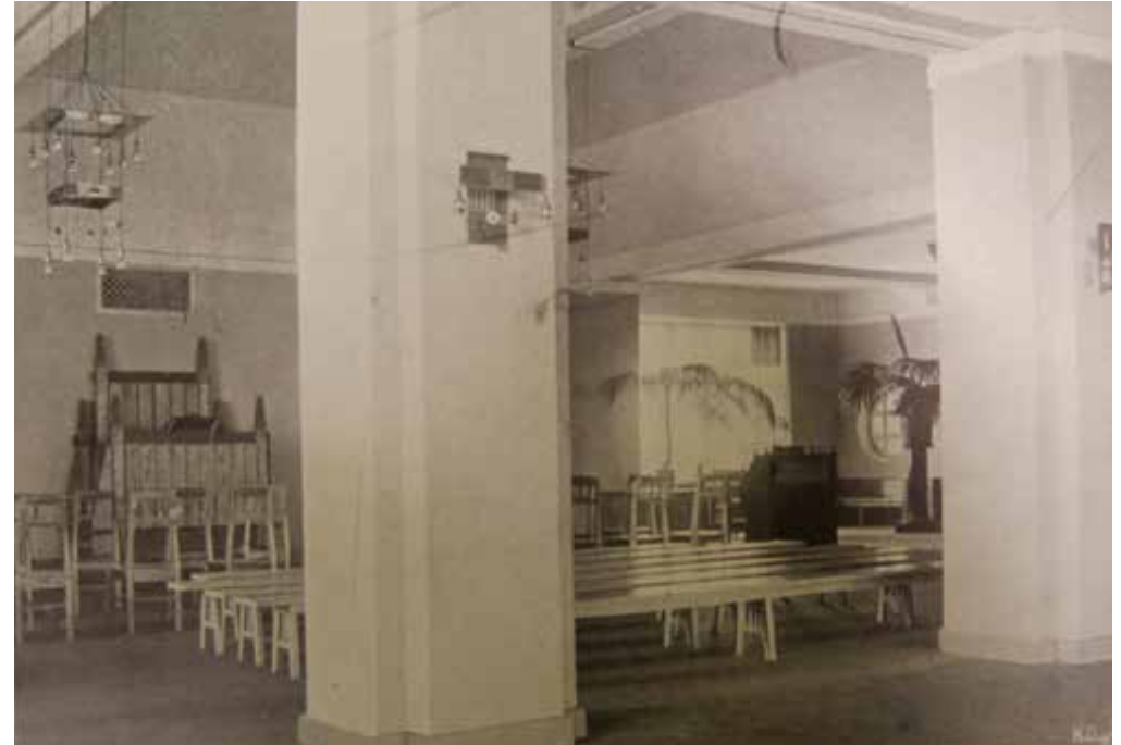
Juhlasali voimistelusalin puolelta katsottuna. Pylväiden välissä ei ole vielä taiteoivia. Kuva: Oulun Suomalaisen Yhteiskoulun vuosikertomus 1909-1910. OSYK.
