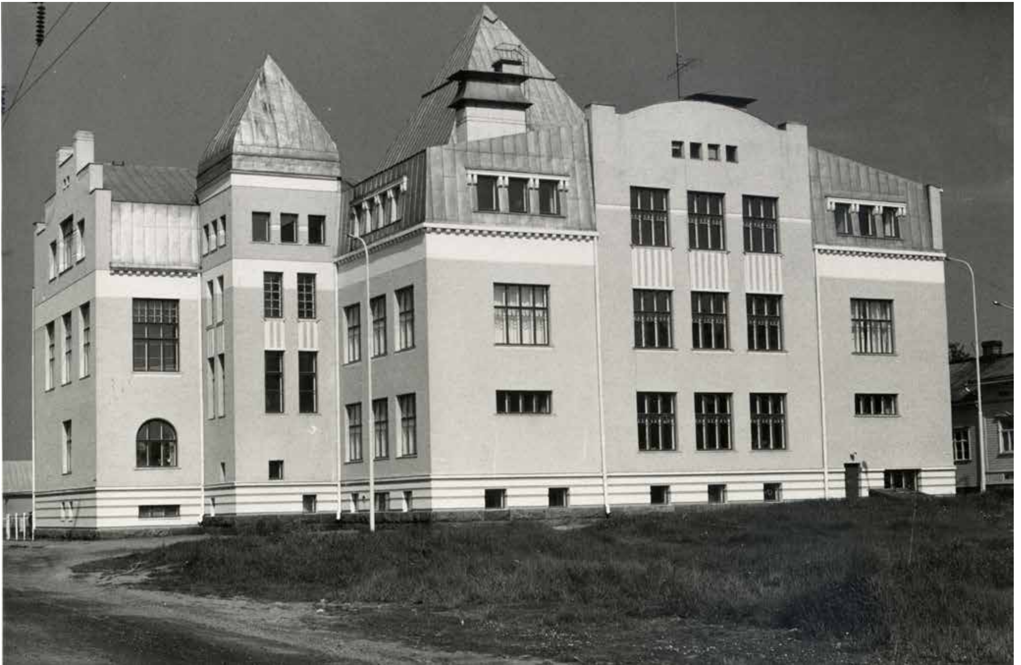
Koulurakennuksen julkisivu puistoon päin lounaaseen 1955 laajennuksen ja korjauksen jälkeen. PPM.
