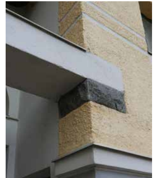
Yksityiskohta sisäpihan katoksen palkista.
