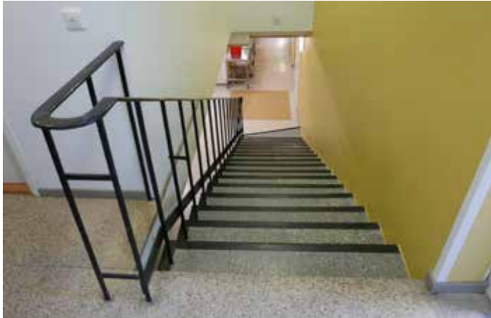
Kellariin johtavat portaat ja kaide.
