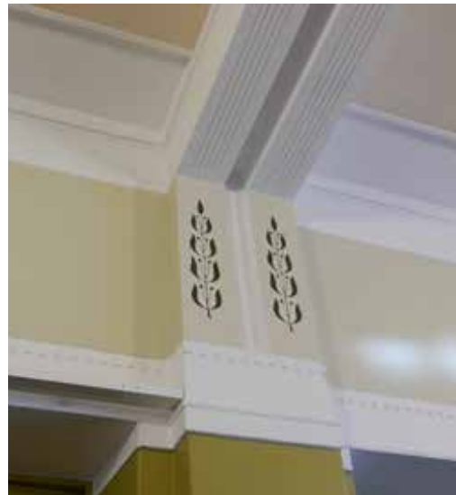
Yksityiskohta pilastereiden ja palkkien koristerappauksista ja -maalauksista.
