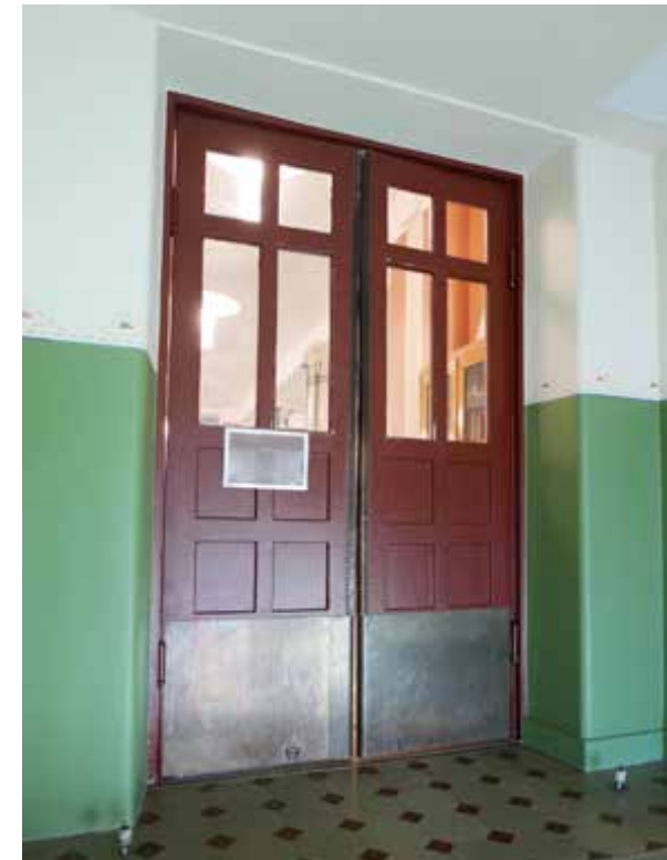
Heiluripariovi, jossa lasi-ikkunat.
