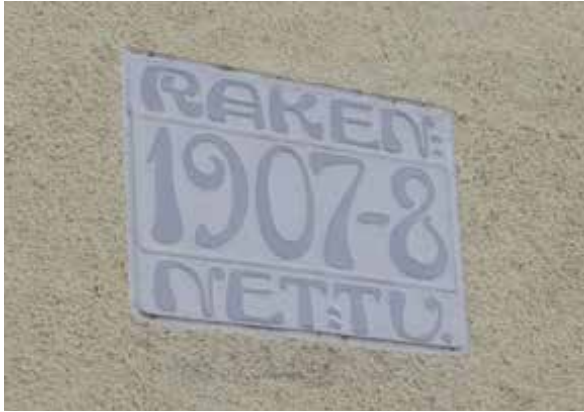
Maunonkadun puoleisessa julkisivussa sijaitseva vuosilukukyltti.
