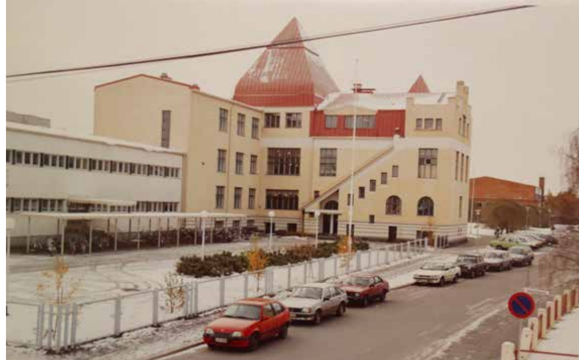
Koulurakennus sisäpihan puolelta lisärakennuksen valmistumisen jälkeen. Valokuva vuodelta 1992, OSYK.
