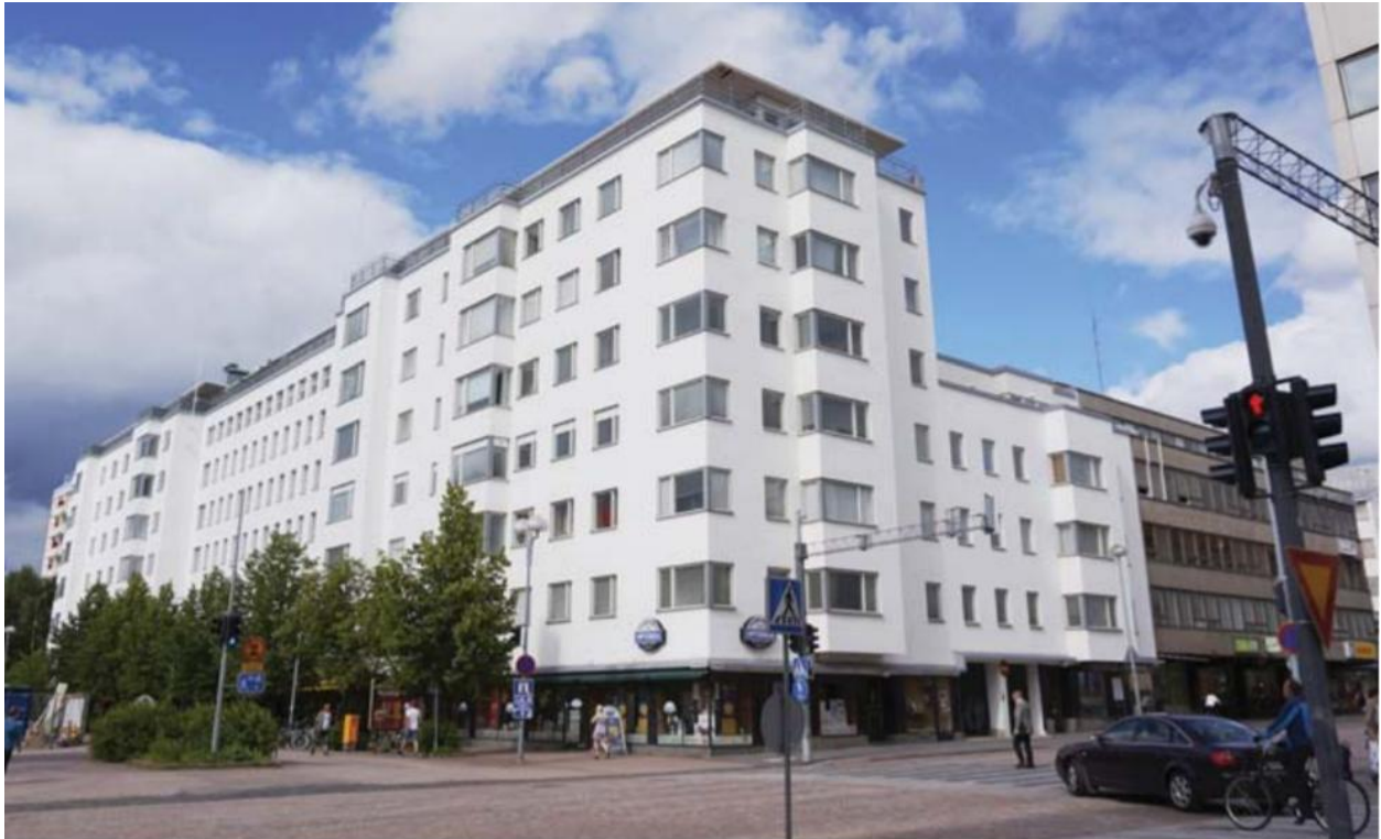
Kuva 8. Näkymä Uudenkadun ja Hallituskadun risteyksestä. Asunto Oy Valkealinna ja Kiinteistö Oy Uusikatu 22.
