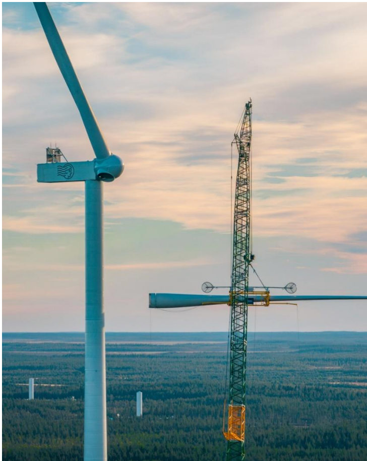
Kuva 5-3. Kuva tuulivoimalasta Pahkakosken tuulivoimahankeen rakennusvaiheessa. © Ilmatar.
