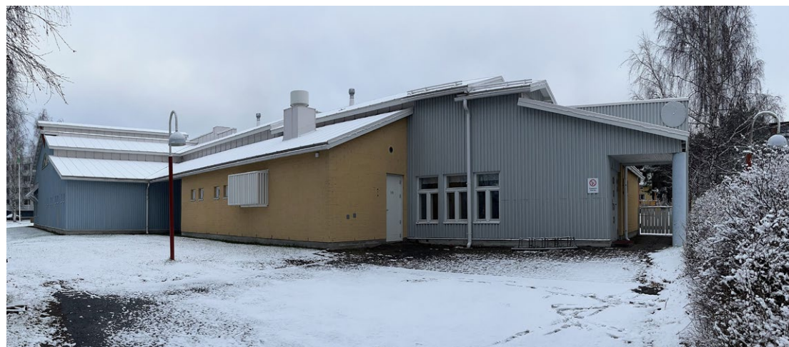
Rakennuksen eteläpäädystä sijaitsevat entisen koulun tilat.
