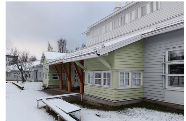
Näkymä leikkipihan keskimmäisestä sisäänkäyntikatoksesta ja sitä reunustavista ulokkeista.
