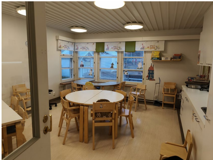
Yllä oikealla näkymä lepotilasta. Kuvassa uudet kaappisängyt ovat kiinni. Tilassa huomio kiinnittyy katon palkistoon ja alkuperäisiin valaisimiin. Alkuperäisen paneelikaton pintaan on lisätty vaimentavia akustiikkalevyjä ja tilan harjalinjaan uusi tuloilmakanava. Tilassa on matalalle sijoitetut neliön muotoiset ruutuikkunat.
