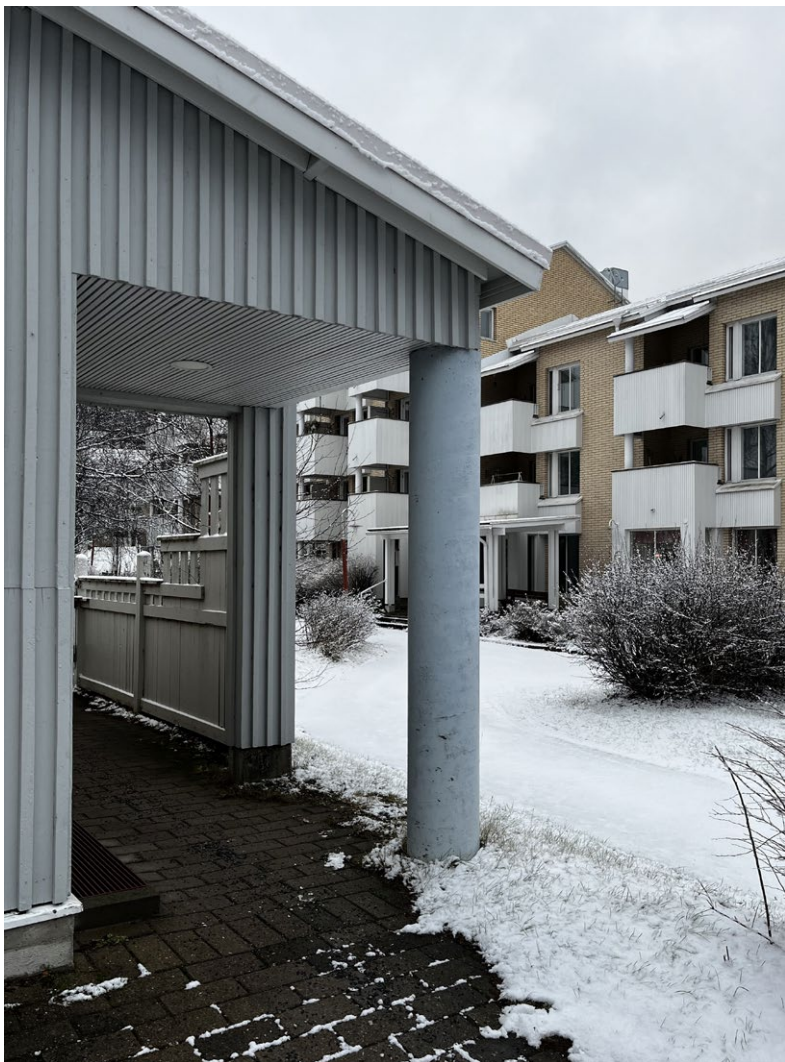
Koskitien puoleinen sisäänkäynti entisen koulun tiloihin ja näkymä naapuritontilla sijaitsevaan Tuiran palvelukeskukseen.
