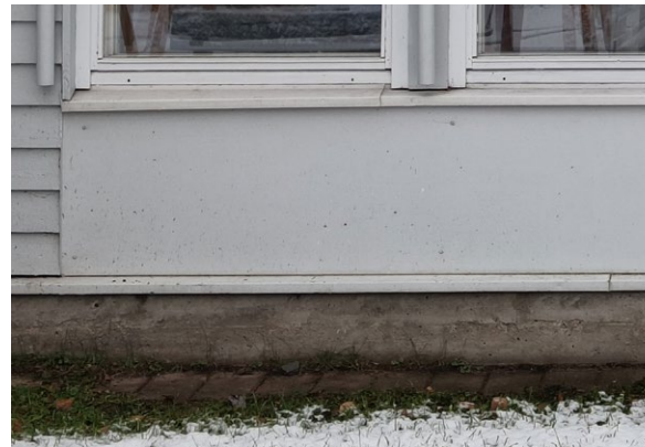
Ikkunoiden alla sijaitsivat alun perin viherlaatikot. Laatikot on myöhemmin purettu ja ikkunoiden alapuoliset osat levytetty.
