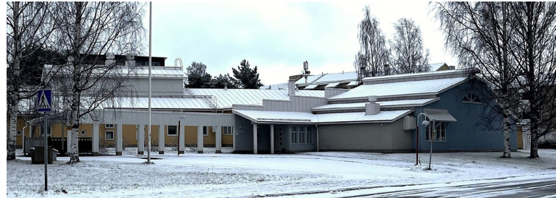
Rakennuksen kattorakenteita Koskitieltä katsottuna.
