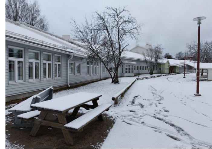
Julkisivunäkymä leikkipihan kulkureitiltä pohjoiseen koulun päädystä katsottuna.
