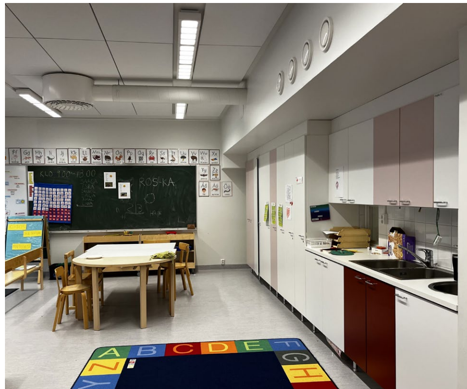
Entisen opetustilan uusi kiintokalustus, IV-kotelo, lisätty ilmanvaihdon päätelaite ja akustoivat levyt sisäkattopinnassa.
