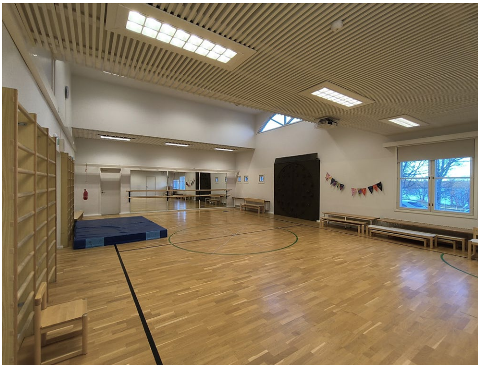
Näkymiä liikuntasalista. Liikuntasalin alaslaskujen puurimoitukset on uusittu alkuperäisen mallin mukaan.
