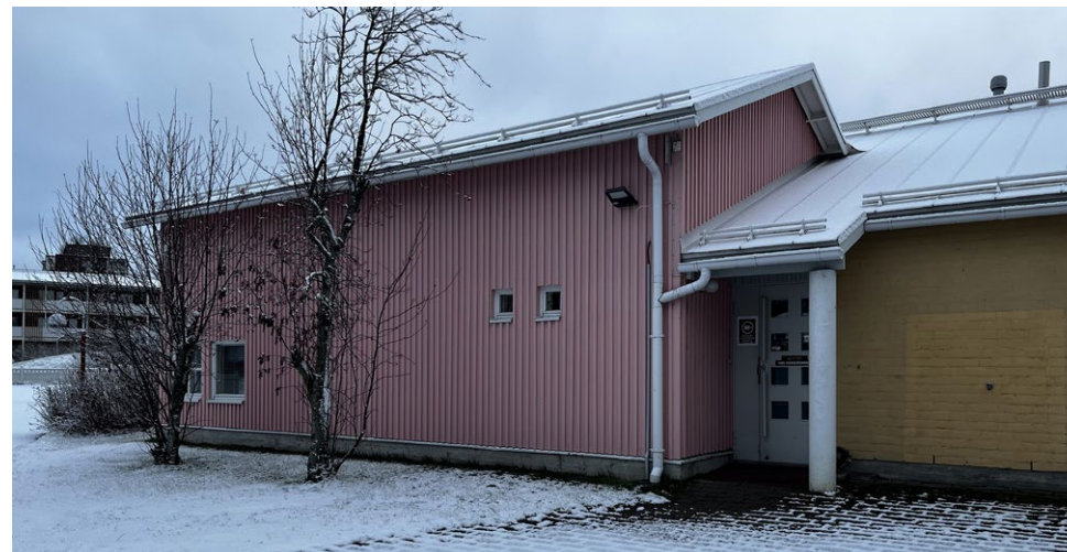
Rakennuksen pohjoispäädystä sijaitseva keittiön sisäänkäynti.
