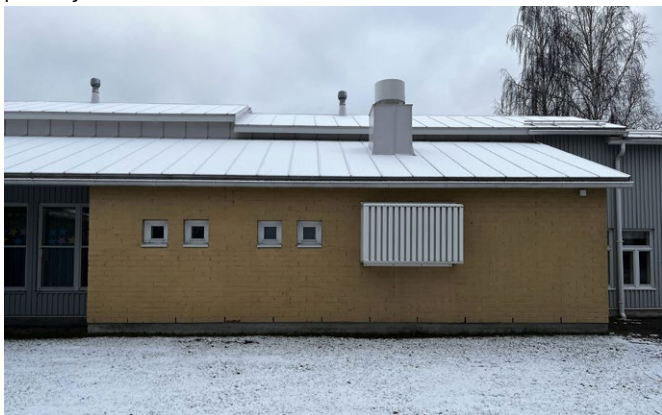
IV-konehuoneen laajennus vuodelta 2017. Alla uusi lauhtutin kadun puolen julkisivussa.
