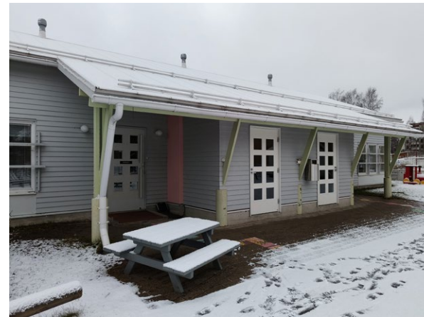
Pienten lasten sisäänkäyntikatokset ja vaunuvaraston laajennus.
