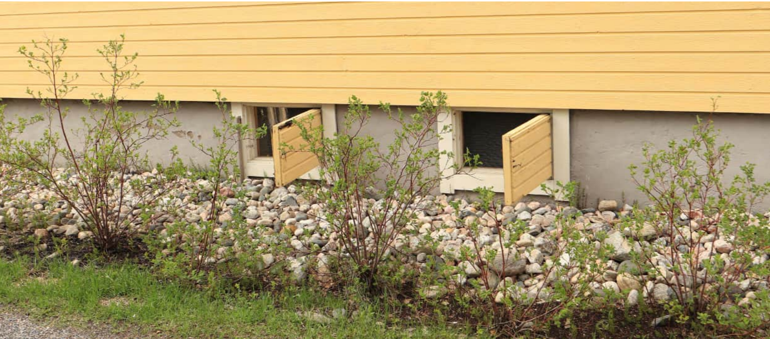
Kuva 80: Sokkelin ympärille on ladottu kiviä kosteuden vähentämiseksi. (Kuva: Riitta Kosonen, Arkkitehtitoimisto Jorma Teppo Oy, 5/2021)
