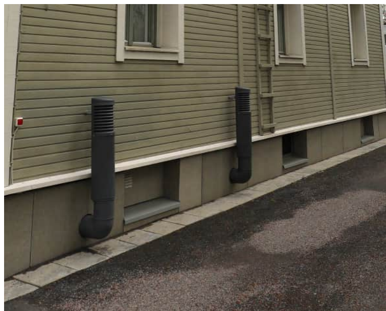
Kuva 83: Levytetty sokkeli. (Kuva: Riitta Kosonen, Arkkitehtitoimisto Jorma Teppo Oy, 5/2021)
