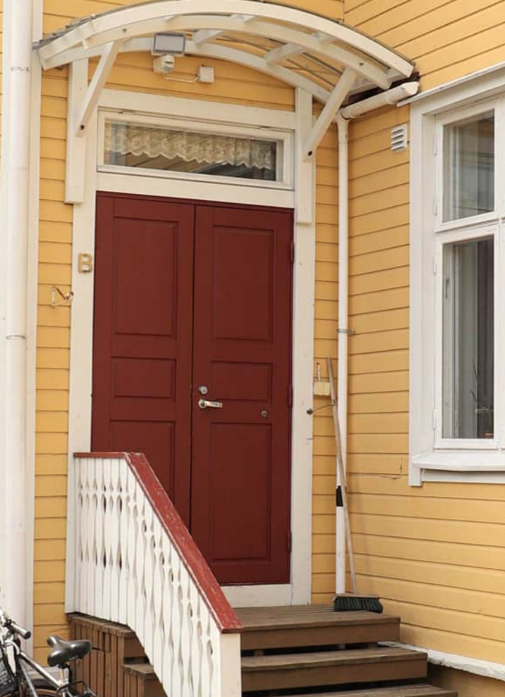
Kuva 72: 1920-luvun klassismi. Ovet on uusittu alkuperäisen mukaisina, katos on uusi lisäys. (Kuva: Riitta Kosonen, Arkkitehtitoimisto Jorma Teppo Oy, 5/2021.)
