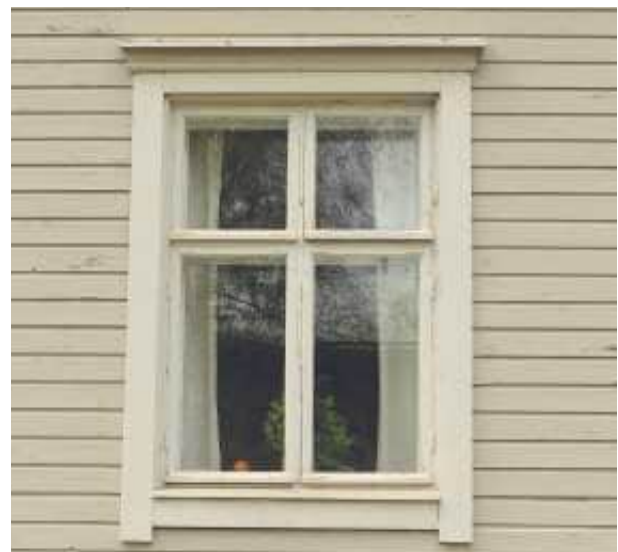
Kuva 34: 4-ruutuinen risti-ikkuna on tyypillisimpiä ikkunatyyppejä Raksilassa. (Kuva: Riitta Kosonen, Arkkitehtitoimisto Jorma Teppo Oy, 5/2021)
