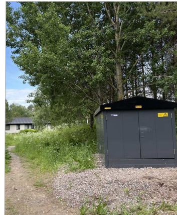
Kuva 10. Viimeistelemätön sähkökeskuksen alue.
