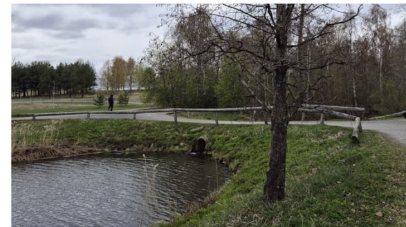
Kuva 9. Itäisin uoman ylityksistä (rumpu ja kaiteet).
