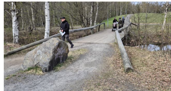
Kuva 8. Keskimmäinen uoman ylityspaikoista (puusilta).
