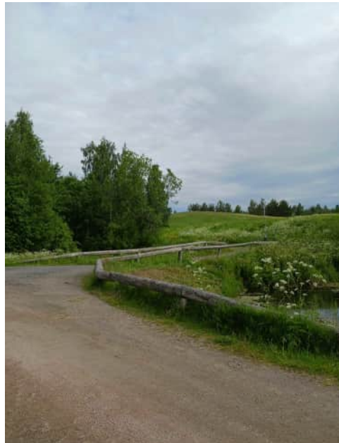
Kuva 5. Selvitysalueella käytävä rakenteen alittava uoma ja rumpu, jonka läpi vesi virtaa. Käytävän reunoilla on kulkua ohjaavat puukaiteet.
