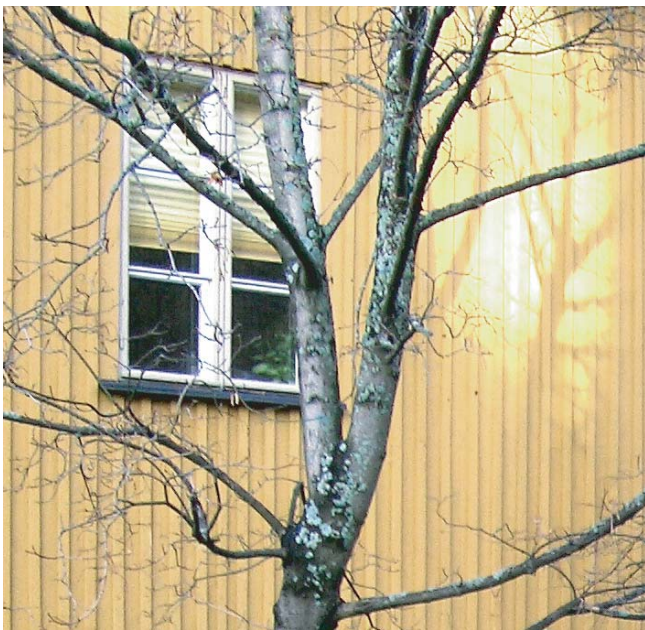
Kuva 11: Esimerkki yhtenäisestä julkisivuverhouksesta ja hillityistä pielilaudoista.
