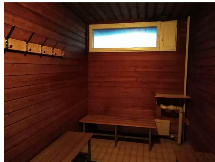
Saunatilojen pukuhuoneet ovat paneloitu vaakasuuntaisella laudalla, ja lattia on päällystetty vaalealla laattalla.
