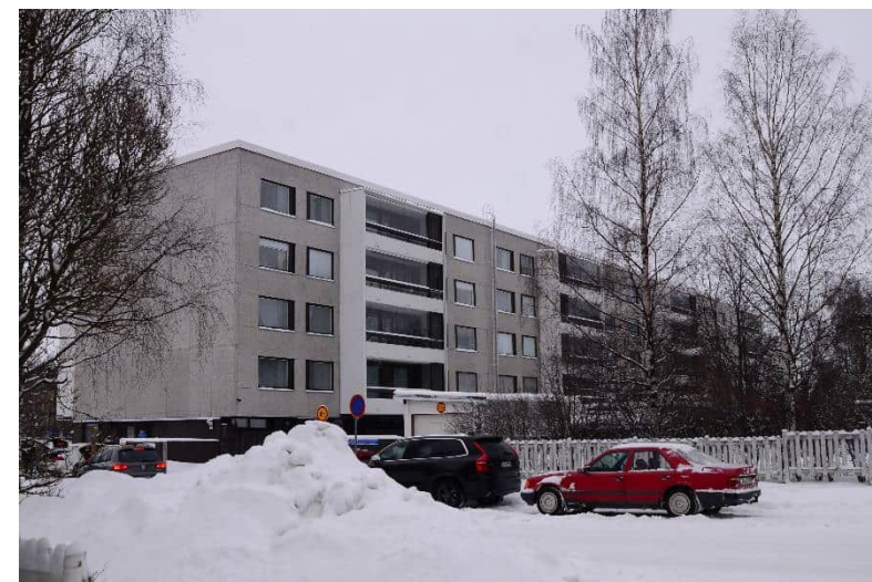
As Oy Raksilan pihanpuoleisessa julkisivussa on uusittu ikkunat, ja parvekkeisiin on tehty lasitus. (Kuva: Noora Kela)
