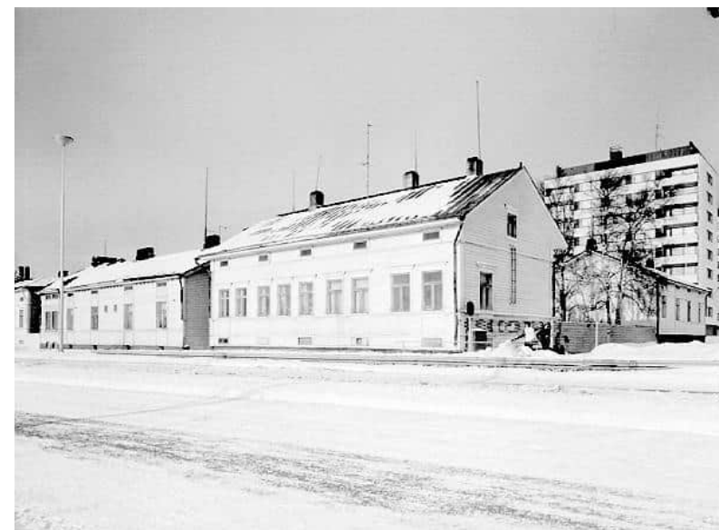
Raksila vuonna 1973. Kainuuntien ja Syrjäkadun risteyksessä otetussa kuvassa näkyy alueen vanhoja puutaloja, joiden taakse on noussut uusia elementtikerrostaloja. (Kuva: Pohjois-Pohjanmaan museo, Uuno Laukan kuva-arkisto)
