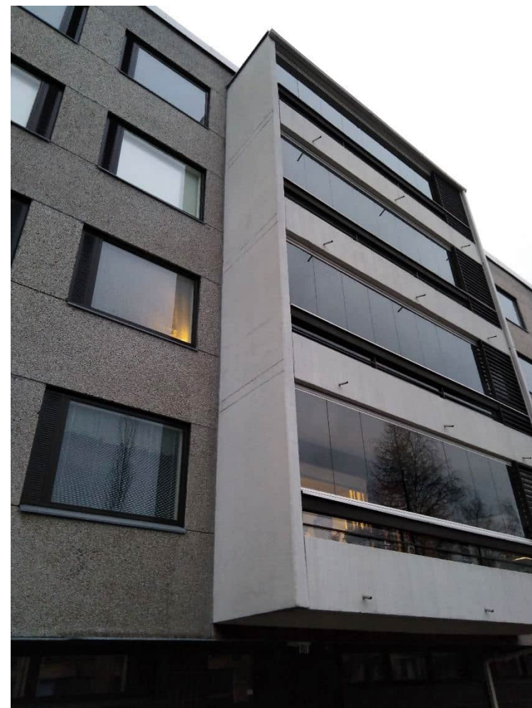
Piha-alueen puoleista julkisivua rytmittävät pystysuuntaiset parvekelinjat ja sääntillisesti sijoitetut ikkunat.
