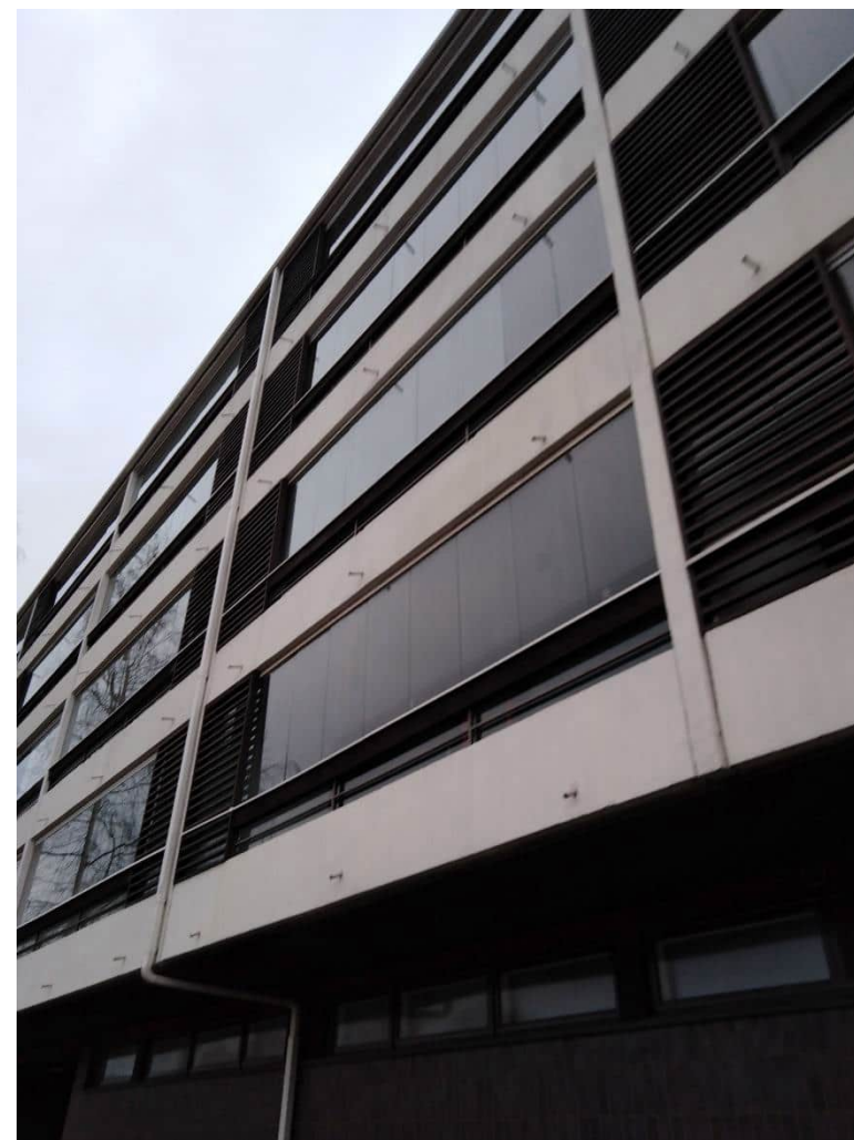
Kainuuntien puoleista julkisivua määrittävät vaakasuuntaiset parvekelinjat. Parvekkeiden välissä kulkevat valkoiseksi rapatut betoniosat, ja pohjakerroksen julkisivussa on ruskea laattaverhouk.
