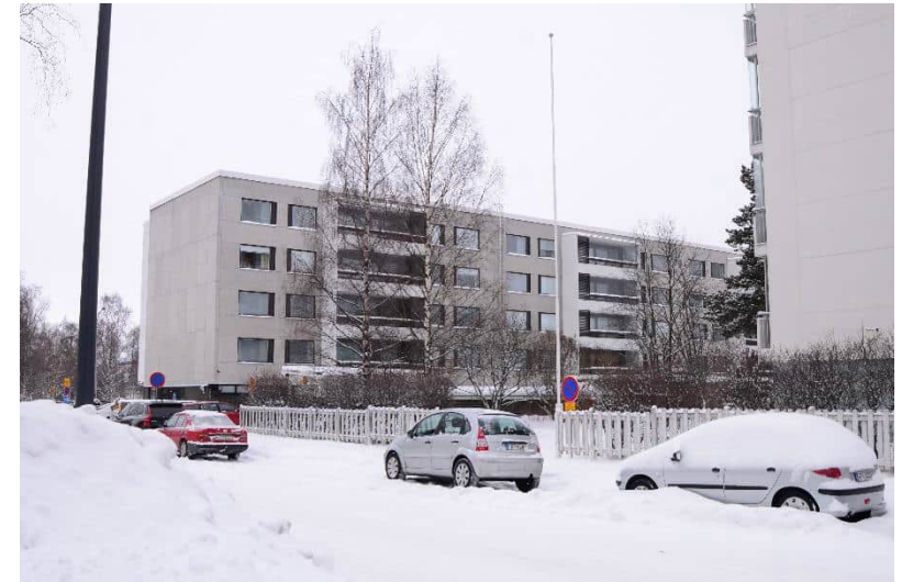
As Oy Raksila, julkisivu itään. (Kuva: Noora Kela)
