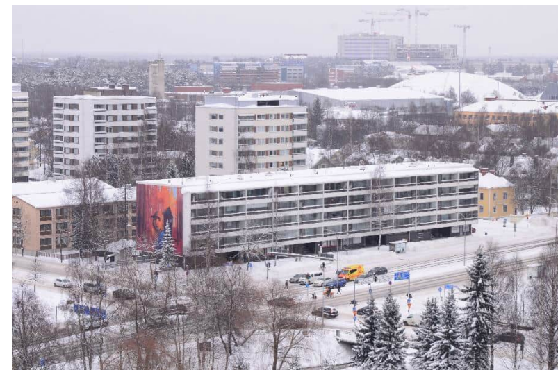
Kuvassa etualalla kulkee Kajaanintie. Sen takana oikealla Raksilan historiallista puurakentamista ja vasemmalla modernin aikakauden kerrostaloja. Takana näkyvässä Raksilan itäosan urheilukeskus. (Kuva: Noora Kela)
