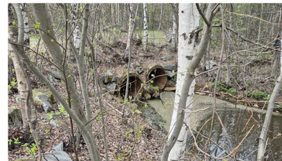
Kuva 10. Läntisin uoman ylityksistä (kaksoisrumpu ilman kaiteita).
