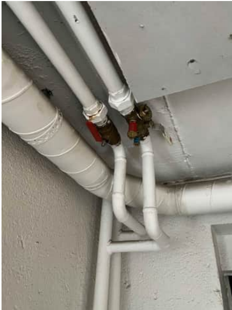
Kuva 8. Uusittuja linjasäätöventtiileitä.
