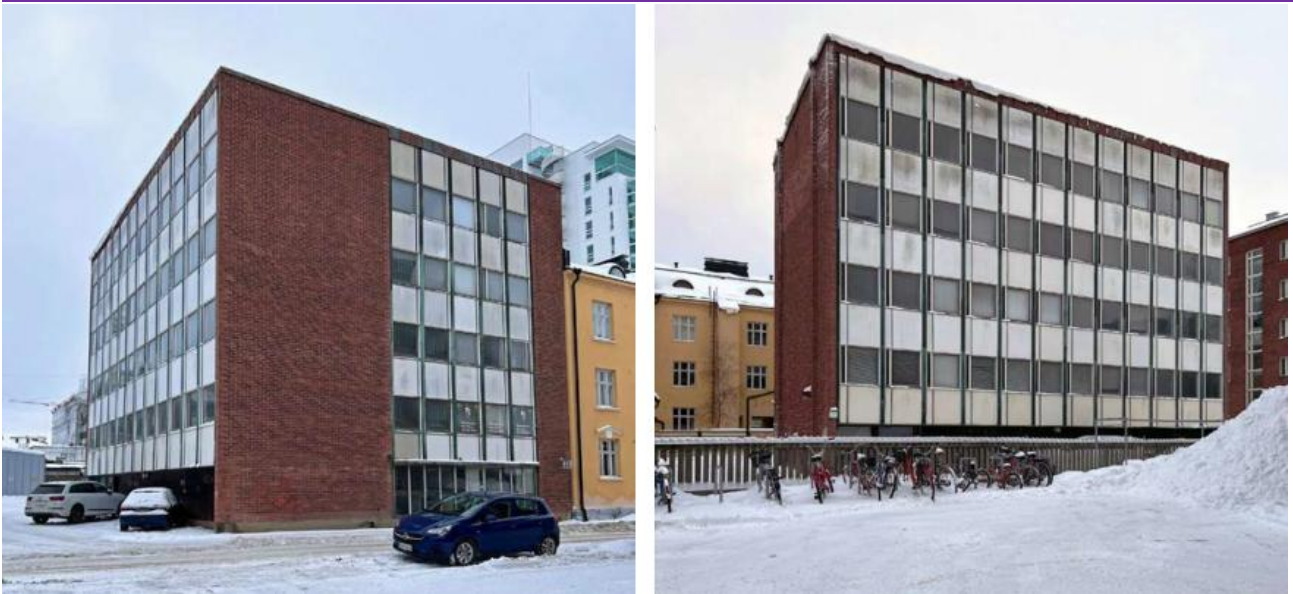
Kuva 3 Vasemmanpuoleisessa kuvassa on esitetty Kauppurienkatu 33:n julkisivu Kauppurienkadulle päin ja oikealla julkisivu luoteeseen. Valokuvat ovat laaditusta rakennushistoriaselvityksestä © Kallinen, 2022.
