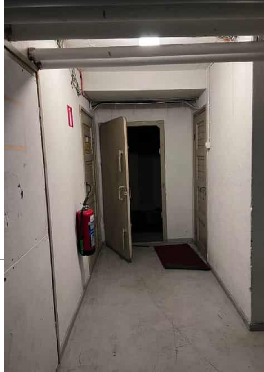
Kuva 114: Kellarin käytävä kohti väestönsuojan ovea. Kuvattu 2022, JK.
