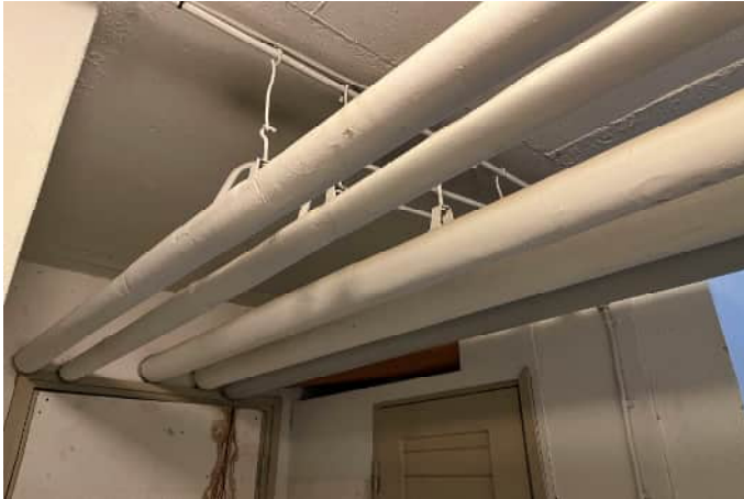
Kuva 7. Alkuperäisiä putkistoja. Osassa asbestipinnoite.
