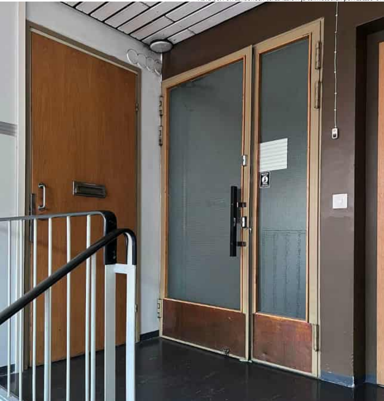
Kuva 86: Porrashuoneen teräs-lasiovi ja toimistotilan porrastaso-ovi.
