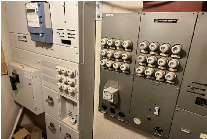
Kuva 16. Uusittu sähkökeskus sekä alkuperäinen sähkökeskus.
