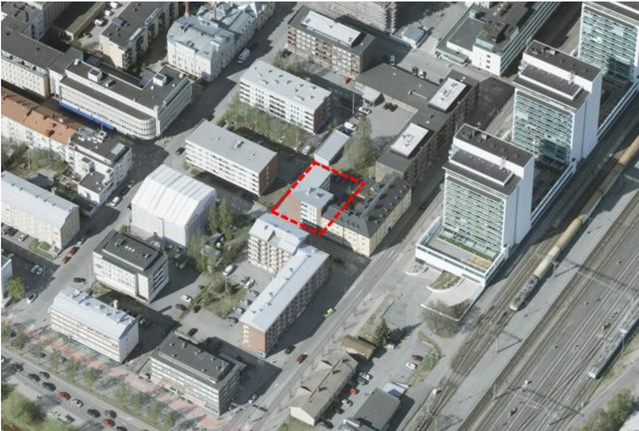
Kuva 2 Ilmakuva etelästä pohjoiseen, missä suunnittelualue on rajattu punaisella katkoviivalla. Viistoilmakuva vuodelta 2024 © Oulun kaupunki.
