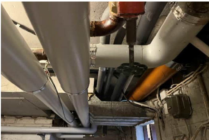
Kuva 6. Lämmönjakohuoneesta lähteviä alkuperäisiä putkistoja.
