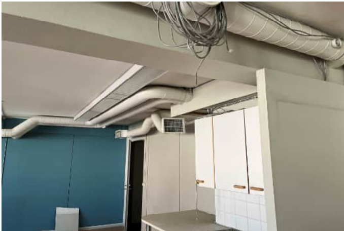
Kuva 12. Kohteeseen tehtyjä ilmanvaihdon muutoksia. Huoneiston ilmanvaihto hoidetaan ilmanvaihtokoneella. Muissa huoneistoissa huippuimurein.
