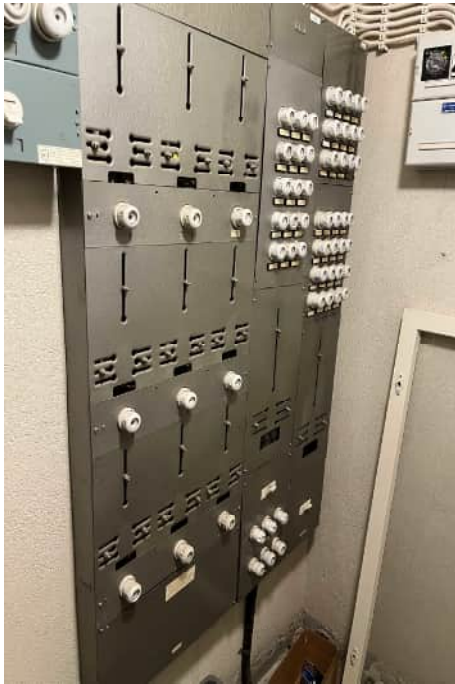
Kuva 17. Alkuperäinen mittauskeskus.
