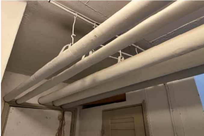
Kuva 7. Alkuperäisiä putkistoja. Osassa asbestipinnoite.
