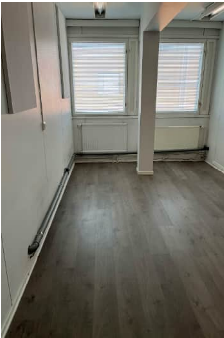
Kuva 10. Kohteen lisättyjä viemäreitä.
