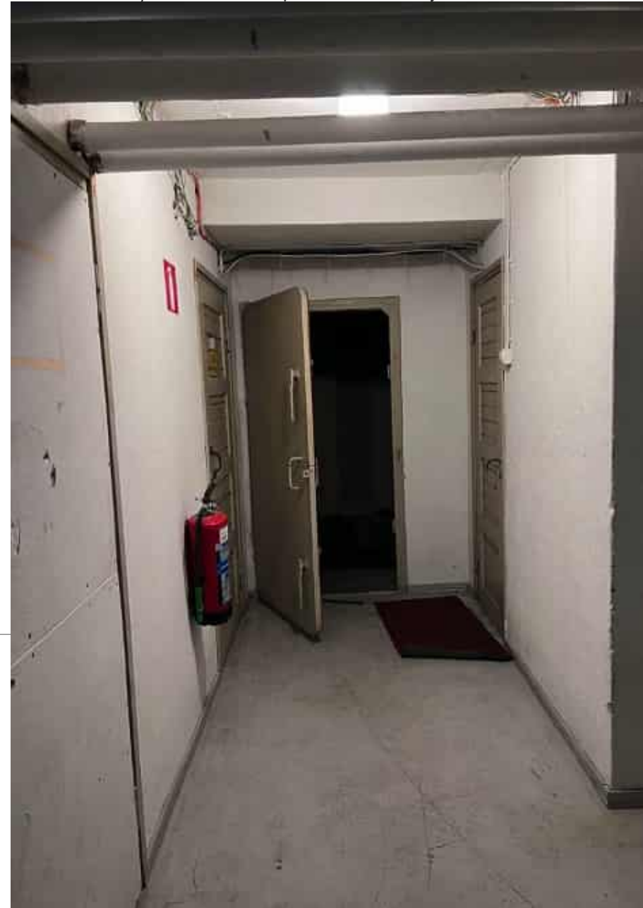
Kuva 114: Kellarin käytävä kohti väestönsuojan ovea. Kuvattu 2022, JK.
