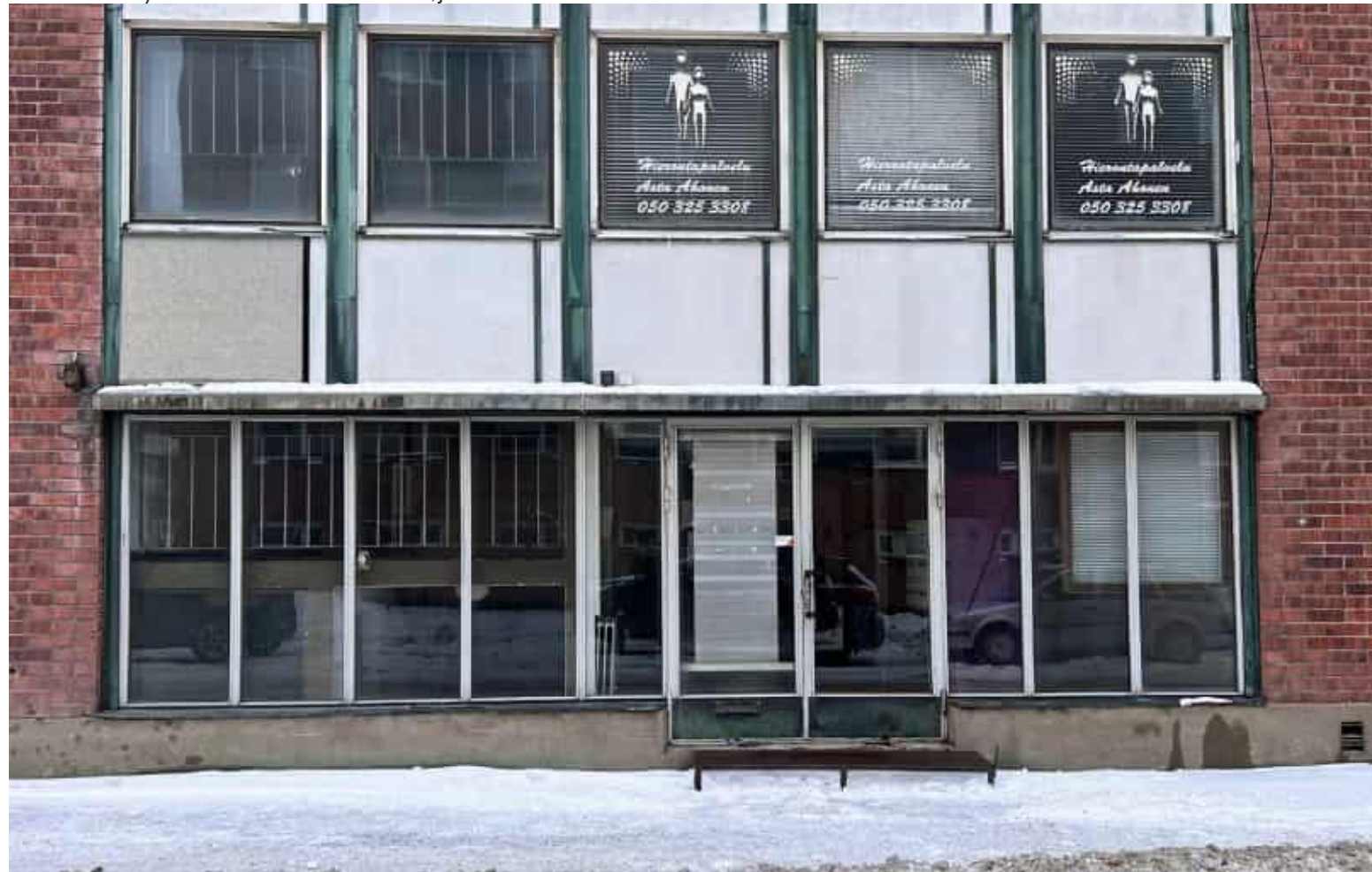
Kuva 92: Sisäänkäynti kadulta kuvattuna. Kuvattu 2022, JK.
