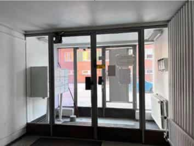
Kuva 91: Sisäänkäynti aulasta kuvattuna. Kuvattu 2022, JK.
