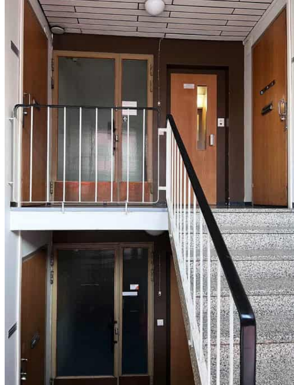
Kuva 98: Porrashuone kuvattuna portaan lepotasolta. Kuvattu 2022, JK.
