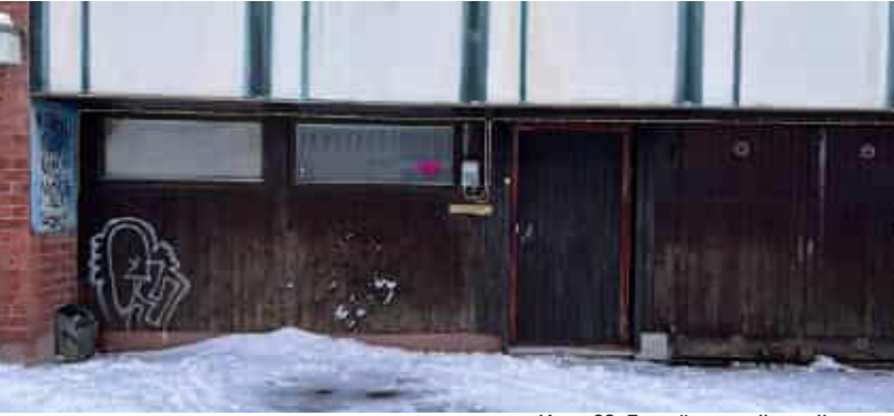
Kuva 83: Entisiä autotallien ulko-ovia.
