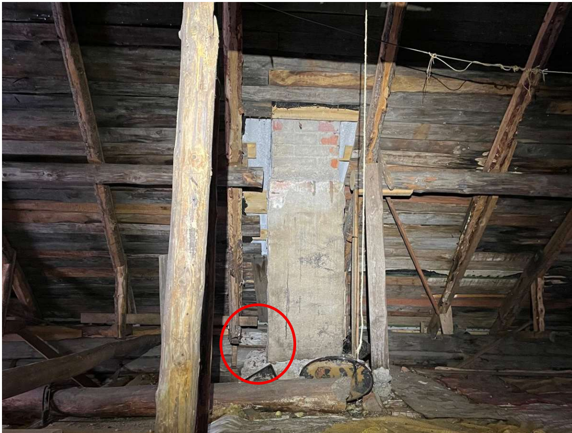
Kuva 2. Inventointialueelle sijoittuvan autotalon (Liikasantie 13) välikatolle jäävä tyhjä tila toimii pohjanlepakon satunnaisuusluonteisena kesäaikaisena päivälepopaikkana (papanakeskittymien löytöpaikat rakennuksen (a) itäseinustalla ja (b) savuhormin tyvellä ympäröity punaisella).
