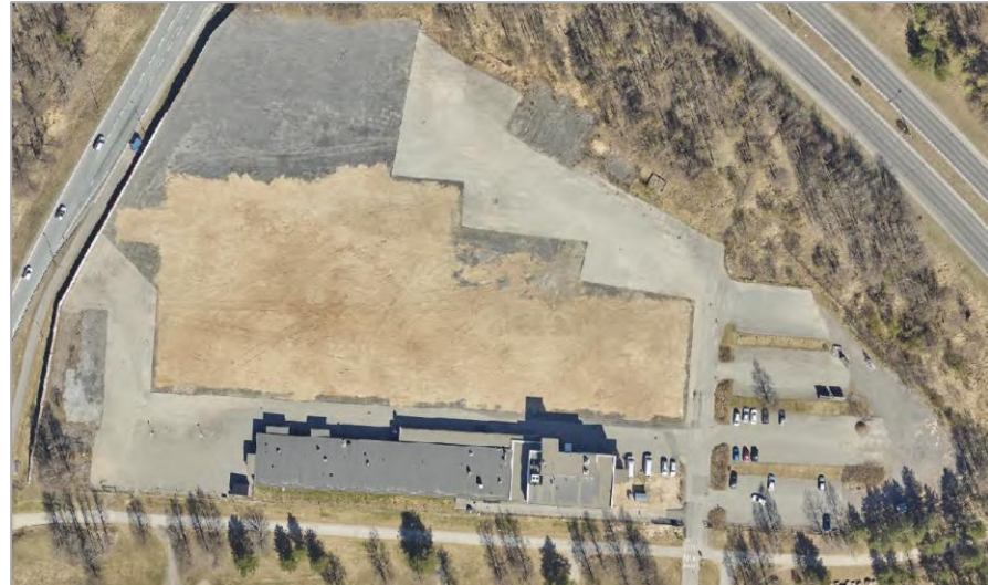
Kuva 21: Ilmakuva kohteesta vuodelta 2025, jossa nähtävissä nykyiset päällystetyt pysäköintialueet ja purkamatta oleva rakennus alueen eteläosalla. Lähde: Oulun karttapalvelu 11/2025.
