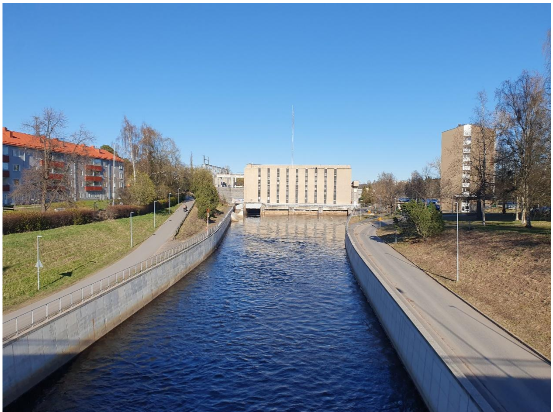
Kuva 20 Valokuva Merikosken silloilta kohti vesivoimalaitosta. Voimalaitoksen julkisivu muodostaa päätteen Alakanavalle. Kanavan vasemmalla puolella Tuiranportin ja oikealla puolella Toivoniemen asuinkerrostaloja.
