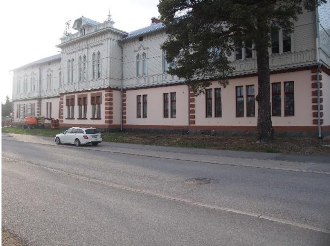
Kuva 32 Tuiran koulun vanha rakennus Koskitien puolelta kuvattuna. Rakennuksen ensimmäinen kerros on kivrakenteinen ja toinen kerros puurakenteinen.
