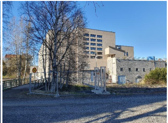
Kuva 23 Merikosken voimalaitoksen länsijulkisivussa on pystysuuntaiset nauhaikkunat.
