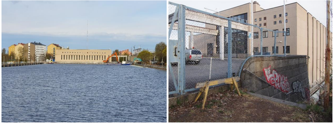
Kuva 25 Voimalaitoksen itäjulkisivu porrastuu kahteen osaa, joista alemmassa on pystysuuntaiset nauhaikkunat ja ylemmässä neliömäiset ikkunat.
