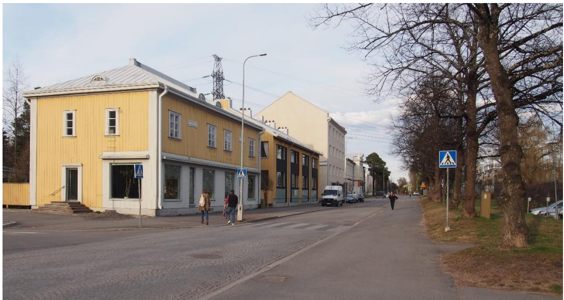
Kuva 35 Kaksikerroksinen, puurakenteinen Tuiran Osula on säilynyt osa puu-Tuiraa.
