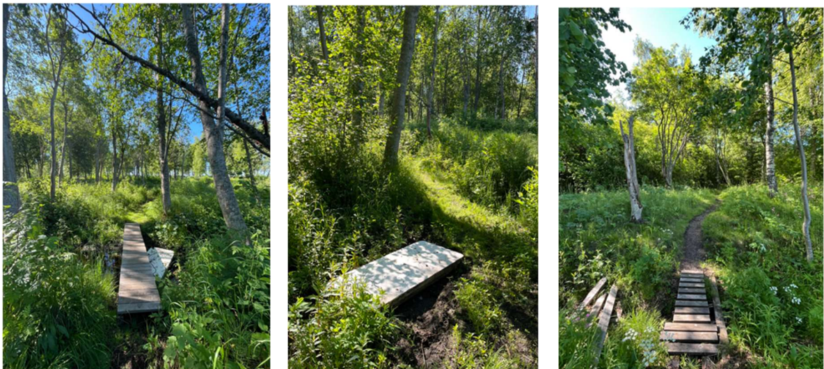
Kuvat 10, 11 ja 12. Puusta ja eristelevyistä rakennettuja kulkusiltoja kosteikoiden ja pienten ojien yli.
