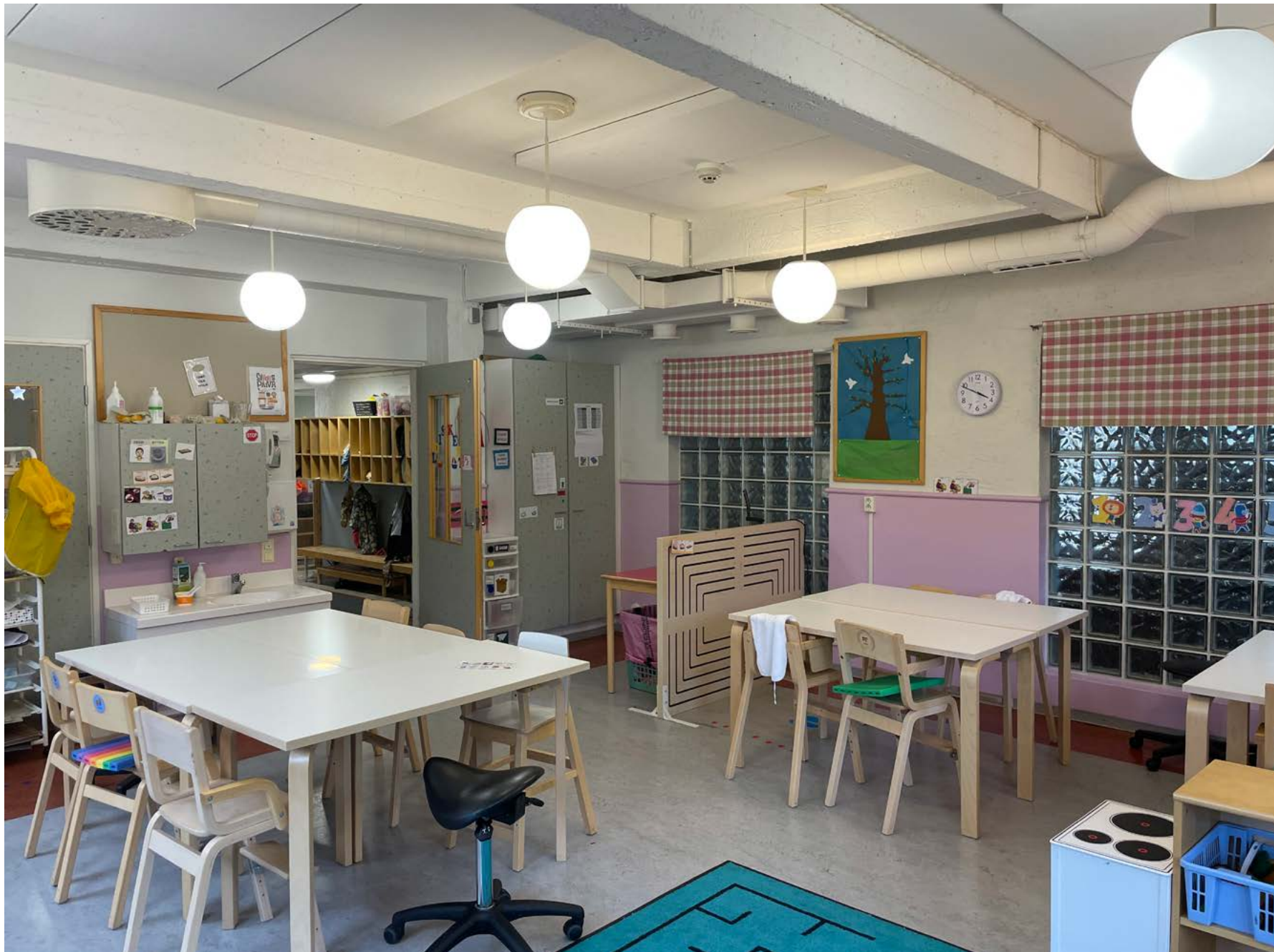
Loiskeiden ryhmähuone. Välipohjapalkkien väleissä on ilmanvaihtokanavia, valaisimia ja akustiikkalevyjä.
