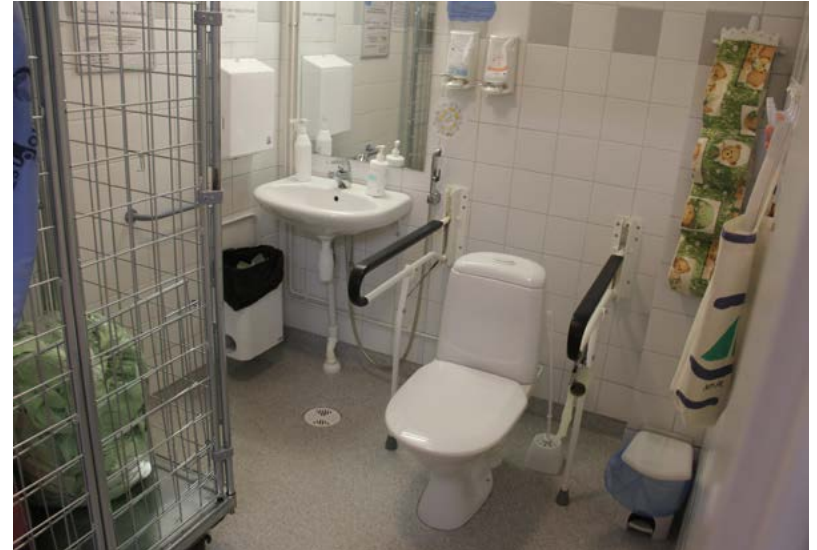
Esteetön WC ensimmäisen kerroksen keskikäytävä varrella. Vesikalusteet ovat 1990-luvun lopulta.
