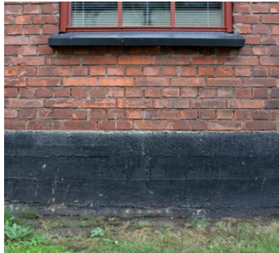
Betonisokkelissa näkyy vaakasuuntaisen lautamuotin jättämä kuvio. Sokkeli on maalattu mustaksi.
