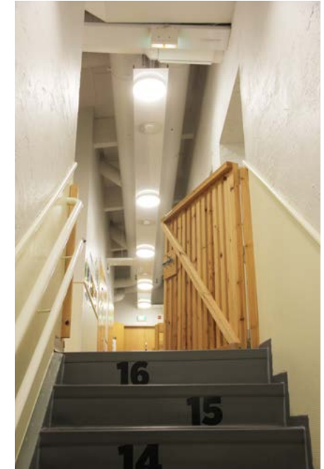
Portaiden yläpäässä on lapsiportti. Kaksitasoinen käsijohde on tehty metalliputkesta.
