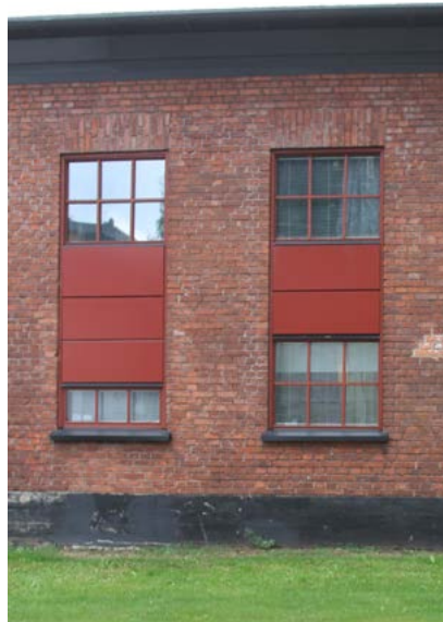
Ikkunoiden lasipinta-aloja on muunneltu punaisilla ohutlevyelementeillä.
