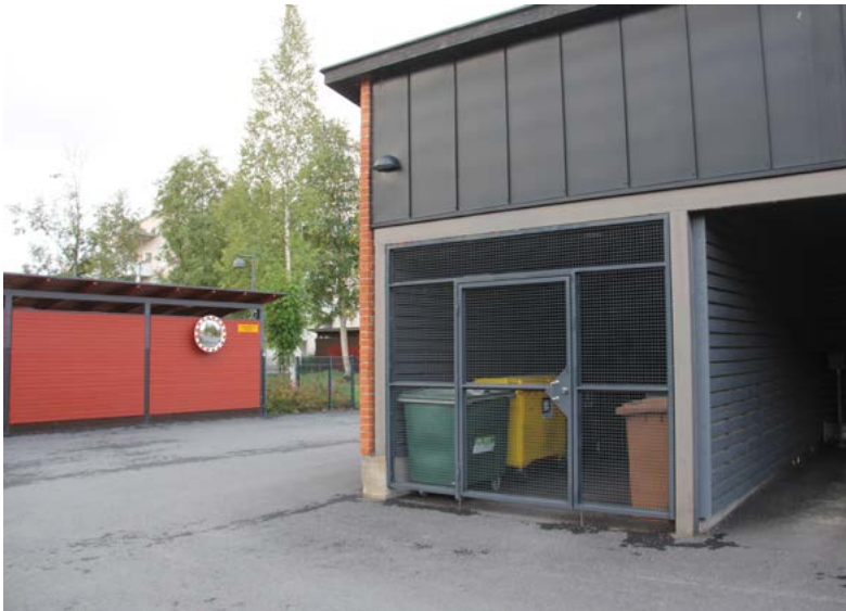
VASEMMALLA: Julkisivumateriaaleina ovat punatiili ja musta teräsohutelevy. Kuvassa näkyy vuonna 2023 uusittu seinävalaisin.
