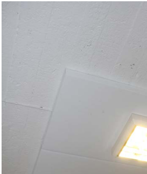
Toisen kerroksen betonikatossa näkyvät lauta- muotin jättämät kuviot.
