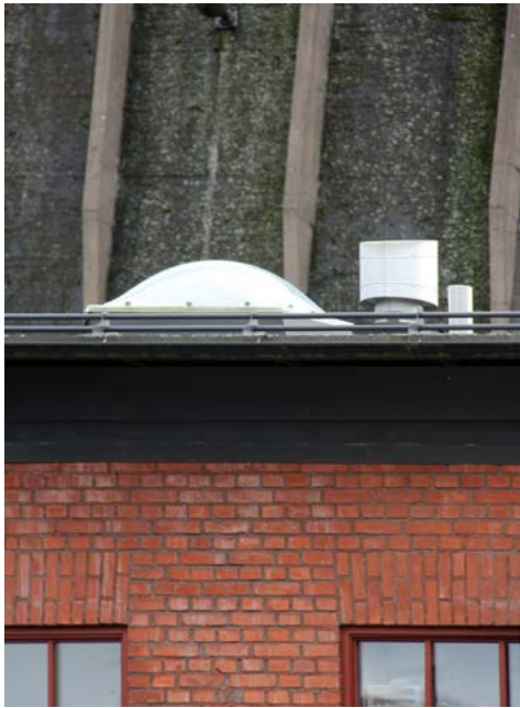
Vesikatolla on viisi kupumaista kattoikkunaa. Ikkunan oikealla puolella on ilmanvaihtokoje.
