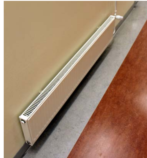
Lämpöpatterit ovat 1990-luvun levypattereita.
