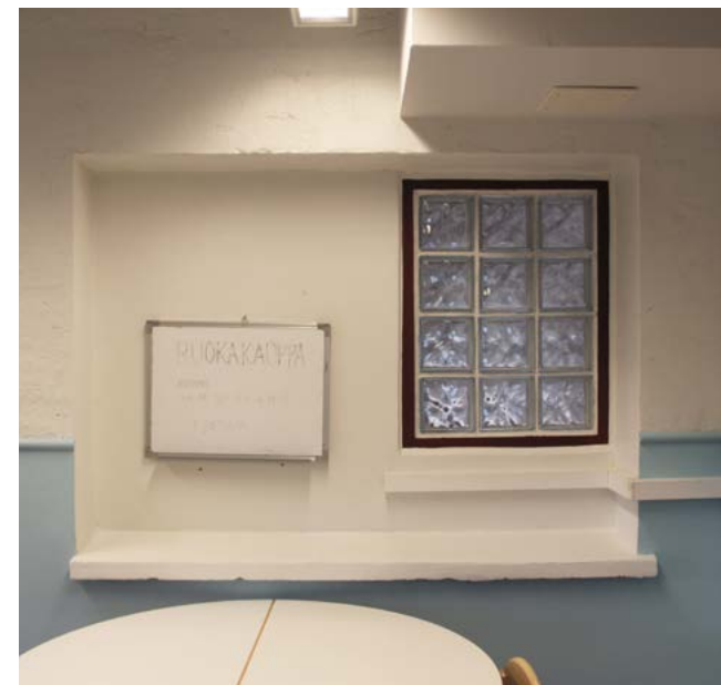
Korjaamohalliin suuntautuvaa ikkunaa on pienennetty vuonna 1998. Lasi on korvattu lasitiilellä.
