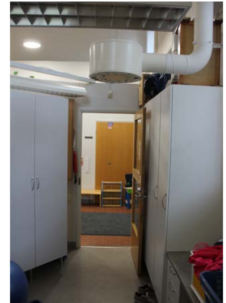
Entistä vahtimestarin työtilaa käytetään varastona ja pukutilana.
