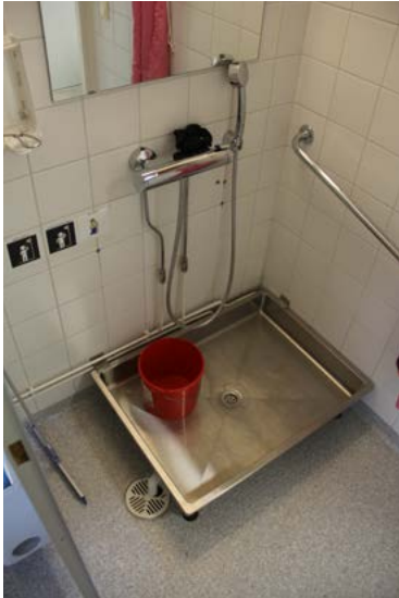
Toisen kerroksen WC:n teräksinen huuhteluallas ja suihku on lisätty vuoden 2010 muutosvaiheessa.
