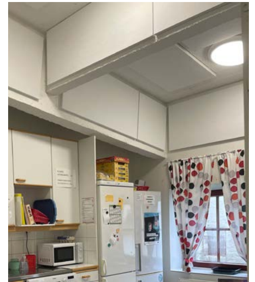
Nuorisotalon alakatot ja palkit on päällystetty kauttaaltaan akustiikkalevyillä.
