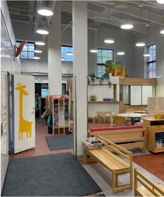
Aulan pallovalaisimet on vaihdettu lieriömäisiin ledvalaisimiin.
