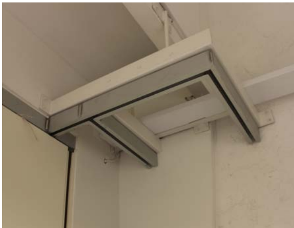
Siirrettävän seinän osat taittavat nipuk- si sivuseinälle. Ku- vassa on kiskomeka- nismien pääty pala.
