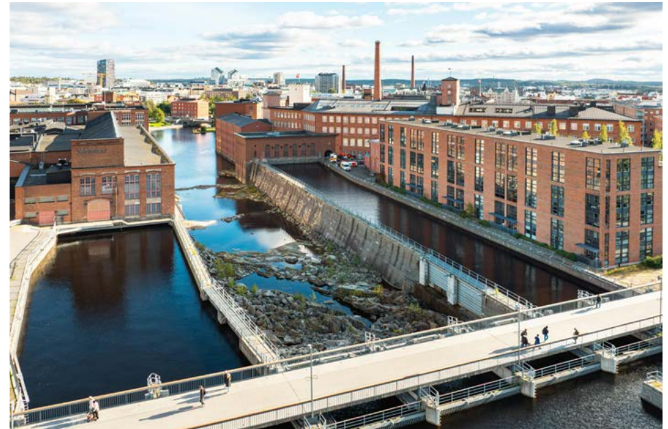
Tampereen kaupungin ydin muodostuu kosken äärelle rakennetuista punatiilisistä teollisuusrakennuksista, joiden uusiokäyttö on toiminut edelläkävijänä Suomessa. Vuonna 2025 vapautuu jälleen suuri kiinteistö, kun vuonna 1865 aloittanut Takon tehdas lopettaa toimintansa. KUVA: Vapriikin kuva-arkisto, Saarni Säilynoja 2025 CCBY4.0
