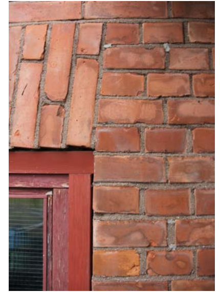
Ikkunan yläosan liittyminen ulkomuurin holvaukseen.
