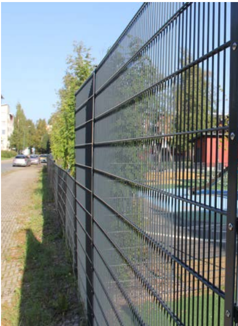
VASEMMALLA: Uusi teräverkkoaita. Aidan korkein osa on sijoitettu kadun puolelle.
