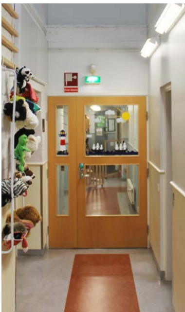
Kaksiosainen osastoiva väliovi keski-käytävällä. Ovesa on palosuoja- lasit.
