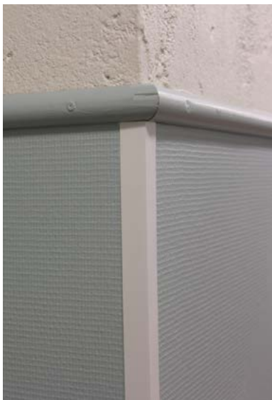
Oleskelutiloissa seinien alaosat on päällystetty lasikuitutapetilla. Tapetin yläreunassa on pyöreä lista.
