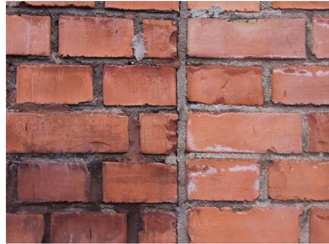
Puhtaaksi muuratusta julkisivussa on sekalimitys ja harmaa saumalaasti. Vasemmalla on alkuperäinen muuri.
