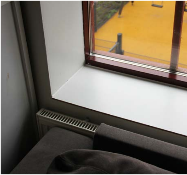
Toisen kerroksen kiinteä kolmilasinen ikkuna. Syvän ikkunanpenkin vaakatasolla on levytys.
