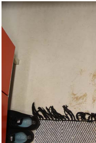
Varastohuoneen harmaaksi maalattu betonilattia.
