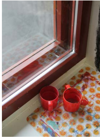
Sisäänpäin avautuva MSE-ikkuna toisessa kerroksessa.
