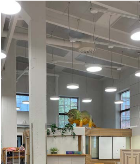
Keskushallin betonikattoa rytmittävät vinot alapalkit. Palkkien välissä on akustiikkalevyjä.
