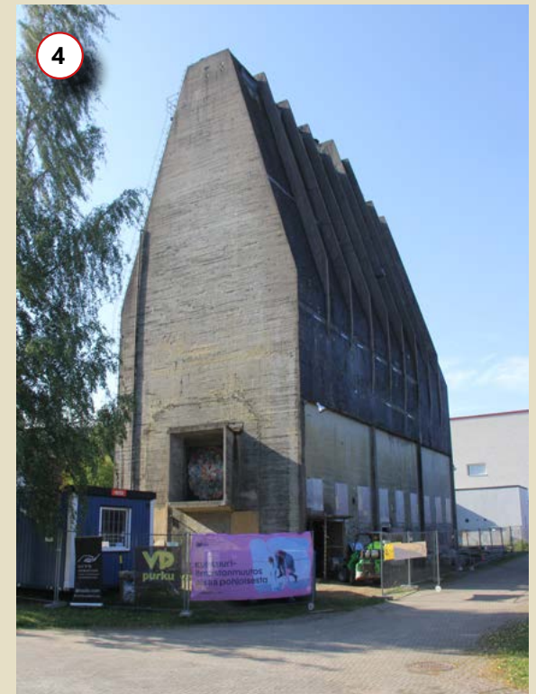
Pitkään käyttöä odottanut hakesiilo on nousemassa alueen merkittävämmäksi arkkitehtuurikohteeksi.
