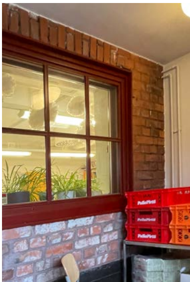
Tuulikaapeissa näkyy alkuperäistä tiiliseinää.
