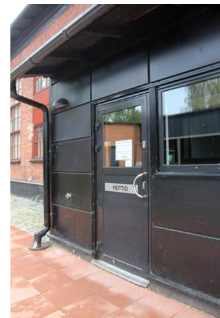
Sisäänkäynnit on verhoiltu mustalla ohutlevy-kasetilla. Katoksissa on pitkät räystäät.
