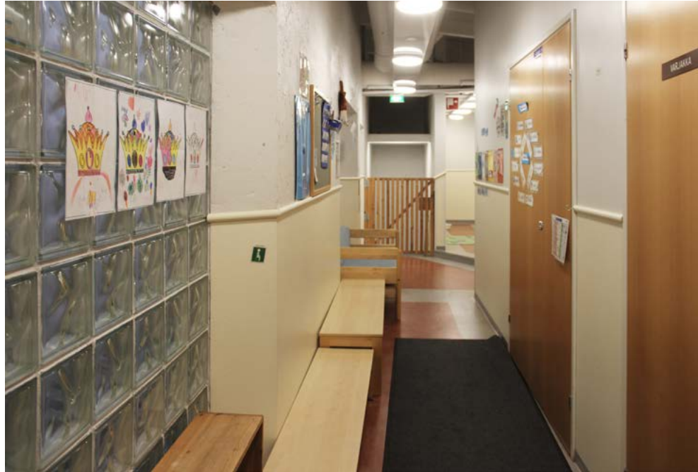
Näkymä sivukäytävästä kohti sisäporrasta. Oikealla on päiväkodin ryhmähuoneita. Portin vasemmalla puolella on WC:t ja oikealla henkilökunnan pukuhuoneet.
