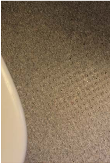
Kitkapintainen muovimatto WC:ssä.
