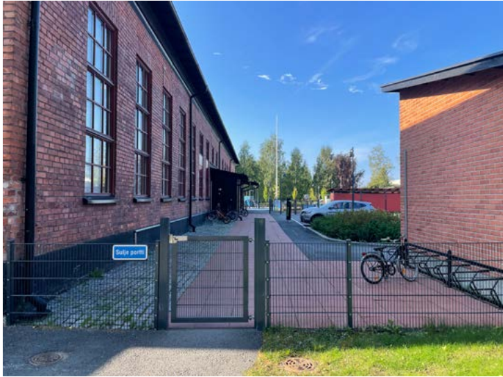
Pyöräilijät ja jalankulkijat pääsevät päiväkodin pihalle kevyen liikenteen reittejä pitkin. Oikealla on polkupyörien pysäköintipaikka.
