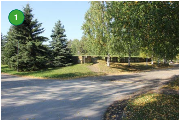
Entinen jätevesiallas on täytetty maalla.
