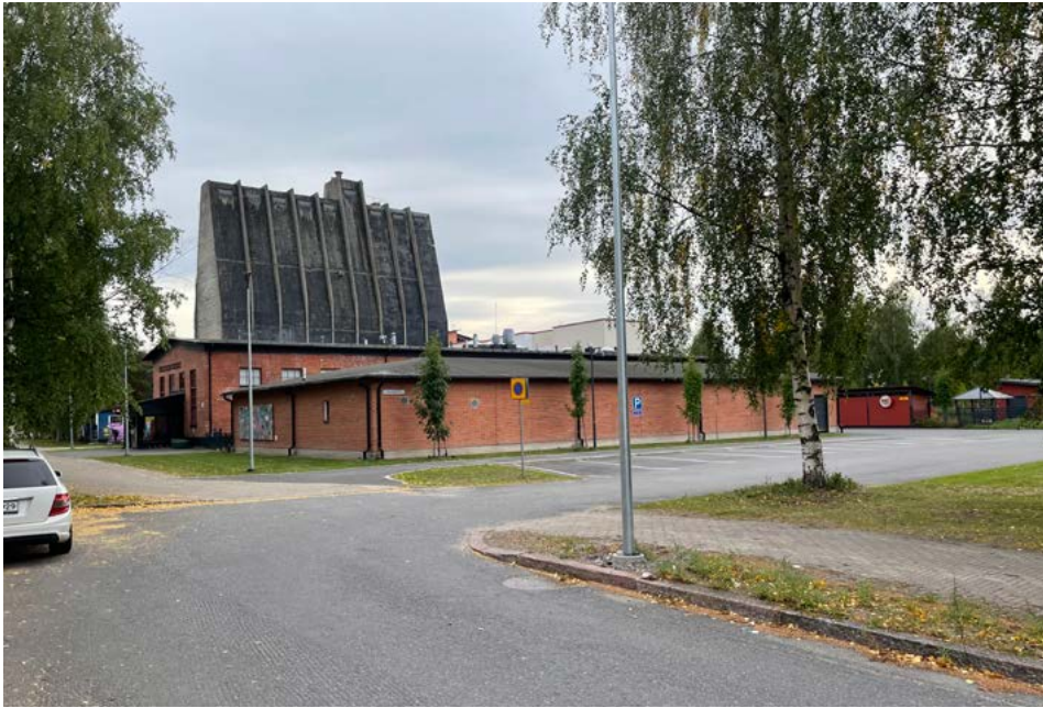
Piharakennuksen takajulkisivu koillisesta. Vesikaton aumattu ulkokulma jättää korjaamorakennuksen näkyviin pohjoisen suunnasta lähestyttäessä.
