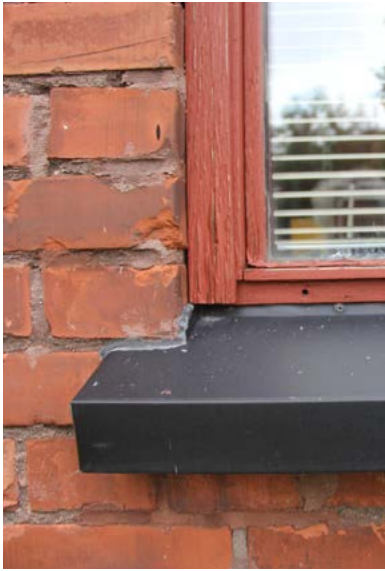
Ikkunan alaosan liittyminen vesipeltiin ja ulkomuuriin.
