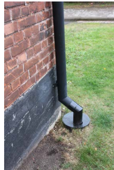
VASEMMMALA: Sadevesi ohjautuu suoraan maanalaiseen hulevesiverkkoon.
