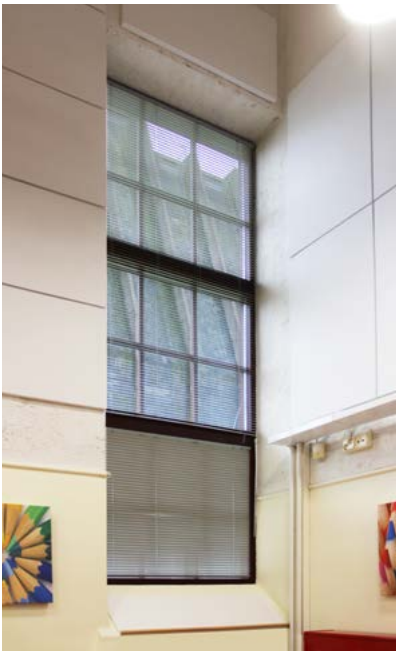
Toisen kerroksen kiinteä kolmilasinen ikkuna. Syvän ikkunanpenkin vaakatasolla on levytys.
