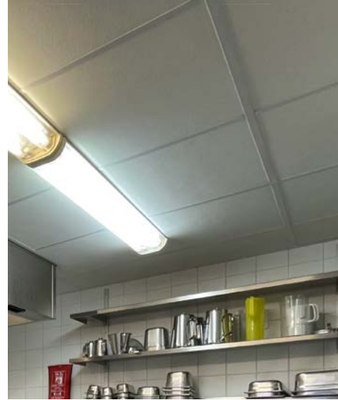
Keittiön alakatto on ripustettu teräskannattiin.
