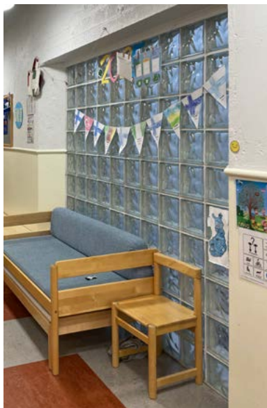
Toisen kerroksen seinän lasitiili aukot.
