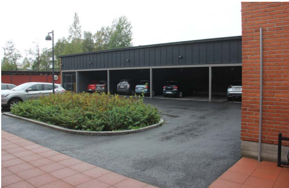
Näkymä ulkorakennuksen ja päiväkodin välisestä solasta kohti autokatosta.
