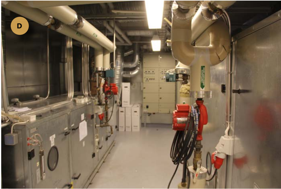
Ilmanvaihtokonehuone rakennettiin vuonna 1998 entisen hitsaamon yläosaan. Huoneelle tehtiin välipohjalaatta ja väliseinät.
