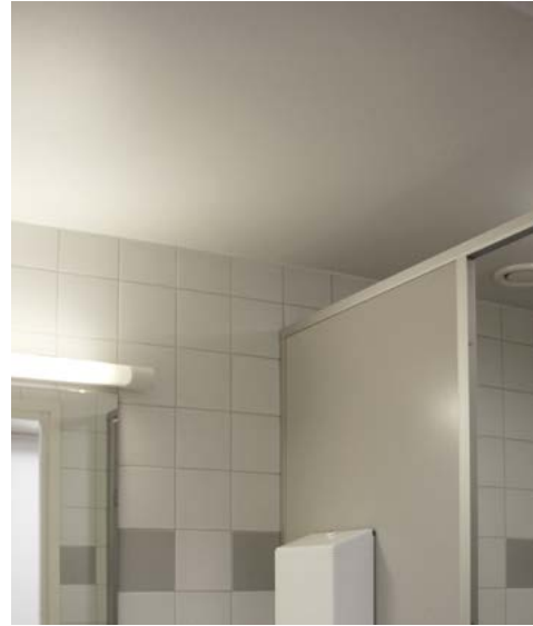
Aputiloissa, tuulikaapeissa ja saniteettitiloissa on maalatut kipsilevykatot.
