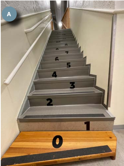
Porras nousee toisen kerroksen käytävään. Ensimmäinen askel on tehty puusta.
