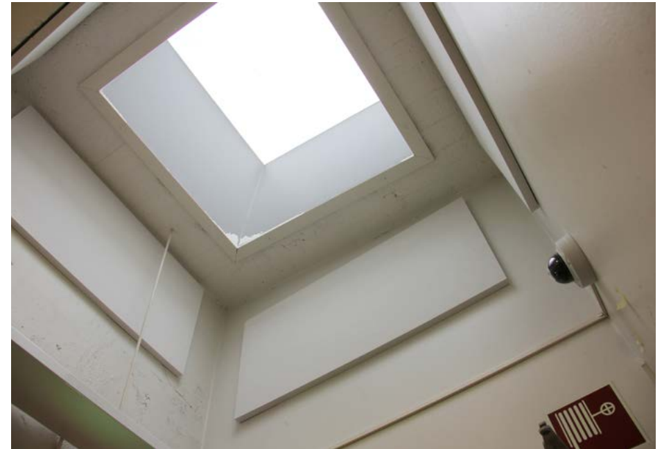
Toisen kerroksen käytävän kattoikkuna.
