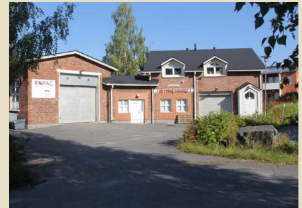
Entinen veturitalli ja autokorjaamo ovat uusiokäytössä.
