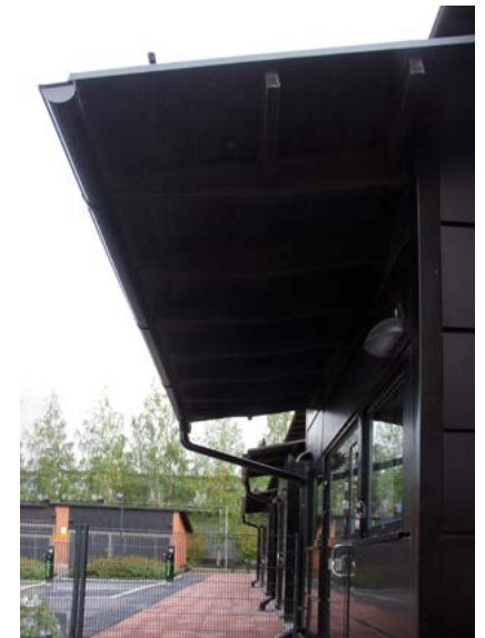
VASEMMMALA: Sadevesi ohjautuu suoraan maanalaiseen hulevesiverkkoon.
