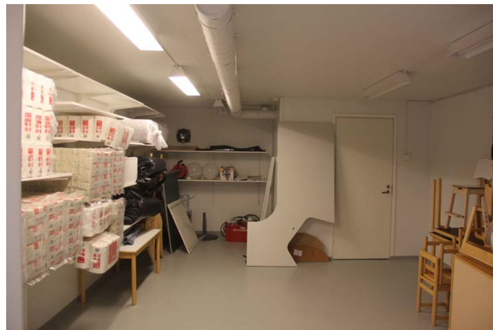
Suojatilan laitteet on sijoitettu perällä näkyvään komeroon.
