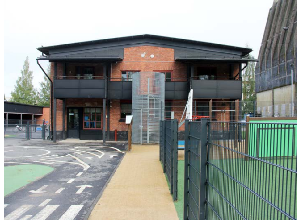
Päätyjulkisivu länteen. Pääty on tehty vuonna 1958 ja sen nykyinen aukotus ja parvekkeet ovat vuodelta 1998. Parvekkeita yhdistävä kulkusilta ja kierreporras ovat vuoden 2006 lisäyksiä.
