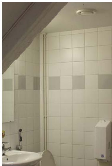
Saniteettitiloissa ja keittiössä on valkoinen laatoitus, jossa on harmaita tehostelaattoja.
