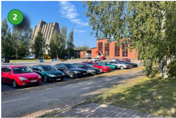
Näkymä etelästä pysäköintialueen yli kohti siiloa.
