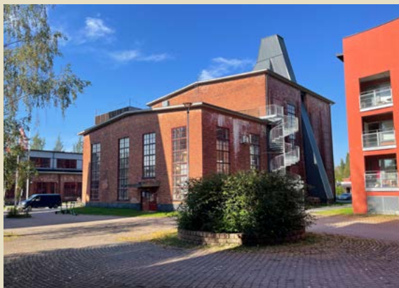
Entinen voimalarakennus toimii kiipeilykeskuksena.
