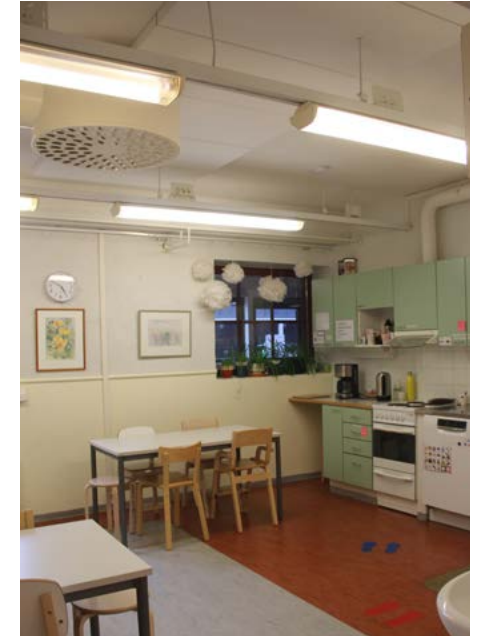
Kerhuhuoneessa ja keittiössä on kiskoihin asennetut jonovalaisimet.
