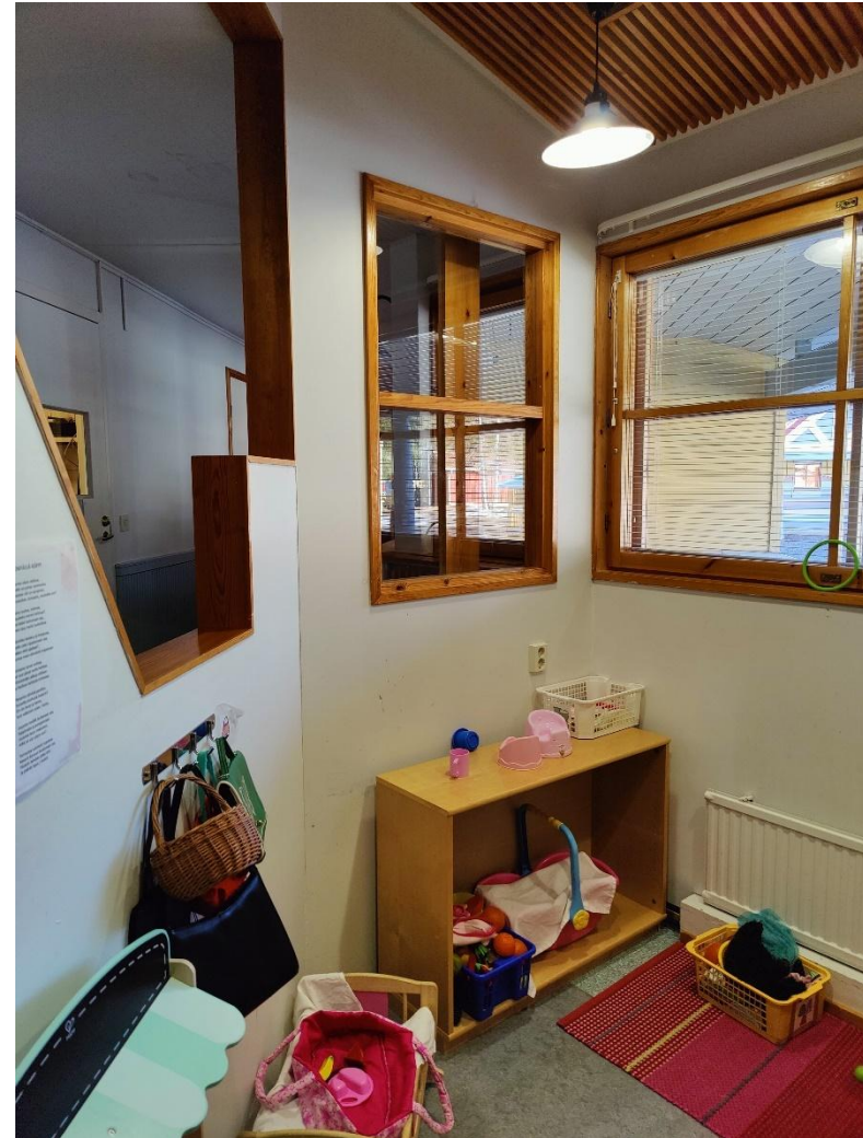
Kuva 83. Sisätilat sisältävät paljon yksityiskohtia, tässä kuvassa näkyy sisäseinään rakennettu monimuotoinen aukko. Puurimaa on käytetty sisäkattopinnassa. Ikkunat ovat ruutuikkunoita.
