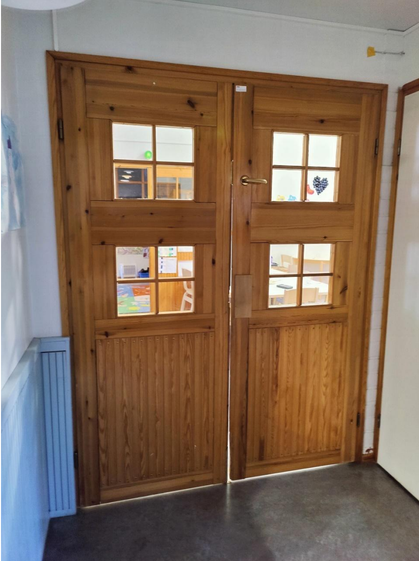
Kuva 78. Päiväkodin sisäovet ovat puisia ja niissä on muun muassa ruutu-ikkunoita.
