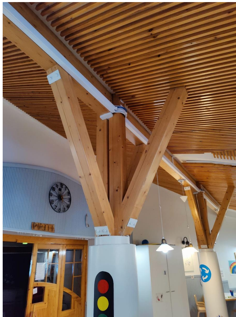
Kuva 39. Pääaulan mastoa muistuttavia liimapuisia pilareita keväällä 2026.
