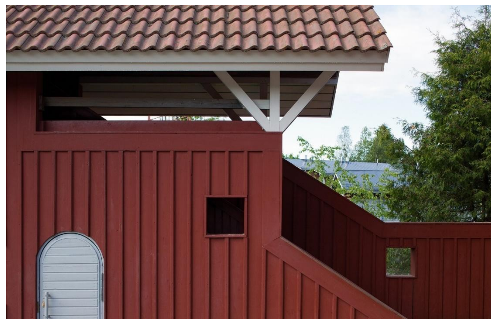
Kuva 47. Julkisivuote Saloilan päiväkodista. Kuva: Raimo Ahonen 2012.
