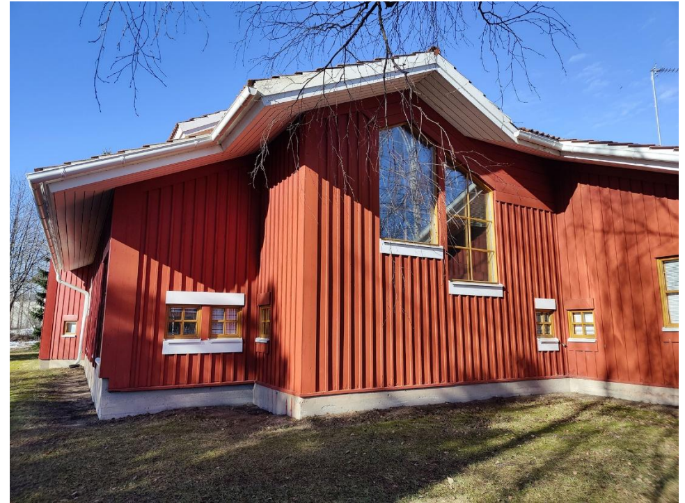
Kuva 55. Päiväkotirakennuksen pystylomalautaverhoiltujen julkisivujen pääväri on punainen. Ikkunoiden karmit ovat puuta. Sekä julkisivu, että katto polveilevat luoden vaihtelevaa massoittelevaa. Valkoinen väri toimii tehosteena sekä ikkunoiden kohdalla että räystäissä.
