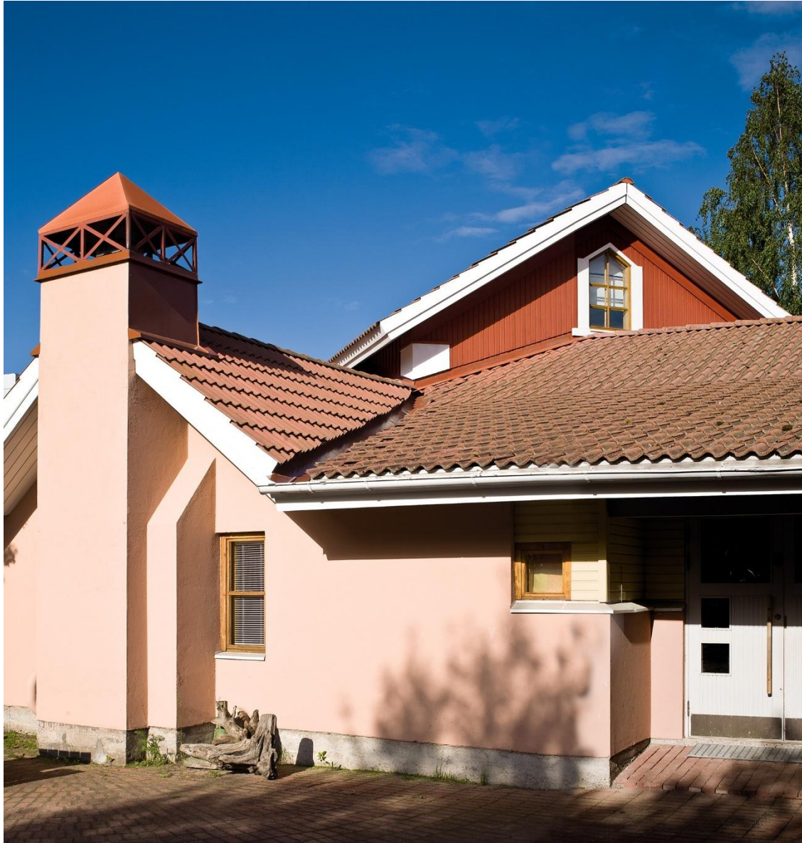
Kuva 52. Päiväkodin rapattua julkisivupintaa takahuoneen kohdalla. Tässä kohtaa rakennusta katto on erittäin monimuotoinen sekä ikkunat ja ovet ovat keskenään erilaisia. Piipunhatun detalji sopii katon värimaailmaan ja massoitteeluun. Kuva: Raimo Ahonen 2012.
