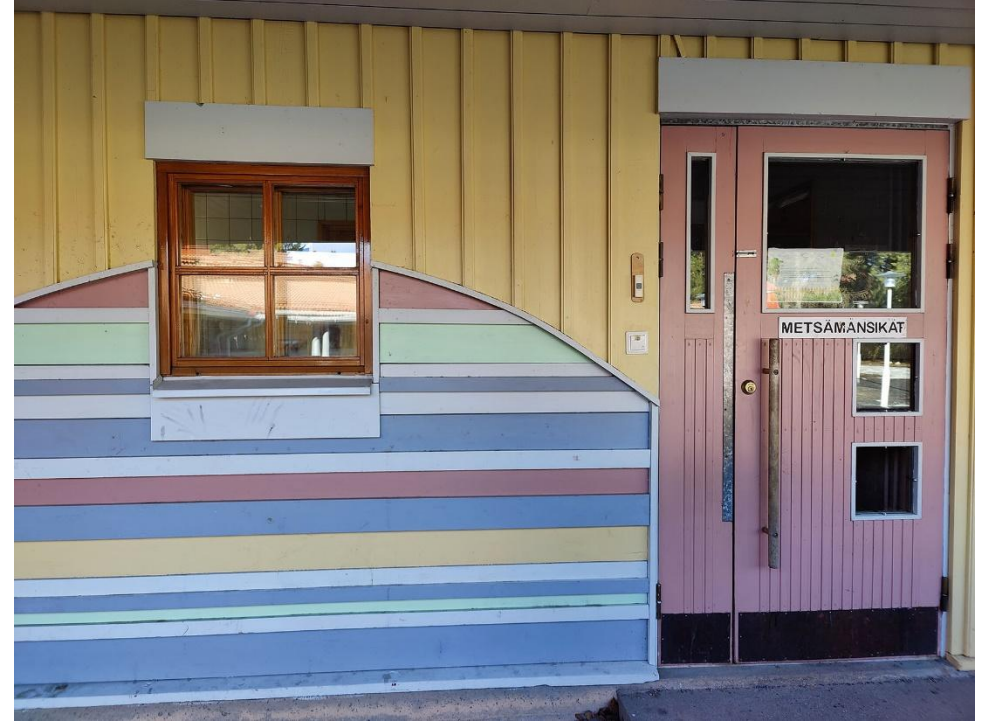
Kuva 57. Julkisivujen ne kohdat, joiden lähellä kuljetaan, on detaljoitu eri värein maalatuin vaakapaneelein. Ovessa on hauskoja matalalle sijoitettuja ikkunoita, joista pienempikin lapsi näkee suoraan ulos.
