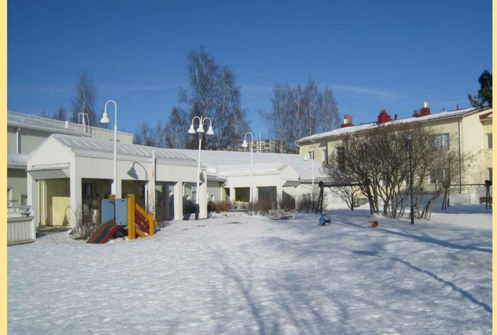
Kuva 85. Ainolan päiväkoti etelästä kuvattuna. Kuvassa oikealla näkyy vanha 1964 valmistunut päiväkoti. Lähde: Ainolan päiväkoti, Oulu, Rakennuksen ominaispiirteiden selvitys s. 23.
