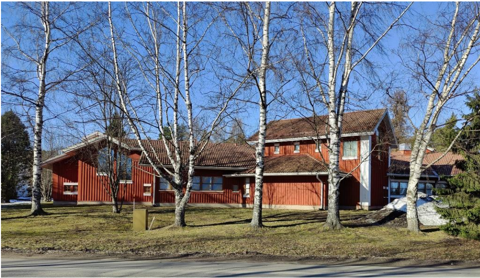
Kuva 3. Päiväkodin julkisivut ja kattomaailma ovat moninaiset ja vaihtelevat. Ympäristön suuntaan julkisivuissa korostuu punainen sävy.
