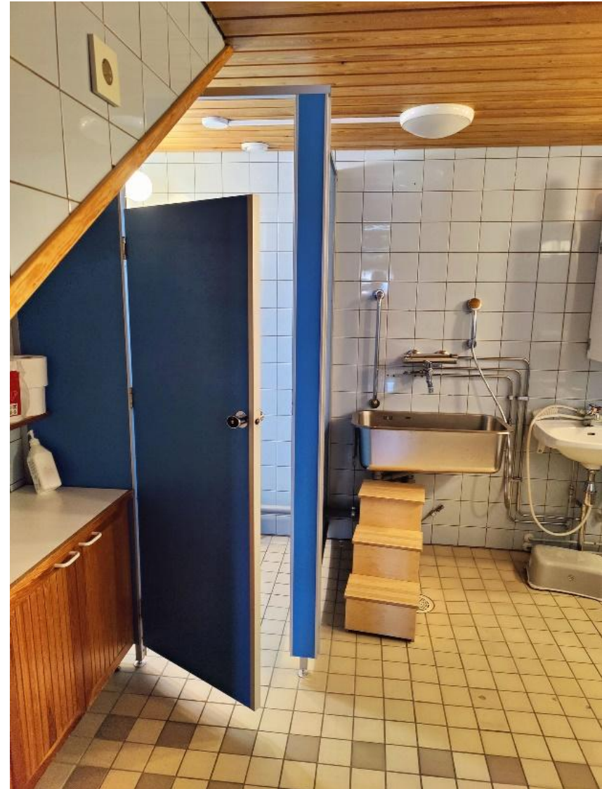
Kuva 77. Saniteettitila ryhmähuoneen 56 vieressä.
