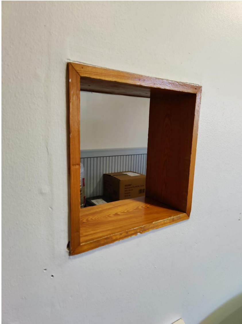
Kuva 80. Saloilan päiväkodissa on paljon pieniä kurkistusaukkoja, joissa on puukehykset.
