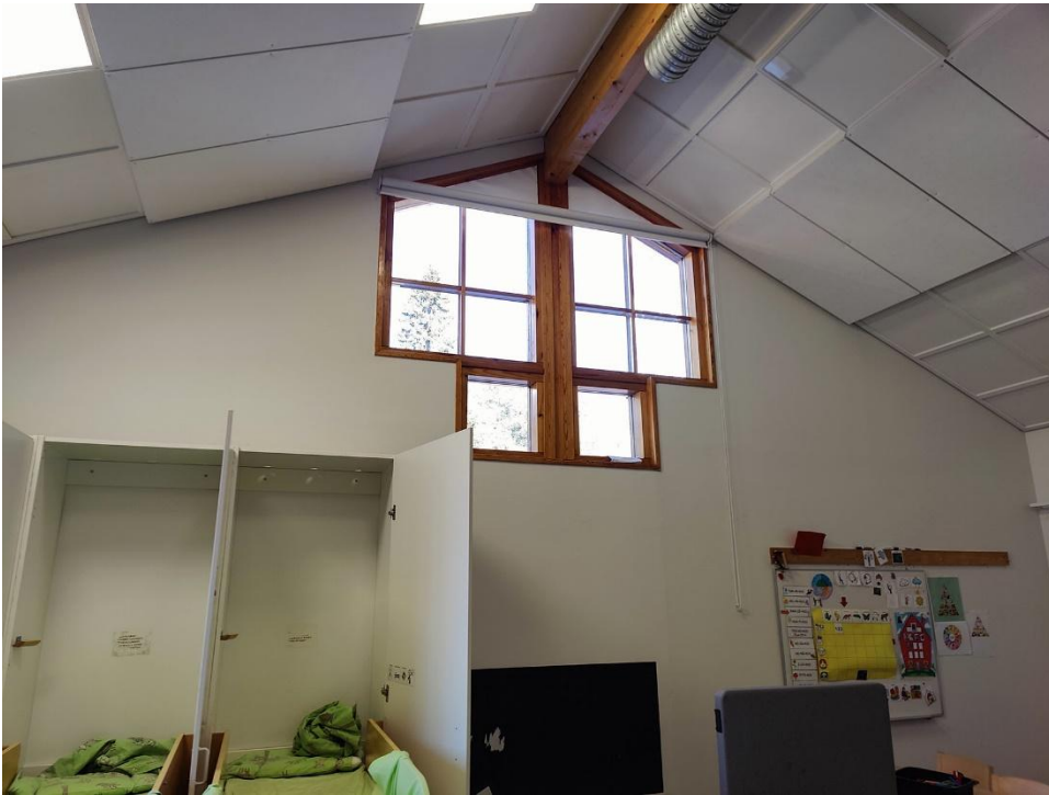
Kuva 65. Leikki- ja lepo huoneen puiset ikkunat ovat monimuotoiset. Liimapuupalkin yhteydessä on sinkitty ilmanvaihtokanava.
