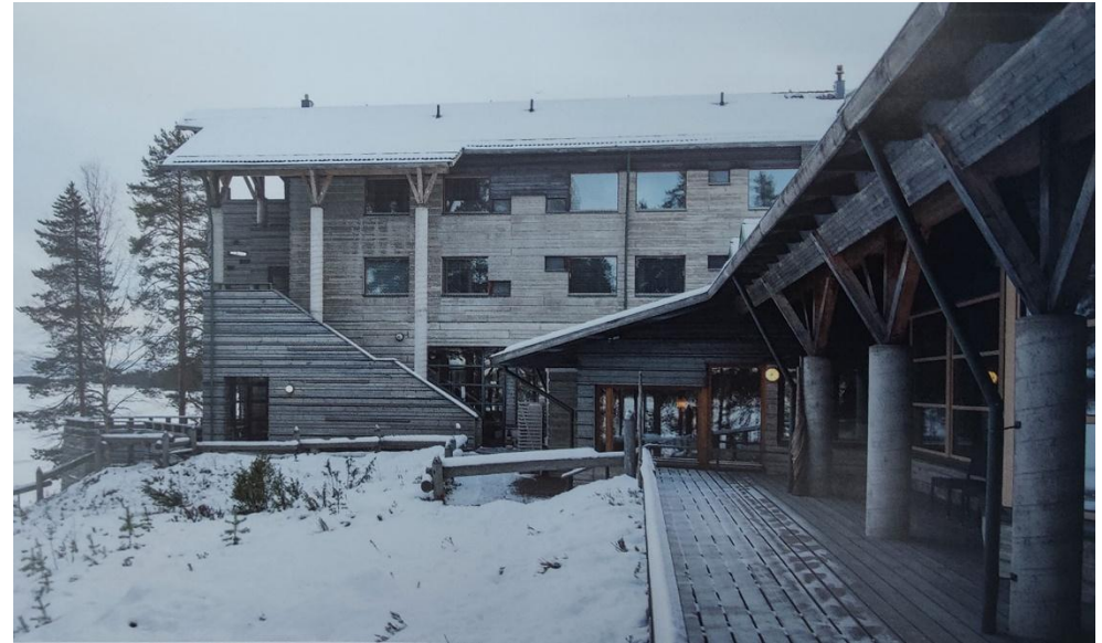
Kuva 24. Ilpo Väisänen: Hotelli Kalevala, Kuhmo, 1986–1989. Lähde: Jälkikaikuja-kirja s. 18
