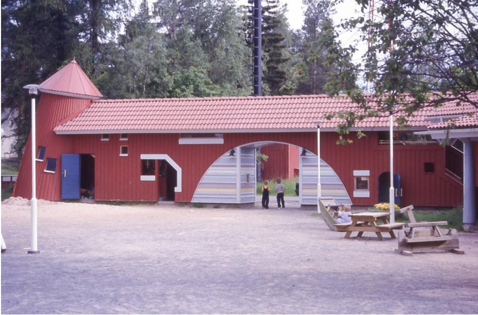
Kuva 28. Päiväkodin tunnusomainen porttirakennelma vastavalmistuneena, jonka kaariaihetta on elävöitetty väreillä. Julkisivuverhous on höylättyä punaista puuta. Päiväkodin pihalla kasvaa komeaa vanhaa puustoa. Lähde: Ilpo Väisäsen kuva-arkisto.
