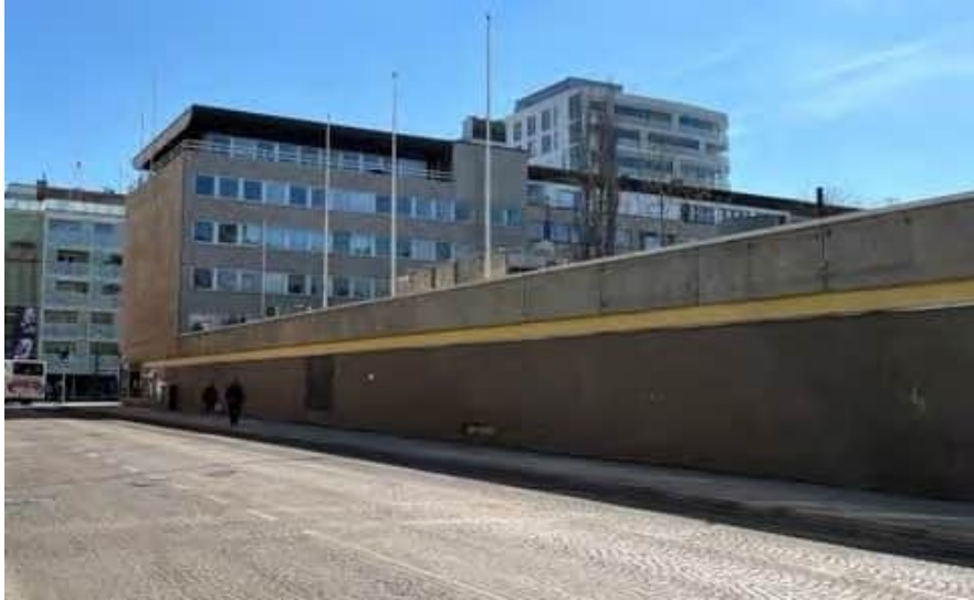
Kirkkokadun puolen toimisto-osan julkisivua sisäpihalle sekä Saaristonkadun julkisivu. (Arkkitehtitoimisto Laatio Oy)
