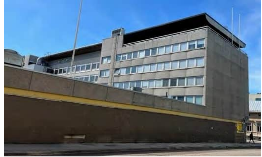
Torikadun puolen toimisto-osan julkisivua sisäpihalle ja Saaristonkadulle. (Arkkitehtitoimisto Laatio Oy)
