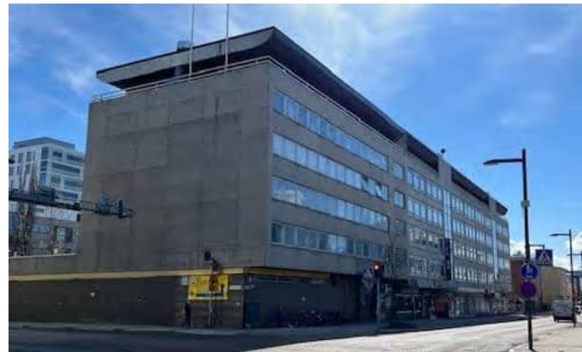
Torikadun puolen toimisto-osan julkisivua (Arkkitehtitoimisto Laatio Oy)
