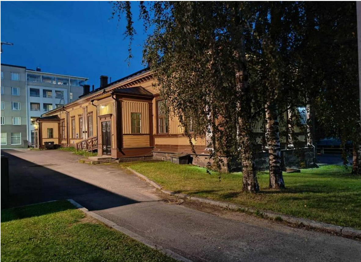
Kuva 11: Nykyisellään Kirkkotorin piha-alue Torikadun suunnasta katsottuna. Rakennus on omassa itsenäisessä arvossaan erillisenä kulttuurihistoriallisesti arvokkaana rakennuksena.
