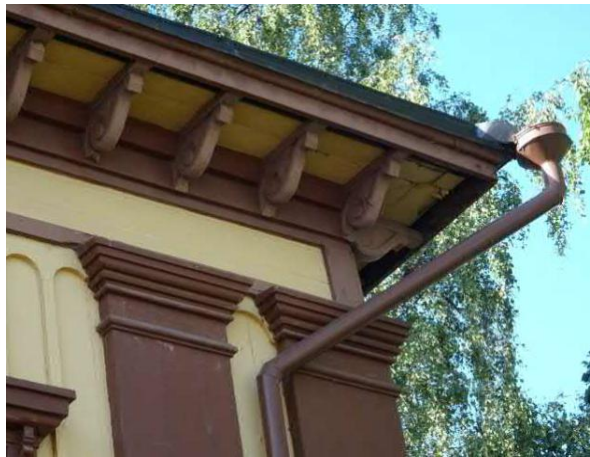
Kuva 16 Vasemmalla ote rakennushistoriaselvityksestä, vuoden 1978 perusparannuksen värisuunnitelmassa eriteltyt ulkovärit. Vasemmalla valokuva, jossa koristeelliset räystään aluslaudat, umpiräystään profiloidut konsolit ja nurkan kaksoispilasterien yläosat sekä vanha peltinen suppilo ja syöksytorvi.
