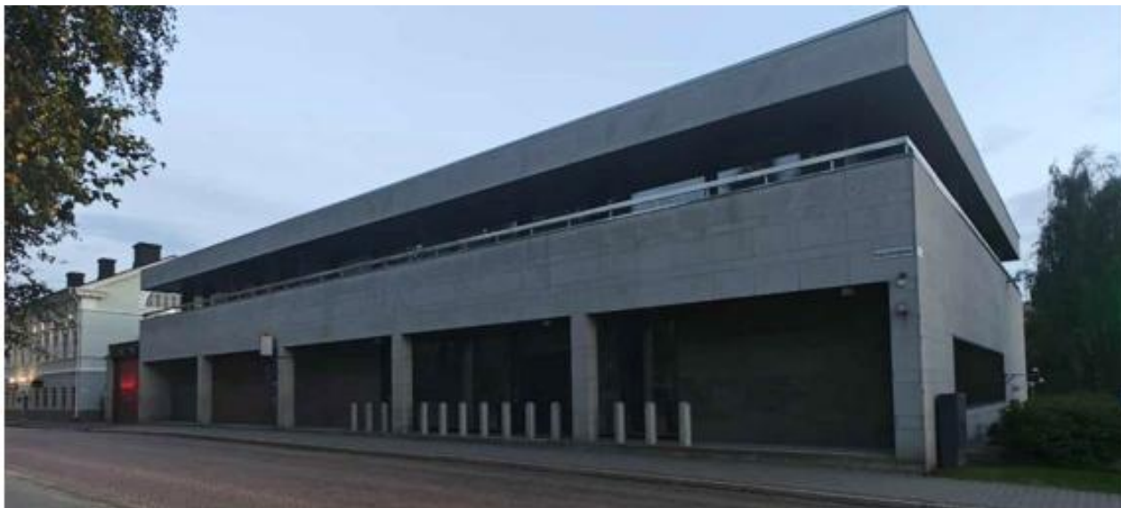
Kuva 7: Suomen Pankin rakennus Kajaaninkadun suunnasta. Suojellun rakennuksen ulkoisen olemuksen muuttamista ei tulisi edes harkita, sillä Suomen Pankin rakennusta voidaan pitää hyvin säilyneenä ja edustavana esimerkkinä toteutusaikansa tyypillisestä rationalistisesta arkkitehtuurista.
