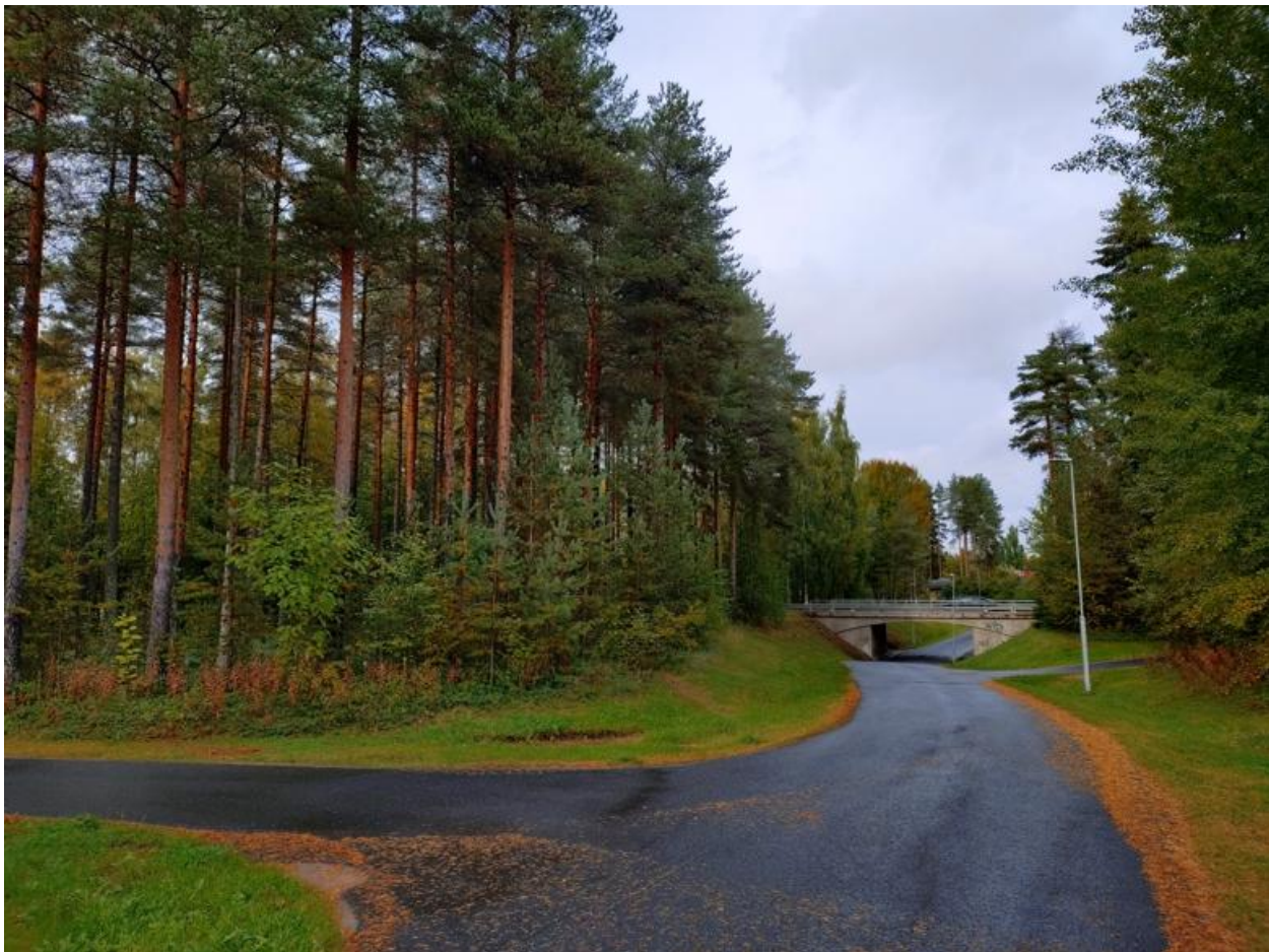
Kuvat: Näkymä Palokankaanpolulta Palokankaantien alikulkuun.
