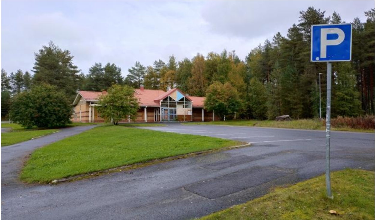
Kuva: Näkymä Sarasuontieltä pysäköintialueelle ja myymälärakennukseen.
