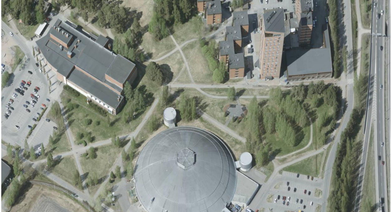
Kuva 9 Raksilan joukkoliikennereitin viheralueita vuoden 2024 viistokuvassa Ouluhallin, tulevan Vesiliikuntakeskuksen sekä Väikkylän alueen ympäristössä. Kuvan vasemmassa laidassa näkyy nyt jo purettu Raksilan uimahalli.
