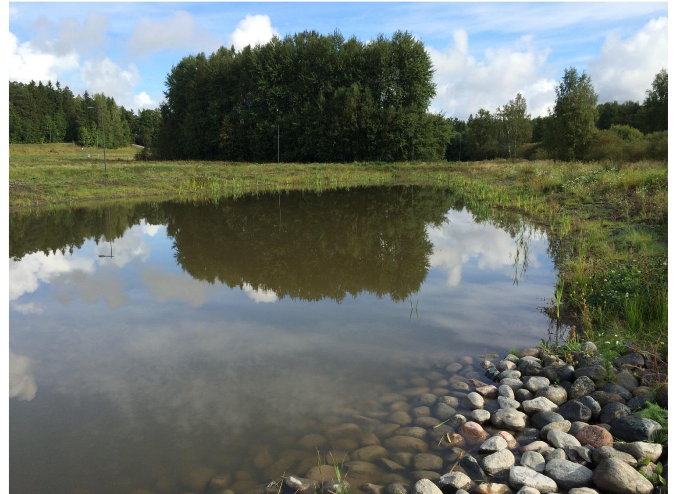
Kuva 11. Referenssikuva hulevesialtaasta Espoon Pellaksenmäessä. Altaassa käytetty eroosiosuojamattoman Greenfinin Covamat plus -siemeneroosiomattoa. Altaan pohja on rakennettu murskeesta ja pato luonnonkivistä. (Altaan suunnittelu ja valokuva: Sitowise Oy)
