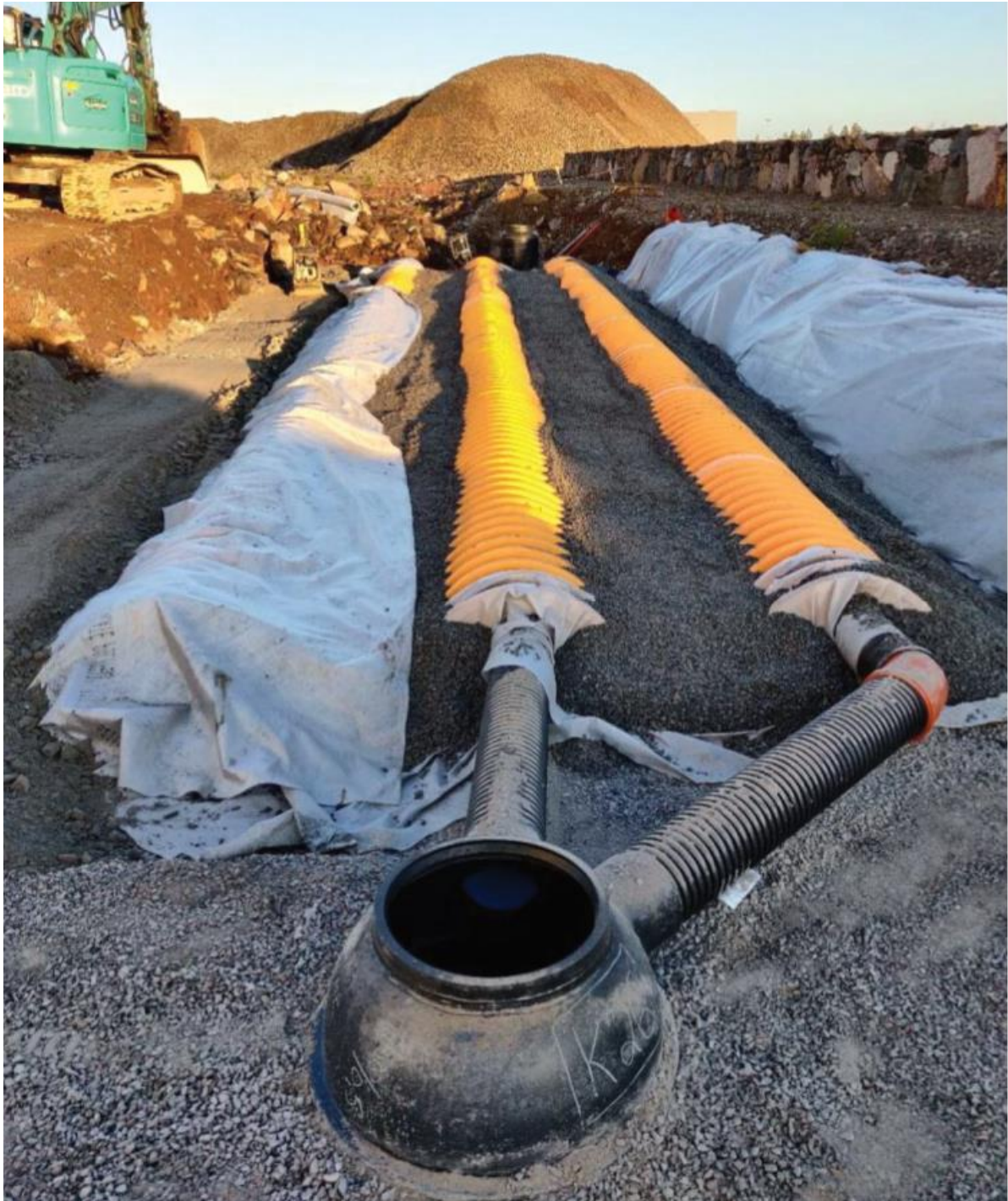
Kuva 6 Hulevesitunnelin periaate. Lähde: ViaCon Oy.
