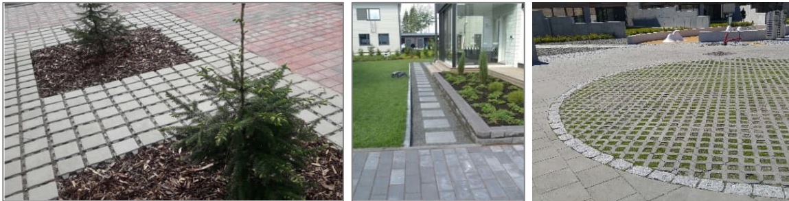
Kuva 10. Nurmikiviä sekä laatan ja sorapinnan yhdistämistä. Kuvat vasemmalta: Pihakivi.com, RudusPiha, Eija Toivonen.
