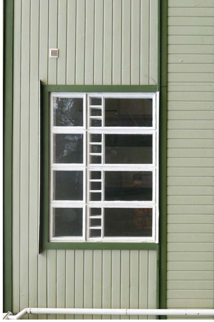
211. Ikkunat ovat alkuperäiset.
