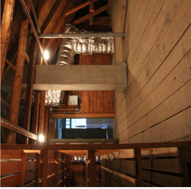
213. Ullakko on säästynyt suurilta muutoksilta.
