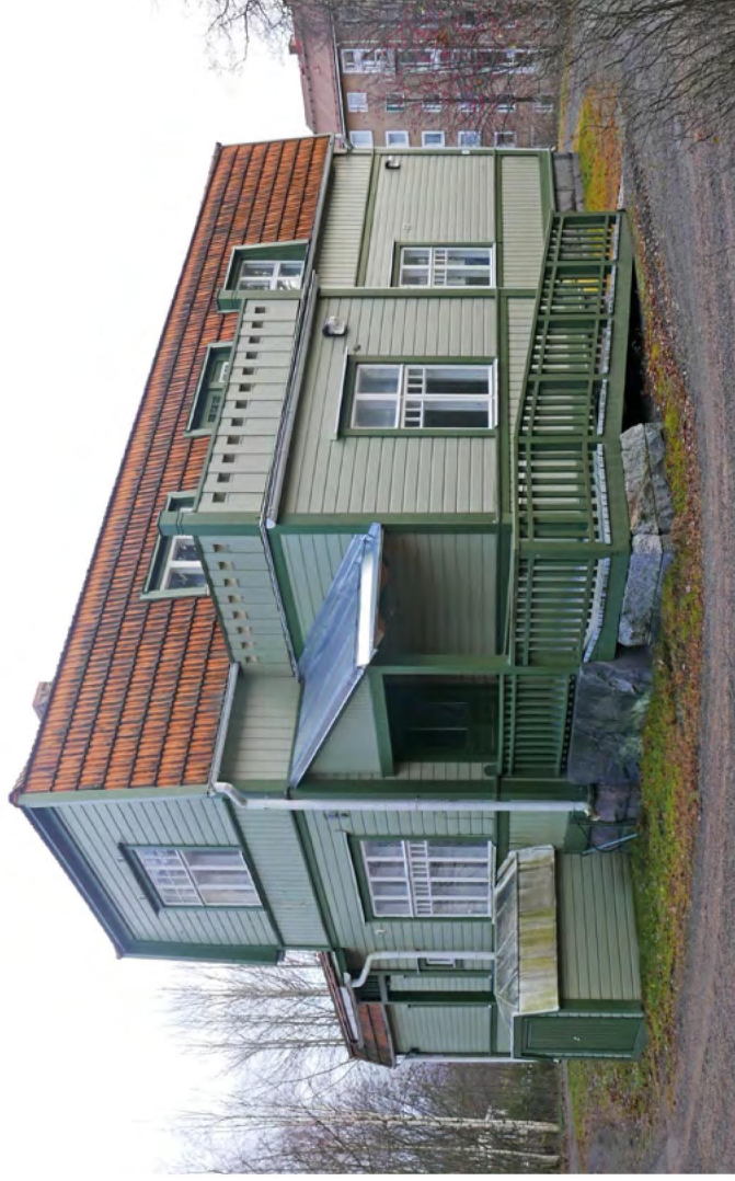
209. Länsisivulle on rakennettu pyörätuoliliiska 1988.
