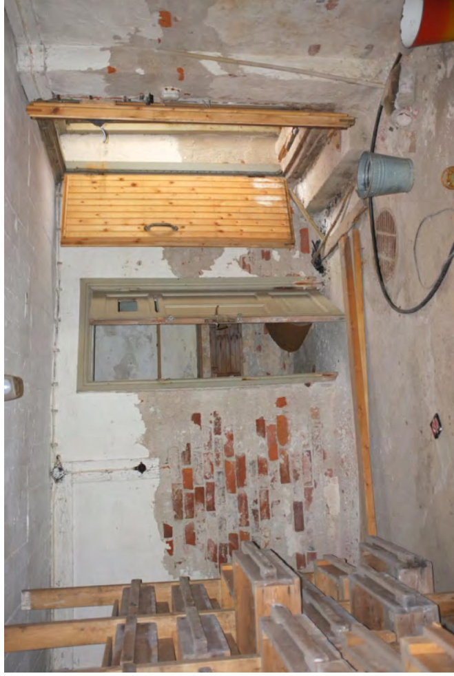
164. Rakennuksessa on vuonna 1937 rakennettu täysikokoinen kellarit, jonne on suora sisäänkäynti rakennuksen takaa. Kuva: Ida Mustajamaa
