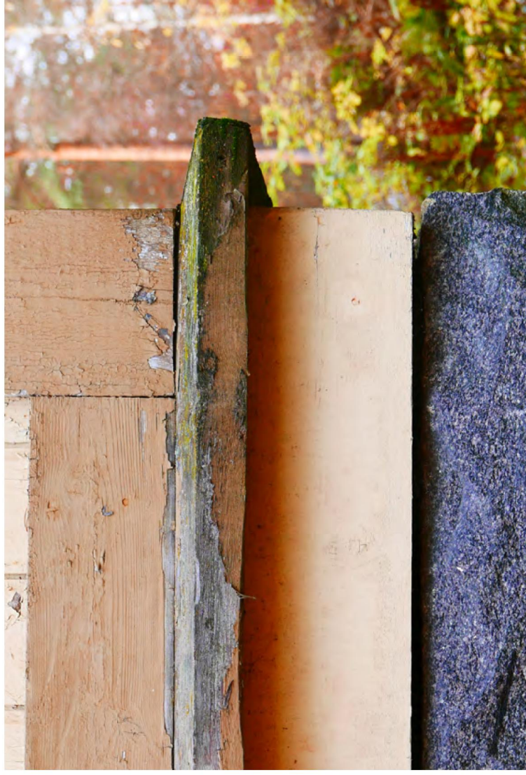
163. Yksityiskohta kivijalan ja puurungon liittoksesta.
